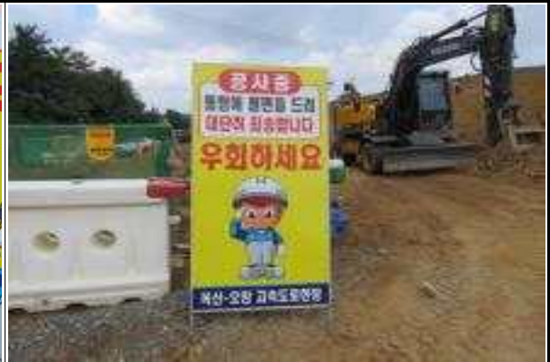
현장내 안전시설 설치상태 양호
