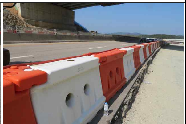
인접도로 주변 안전시설(PE방호벽) 설치 현황②
