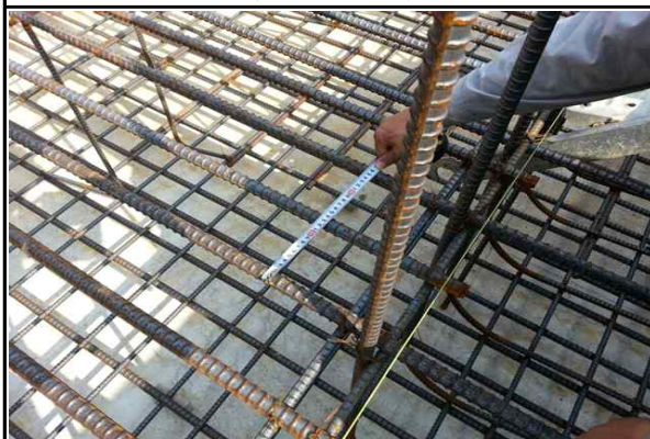
교대 A2 기초 철근배근간격 확인 전경 (2015.08.07)
