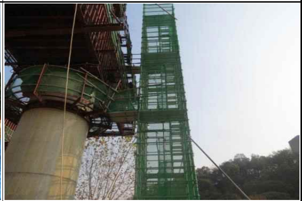
교각 위킹타워 설치·고정 상태 양호
