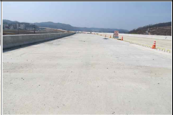
상부슬래브(오창방향) 시공 전경 (2017.04.07)
