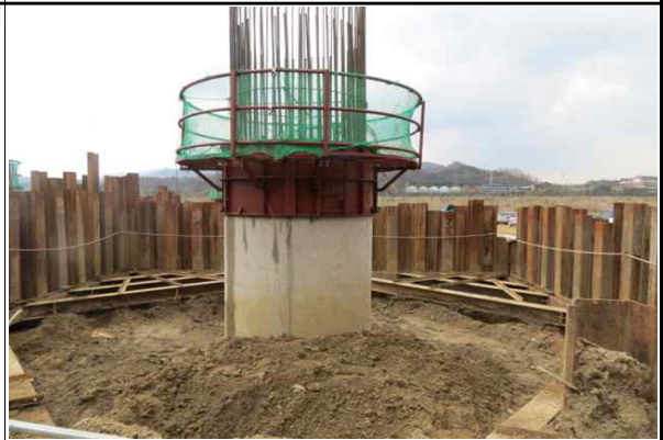
교각 P3(옥산) 시공 현황 (2015.04.07)
