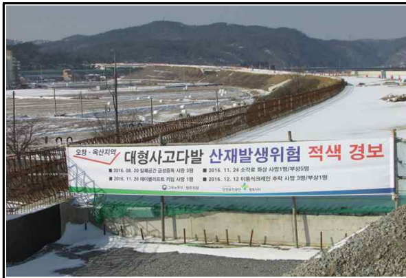
현장내 안전현수막 설치 현황
