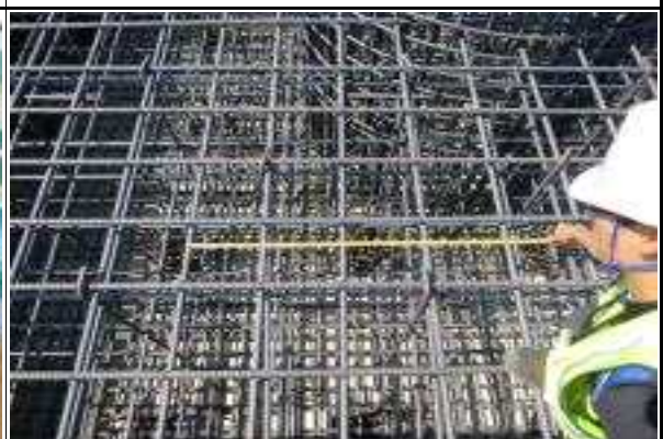
교각 P8 기초철근배근상태 실측 현황
