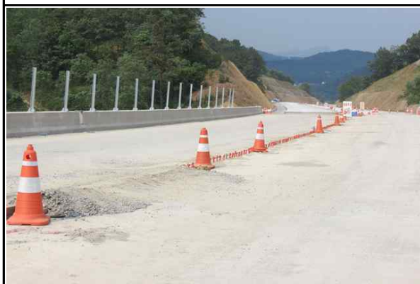
현장내 안전시설 설치 현황①
