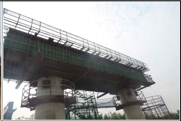
교각 P1 코팅부 강제거푸집 시공 전경 (2014.10.30)
