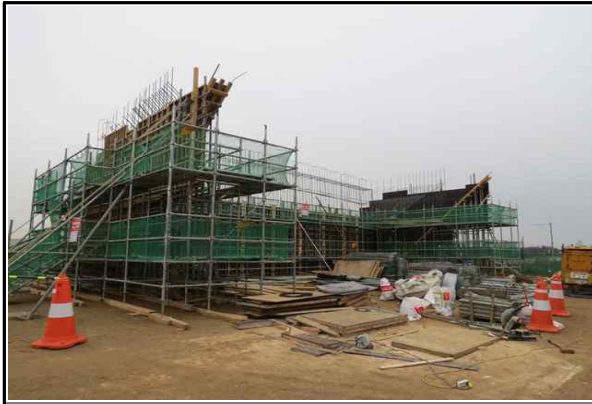
교대 A1 시공 전경 (2016.03.08)
