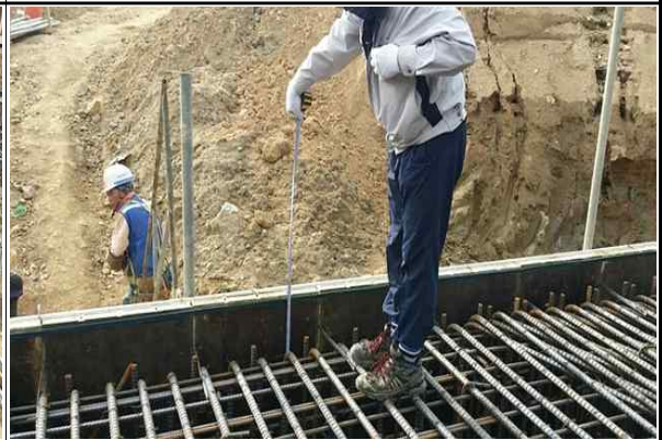
교대 A1(오창) 기초 저푸집 및 피복두께 실측 현황(2016.04.27)
