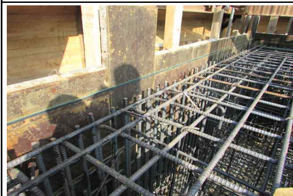
교각 P2 기초 거푸집 설치 상태①
