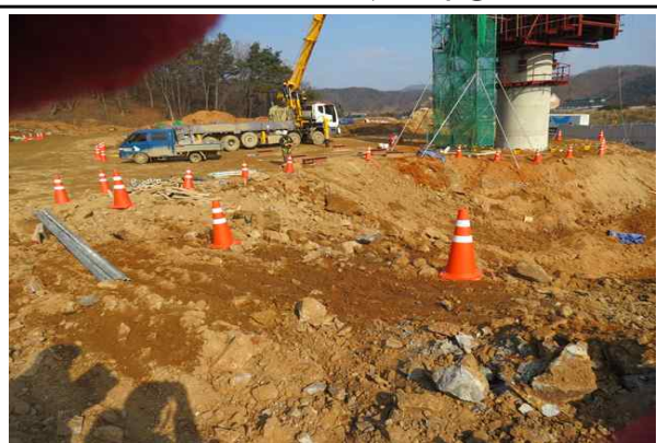
현장내 안전시설 설치 현황
