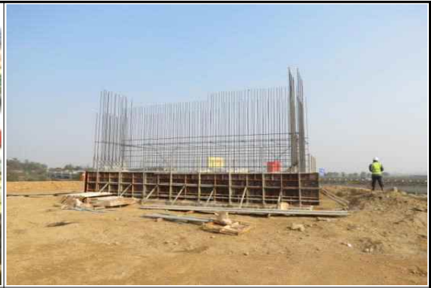
교대 A2 기초 시공현황
