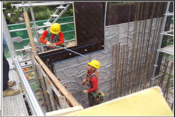
A2 거푸집 설치 상태 양호
