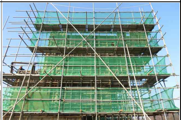
교대 A1 가설비계 설치 현황②
