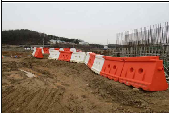
현장내 안전시설 설치 현황①
