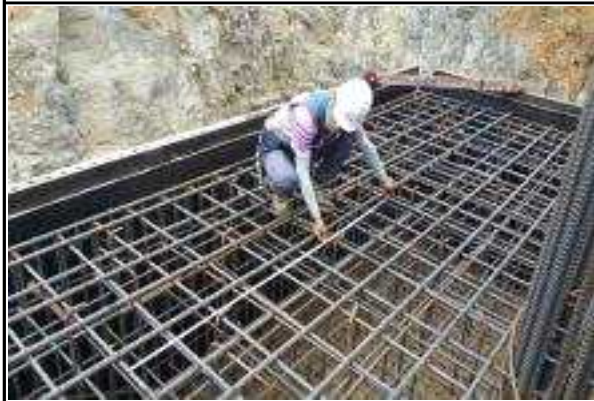
교각 P3 기초(오창) 철근배근간격 확인 전경 (2015.07.20)
