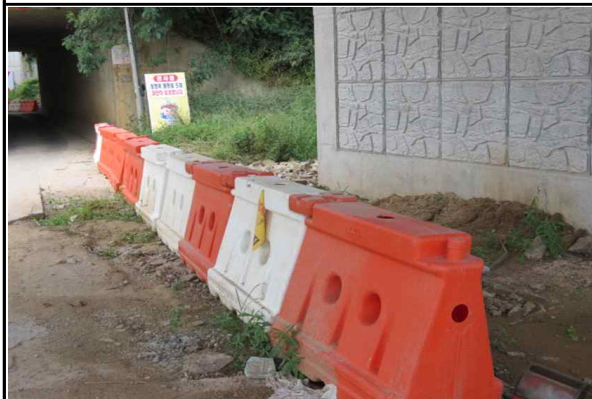
시점측 인접도로 주변 안전시설(PE드럼) 설치 현황
