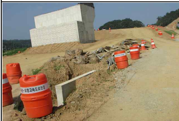
현장내 안전시설 설치 현황
