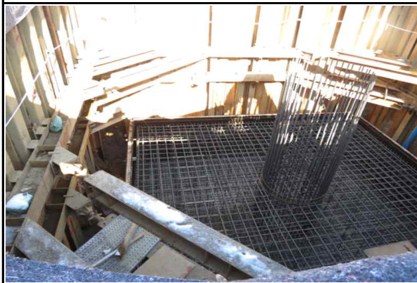
교각 P3 기초철근배근 현황
