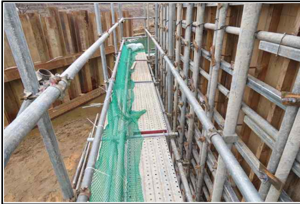
교대 A2 가설통로 설치 상태 양호②
