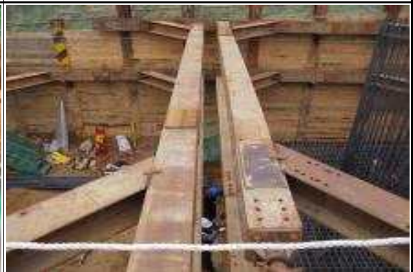
교각 P1 버팀보 + 잭 연결 상태 양호
