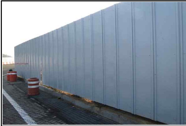
현장 인접도로 주변 안전휀스 설치 현황
