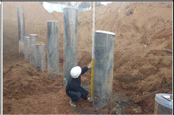
교대 A2 내부굴착강관말뚝 검측 현황② (2016.11.28)
