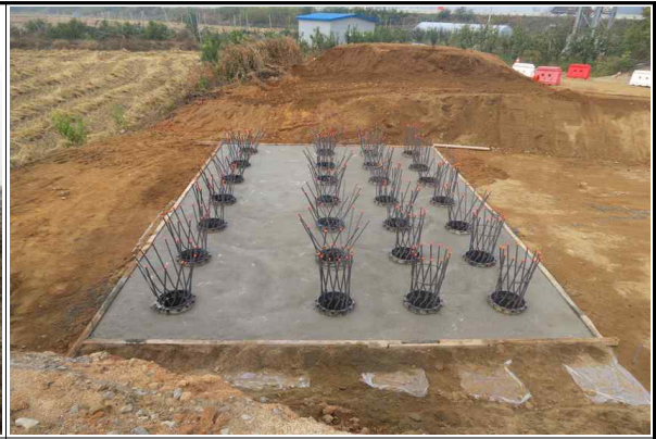
교대 A1 매입강관말뚝 시공 현황
