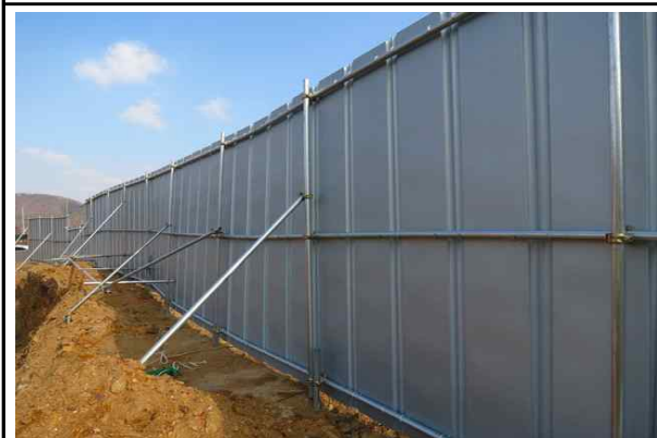
안전휀스 설치 및 고정상태 양호①
