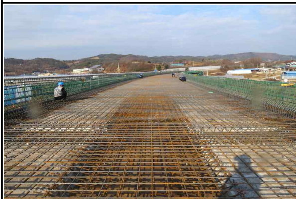
상부슬래브 철근배근 현황 (2015.12.11)
