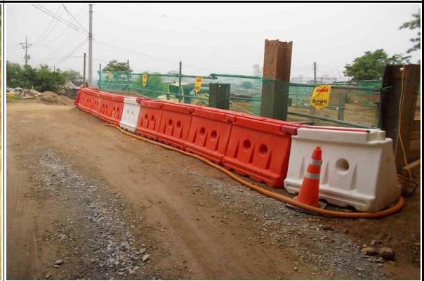
교각 P2 주변 인접도로 안전시설 설치 현황
