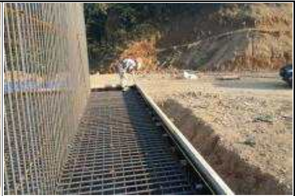
교대 A1 기초(옥산) 콘크리트 타설 전 거푸집 제원 실측 전경(2015.08.27)
