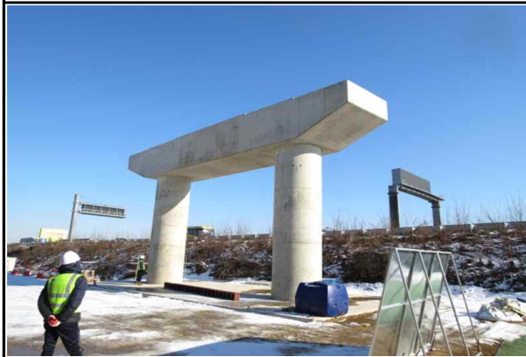
교각 P1 시공 전경 (2014.12.18)
