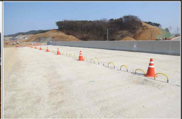
현장내 안전시설 설치 현황②
