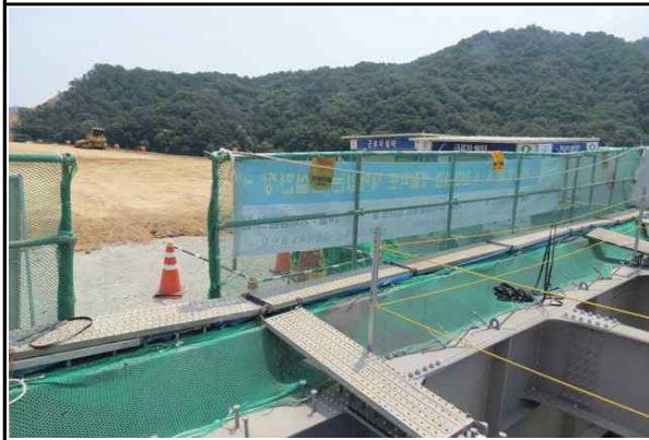
안전난간 설치 및 고정상태 양호
