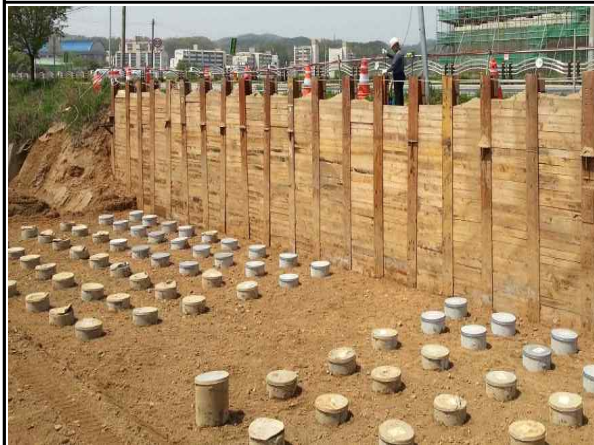
교각 P1 흙막이 가시설 시공 현황①
