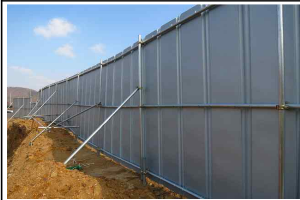
안전휀스 설치 및 고정상태 양호①
