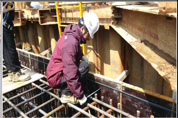
교각 P1(옥산) 기초 피복두께 실측 현황 (2015.04.02)
