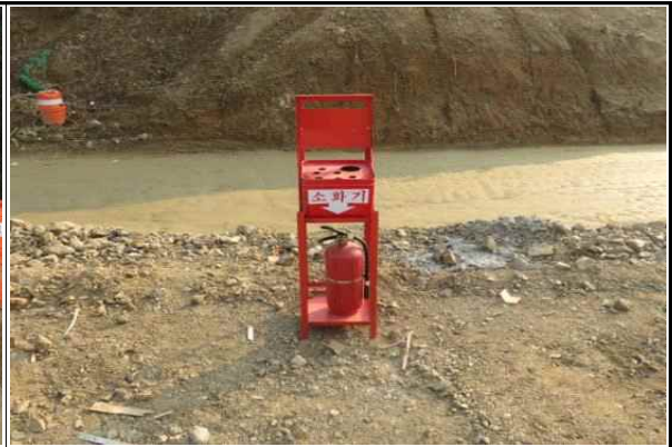
현장내 소화기 배치 현황
