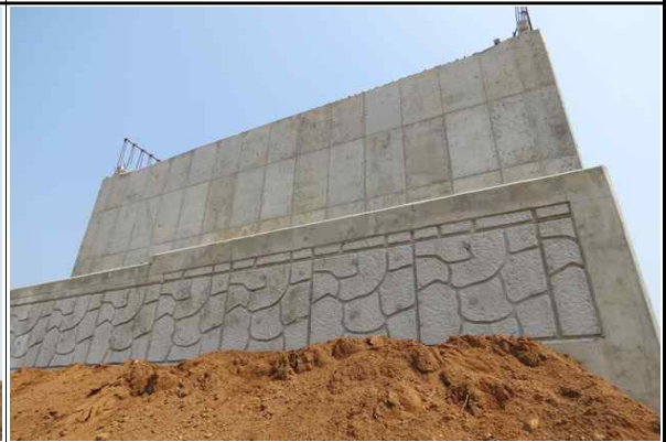
교대 A1 시공 전경② (2017.04.07)
