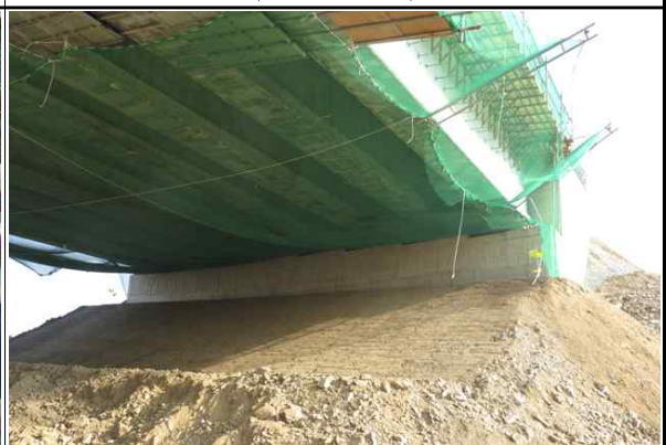
교대 A2 시공 전경 (2017.01.03)
