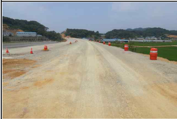
현장내 안전시설 설치상태 양호③
