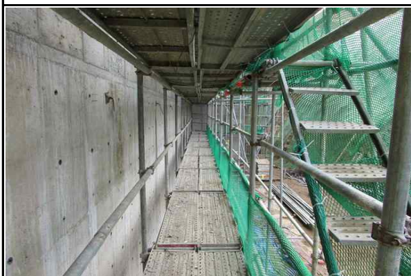
교대 A1 가설통로 설치 및 고정상태 양호
