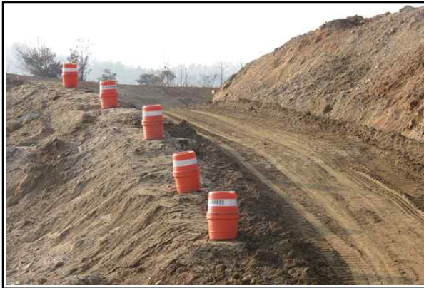
현장내 안전시설 설치 현황①
