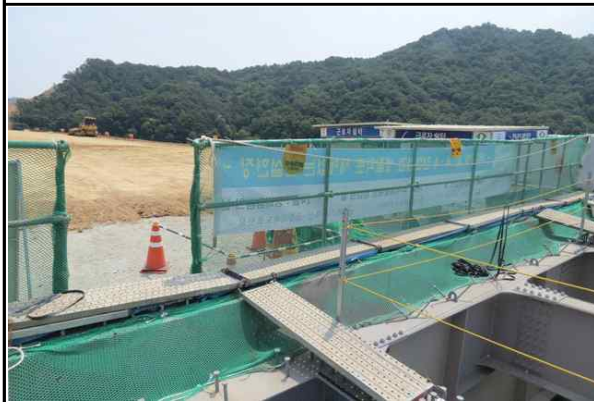
안전난간 설치 및 고정상태 양호
