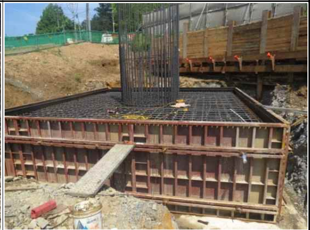
교각 P2 기초(옥산) 거푸집 시공 현황
