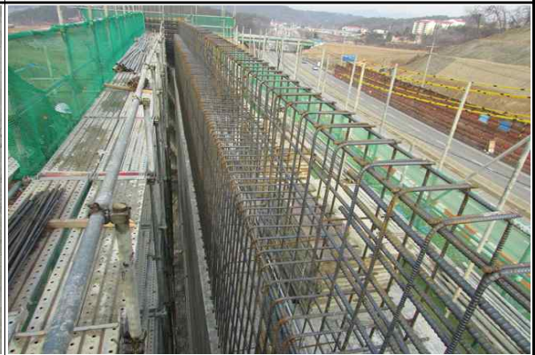
교대 A1 홍벽부 철근배근 현황 (2016.12.13)
