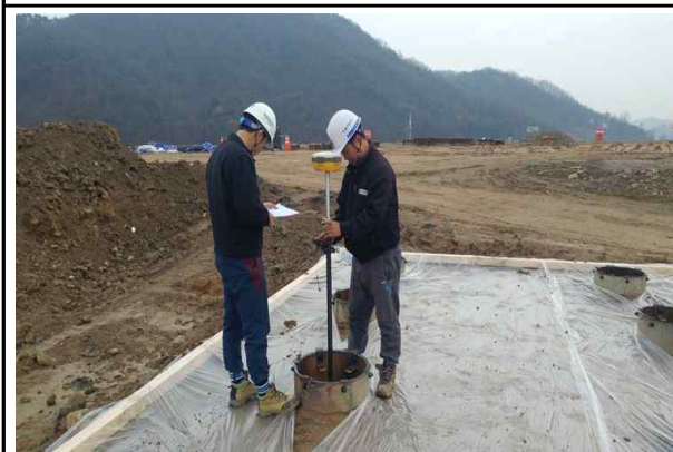
교대 A2 내부굴착강관말뚝 검측 현황① (2016.11.14.)
