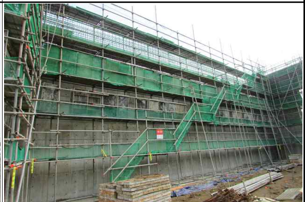
교대 A1 가설비계 설치 현황②
