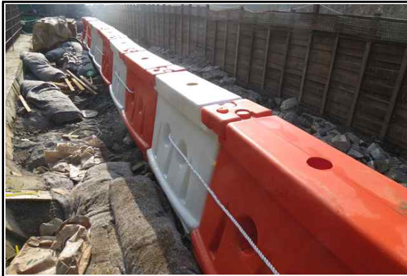
교대 A2 작업장 주변 안전시설(PE방호벽) 설치 현황①
