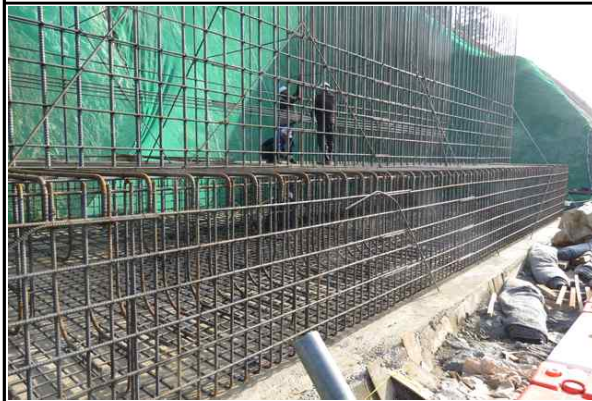
교대 A2 기초 시공 전경② (2017.01.03)
