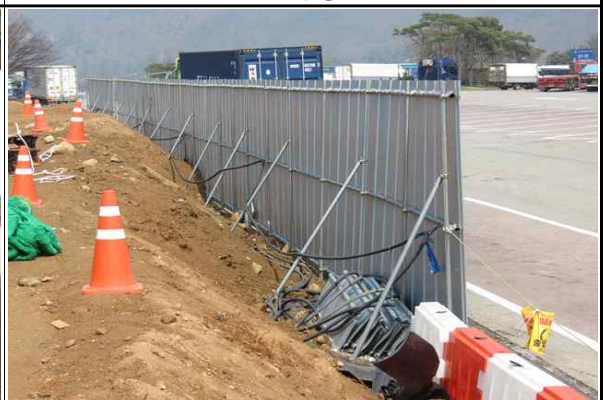
현장 인접도로 주변 안전휀스 설치 현황②
