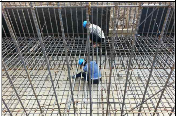
교대 A2 기초(오창) 철근배근 시공 현황 (2015.08.07)
