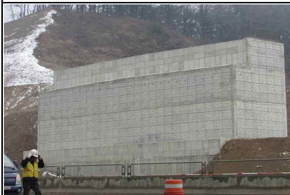
교대 A1 시공 전경 (2017.01.12)
