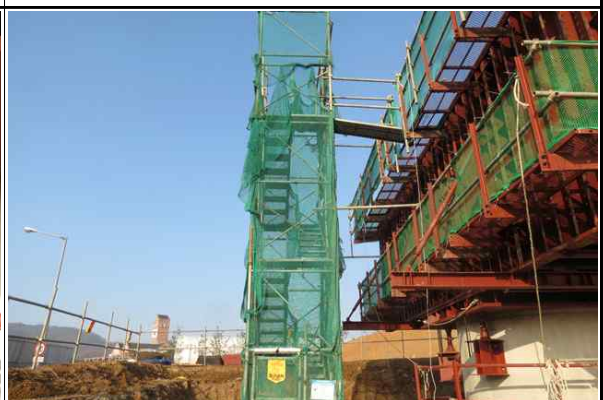
교각 P1 위킹타워 설치 상태 양호
