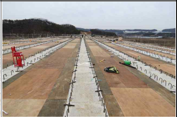
상부 바닥판 거푸집 시공 전경 (16.03.08)
