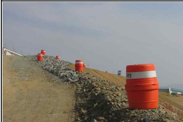
공사현장내 안전시설(PE드럼) 설치 현황
