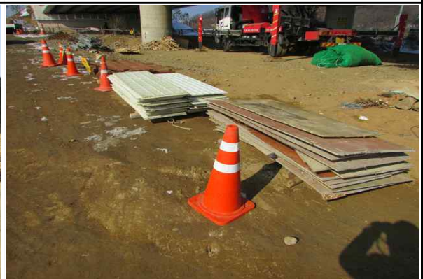
현장내 안전시설(라바콘) 설치 현황
