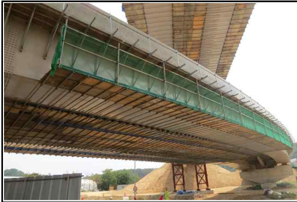
상부 추락방지망 설치 현황③
