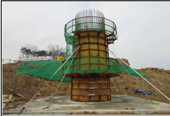
교각 P2 기둥부 강재거푸집 설치 상태①
