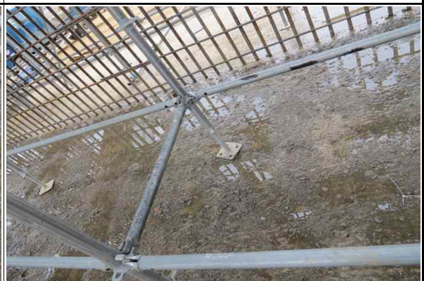
교대 A1 신·구 콘크리트 접합부 치핑상태 양호② (16.03.08)
