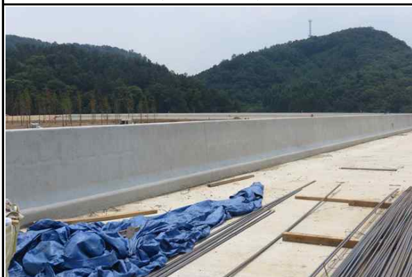
방호벽 시공상태 양호① (2017.06.21)
