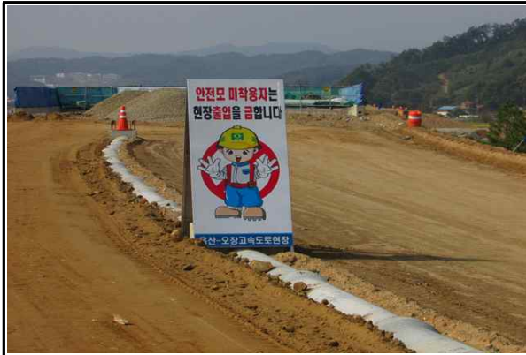
현장내 안전간판 설치 현황①
