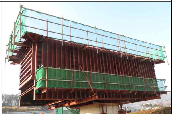
교각 P1 두부 강재거푸집 설치 현황
