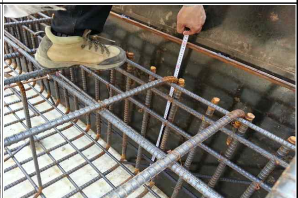
교대 A2 기초 콘크리트 타설 전 거푸집 제원 실측 전경(2015.08.07)
