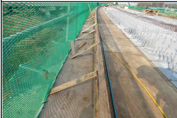
바닥판 캔틸레버부 거푸집 시공 현황 (2015.11.03)
