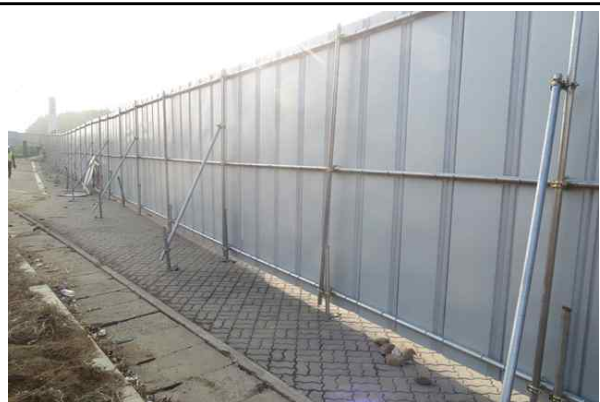
안전휀스 설치 및 고정상태 양호②
