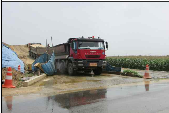
현장 진출입로 세륜기 설치 및 운용 현황
