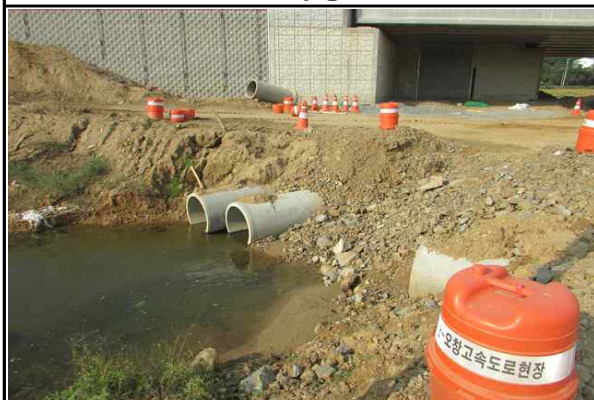
현장내 가설도로 및 임시배수관 시공 현황③
