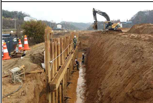
흙막이(쉴트파일) 가시설 시공 현황①
