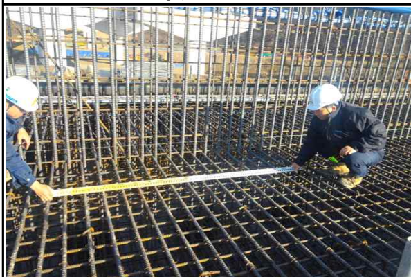
교대 A1(오창) 기초 철근배근간격 실측 현황(2015.12.06)
