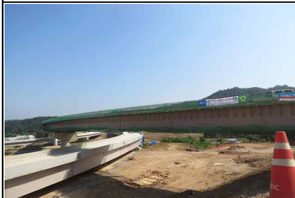
S1~S3 상부 시공 전경 (2017.09.26)
