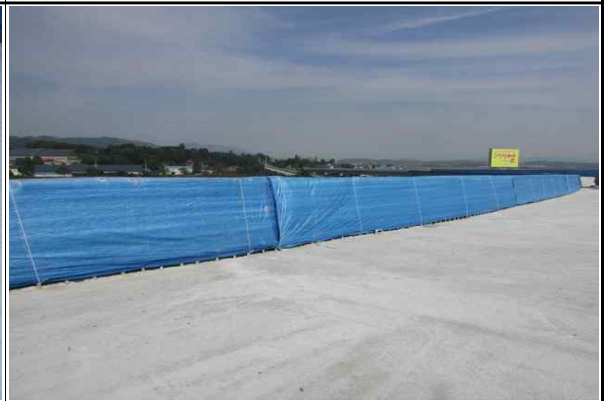
상부 노출철근 보호덮개 설치 현황 (2016.10.11)
