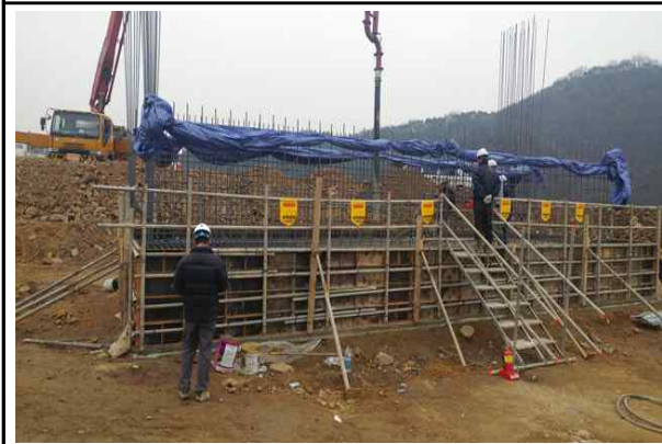
교대 A2 기초 거푸집 설치 상태
