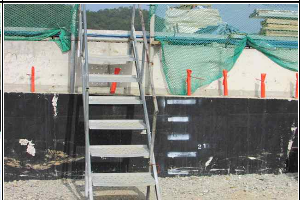
상부 진입을 위한 가설계단 설치 현황②
