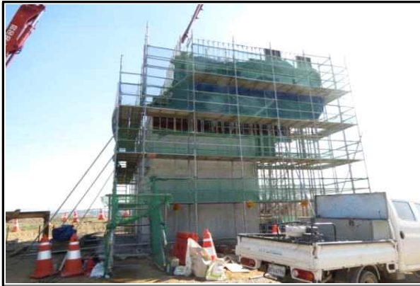
교대 A1 거푸집 설치 상태 양호
