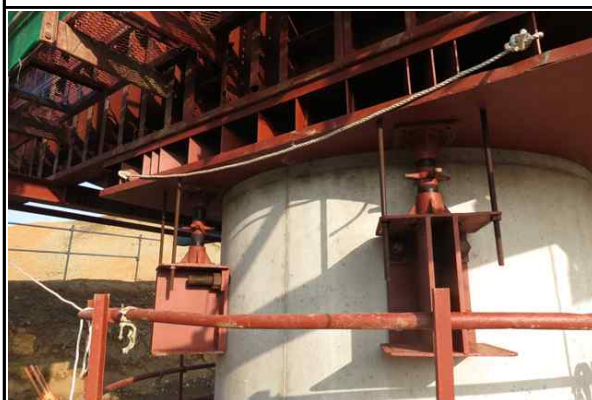
교각 P1 강재거푸집 설치 상태 양호
