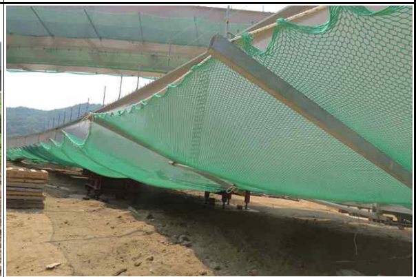
상부 낙하물방지망 설치 상태양호
