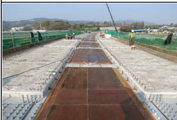
바닥판 거푸집 설치 현황
