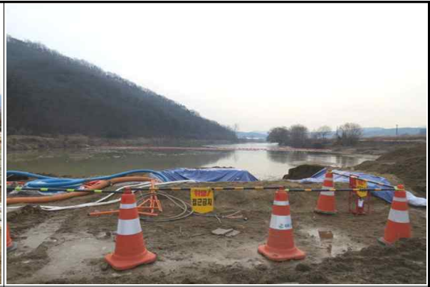
공사장 주변 안전시설 설치 현황
