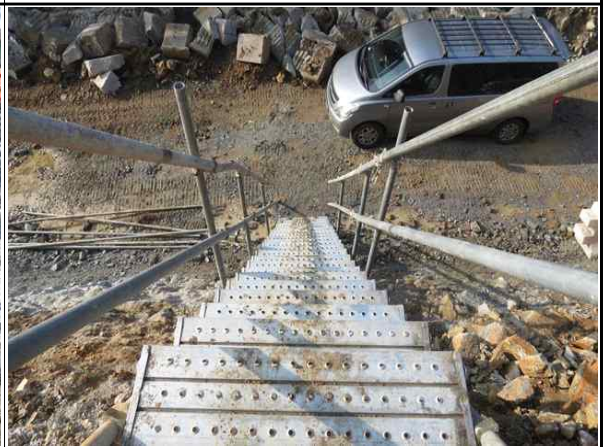
가설계단 설치 및 고정 상태 양호
