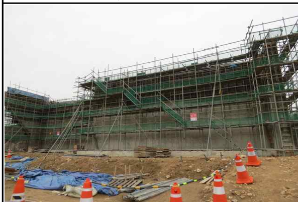
교대 A1(양방향) 시공 현황① (2016.03.08)
