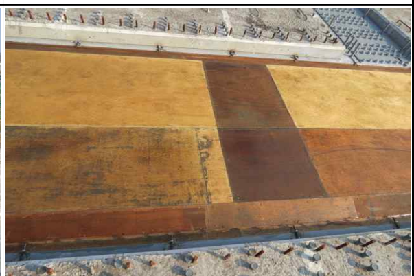
바닥판 거푸집 설치 및 고정상태 양호
