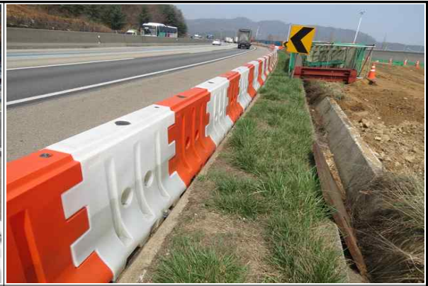
현장인접도로 주변 PE방호벽 설치 현황②
