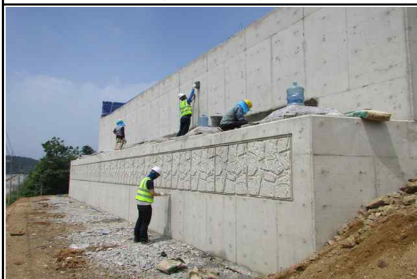
교대 A2 시공 현황① (2016.06.13)
