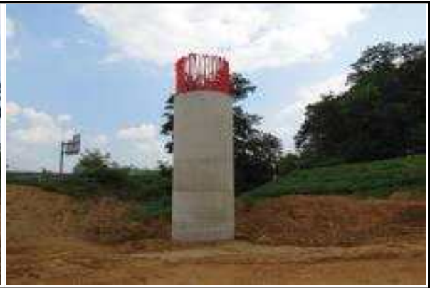
교각 P1(오창) 시공 현황 (2015.09)
