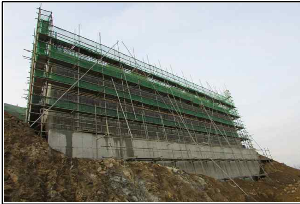
교대 A1 시공 전경① (2016.12.13)
