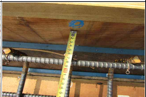
상부슬래브 피복두께 확인 (2016.06.13)
