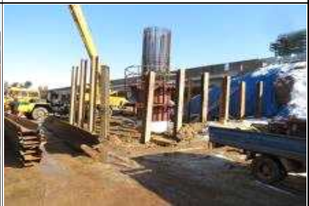
교각 P4 시공현황(14.12.18)
