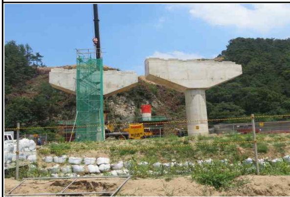
교각 P3(양방향) 시공 현황 (2015.06.29)
