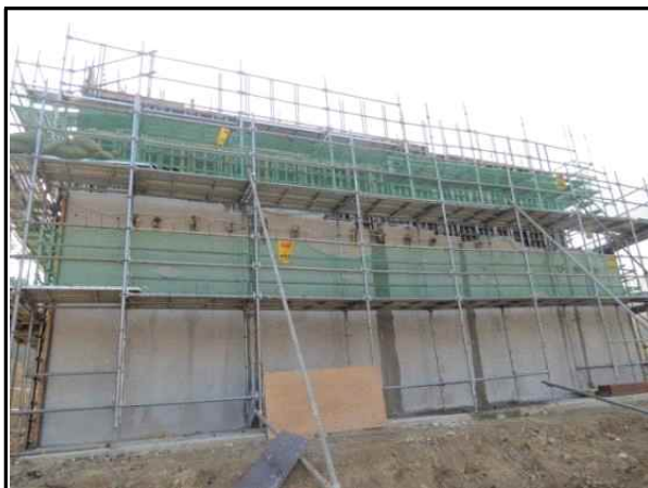
교대 가설비계 설치 현황
