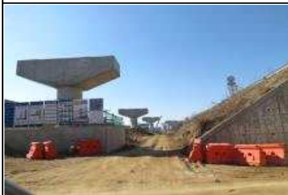
교각 P5~P8 시공현황(15.02.13)
