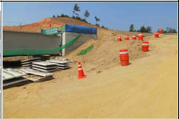
현장내 안전시설 설치 현황①
