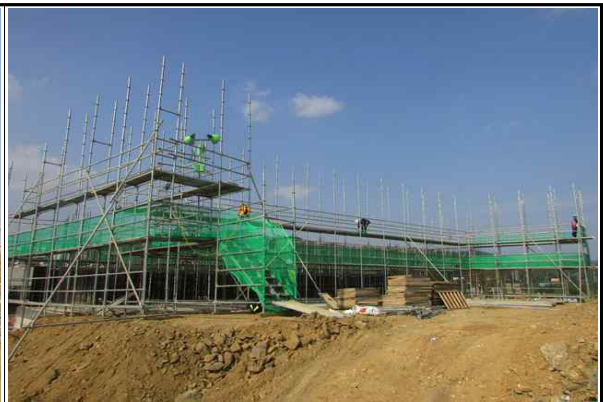
교대 A2 시공 전경② (2016.10.11)
