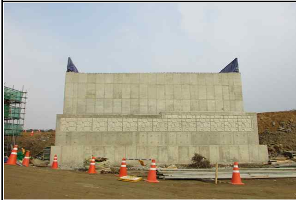
교대 A2 시공 전경 (2017.01.12)
