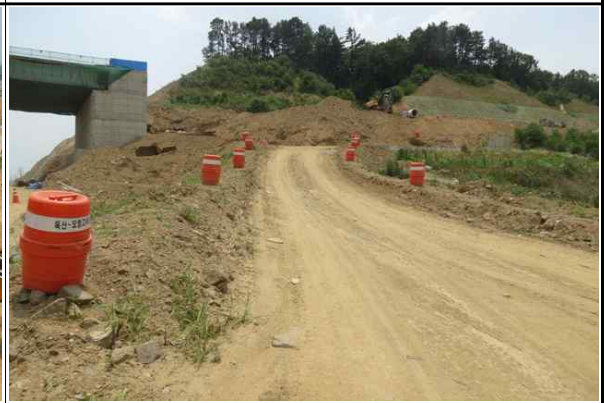
현장내 안전시설 설치 현황④
