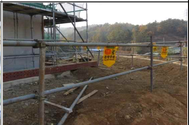
현장내 안전난간 설치상태 양호
