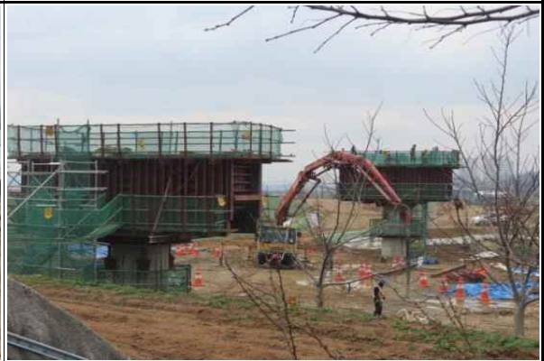
교각 P2,P3 시공 현황(15.04.07)
