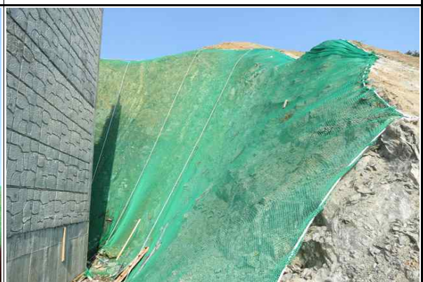
교대 A2 인접 법면 보호망 설치 현황②
