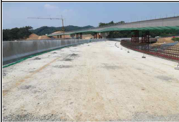
상부슬래브(S1~S3) 콘크리트 타설 완료① (2017.06.21)
