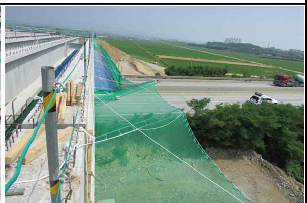
상부 추락방지망 설치 현황②
