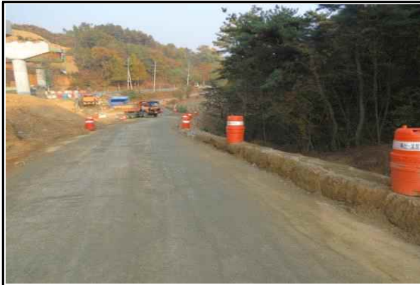
현장내 안전시설(PE드럼) 설치상태 양호
