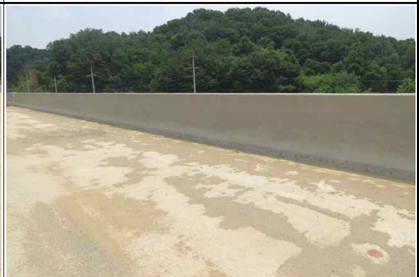
방호벽 시공 현황② (2017.06.21)
