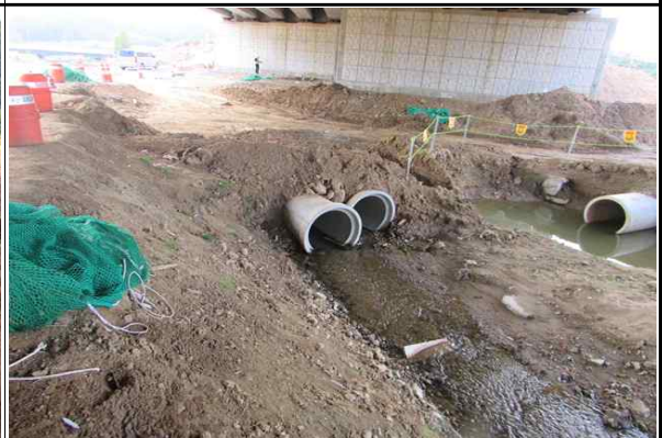
현장내 가설도로 및 임시배수관 시공 현황①
