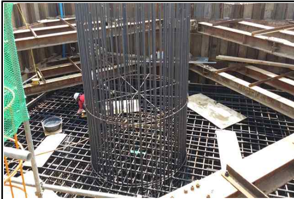
교각 P1(오창) 기초 철근배근 시공 현황 (2015.04.02)
