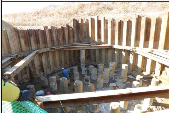
교각 P1(오창방향) 매입PHC말뚝 시공 현황
