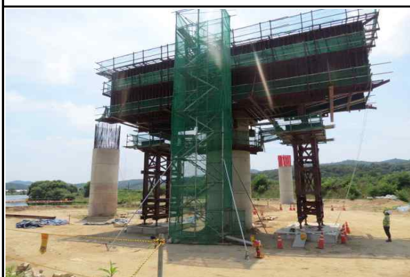
교각 코핑부 시공을 위한 가설벤트 및 위킹타워 설치 현황
