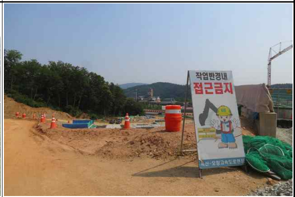
현장내 안전시설 설치 현황①
