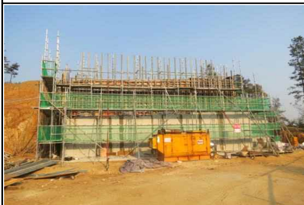
교대 A2 옥산방향 시공 현황 (2015.11.03)
