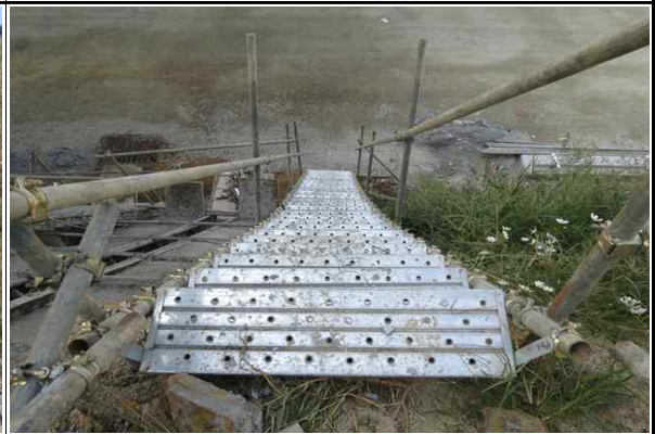
가설계단 설치 및 고정상태 양호
