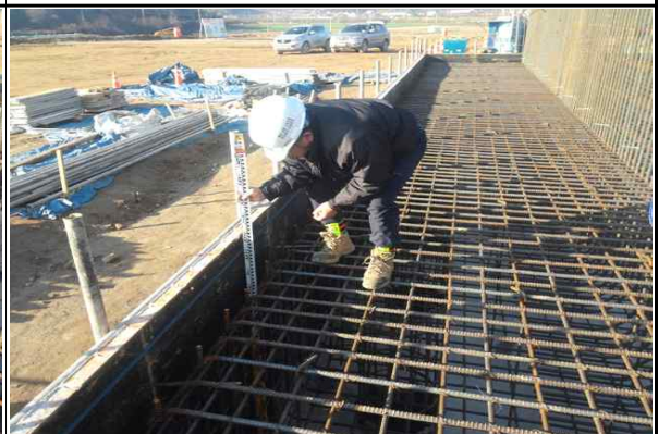
교대 A1(옥산) 기초 거푸집 및 피복두께 측정 현황(2015.12.06)
