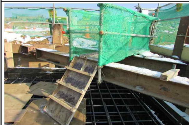
교각 P2 기초 진입을 위한 가설통로 설치 상태①
