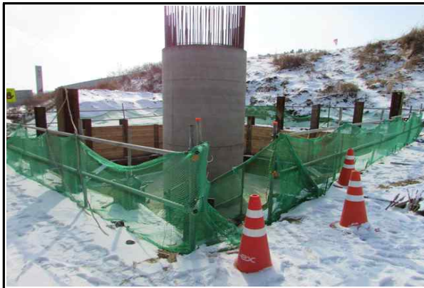
교각 P2 시공 현황① (2017.01.23)
