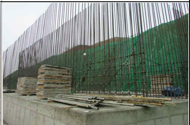
교대 A2 시공 전경 (2017.01.12)
