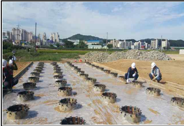
교대 A1 매입강관말뚝 검측 현황 (2015.09.16)
