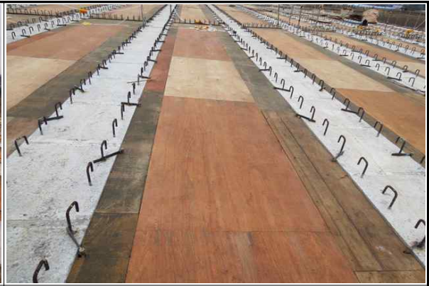
바닥판 거푸집 설치 상태 양호
