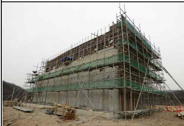
교대 A1 거푸집 및 가설비계 설치 현황①
