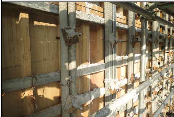
교대 A1 거푸집 설치 상태 양호
