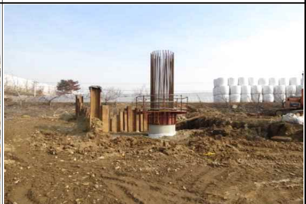
교각 P3 구체 시공 현황(15.02.03)
