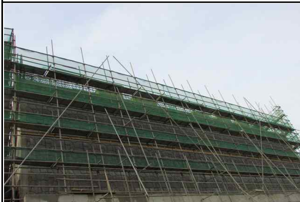
교대 A1 가설비계 설치 현황①
