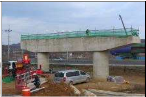
교각 P1 시공 현황 (2015.12)
