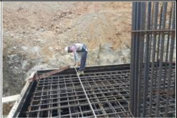
교각 P3 기초(오창) 콘크리트 타설 전 제원 실측(2015.07.20)
