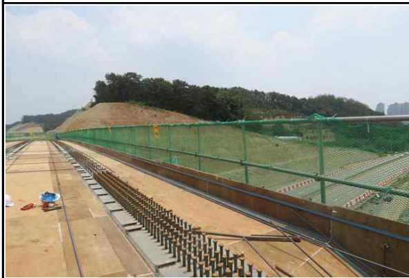
상부 안전난간 설치 현황①
