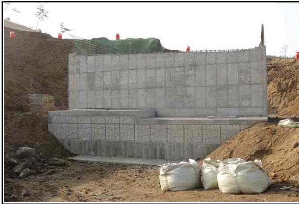
교대 A1 시공 전경 (2017.01.03)
