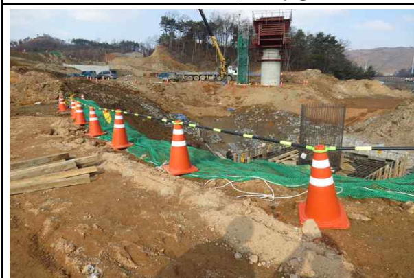
현장내 안전시설 설치 현황
