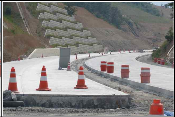
현장내 안전시설 설치 현황④
