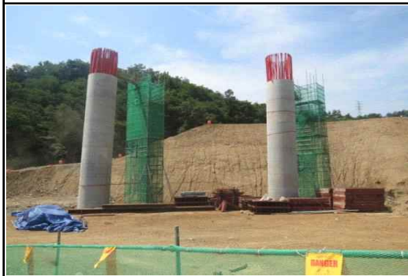
교각 P1 시공 현황 (2015.06.29)
