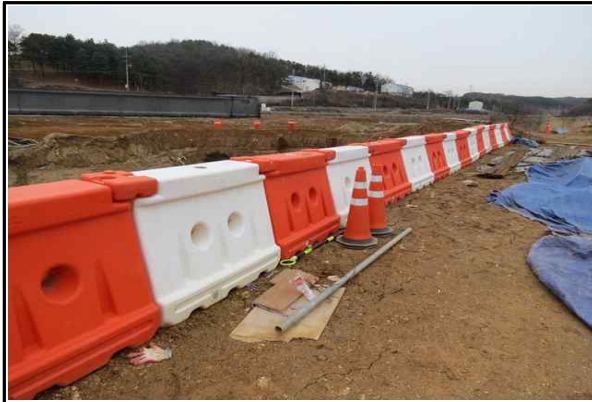
현장내 안전시설 설치 현황③
