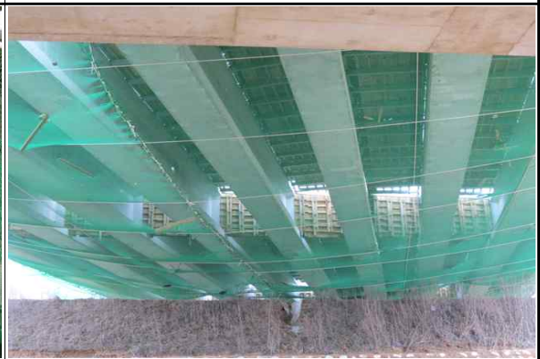
상부 추락방지망 설치 현황②
