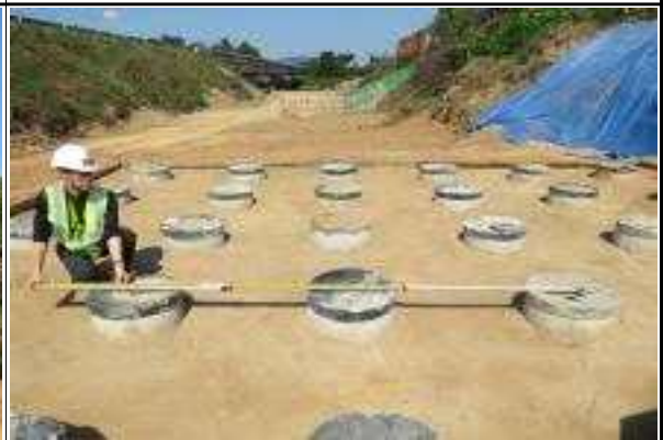
교각 P6 매입PHC말뚝 제원 및 간격 실측
