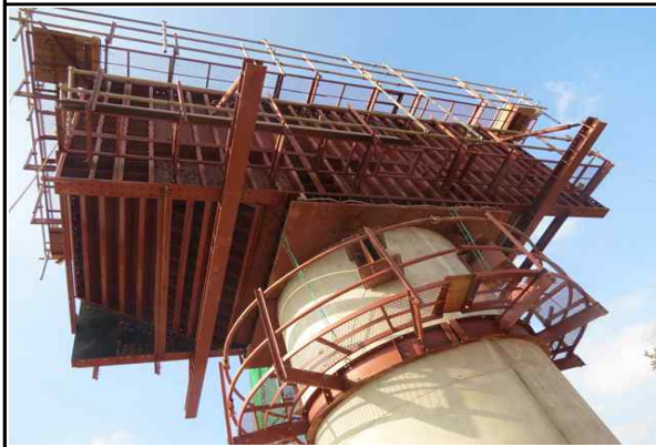
교각 P2 두부 강재거푸집 설치 상태①
