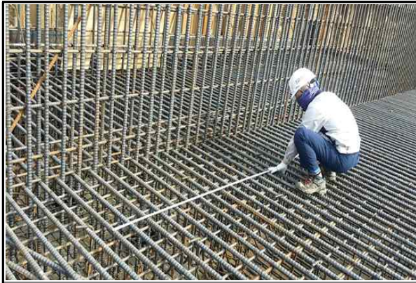
교대 A1(옥산) 기초 철근배근간격 실측 현황(2016.04.27)
