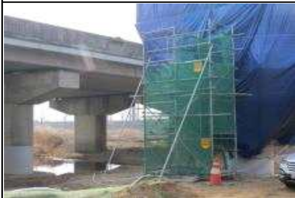
교각 P2 워킹타설 설치·운용 상태 양호
