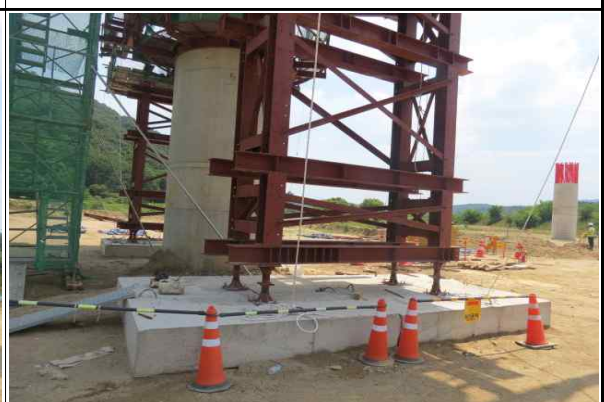
가설벤트 기초부 시공 상태
