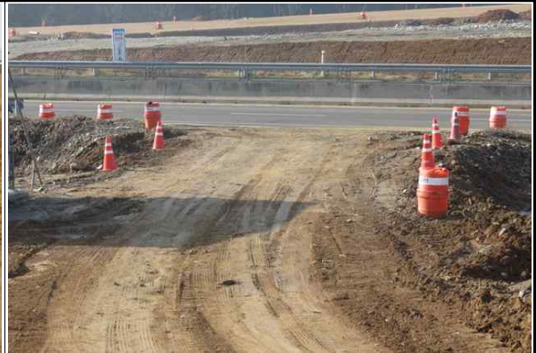
현장 진입로 안전시설(라바콘) 설치 현황
