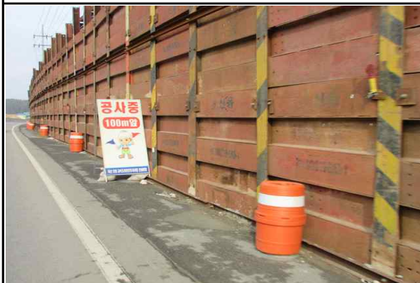
인접도로 주변 공사안내 표지판 설치 현황
