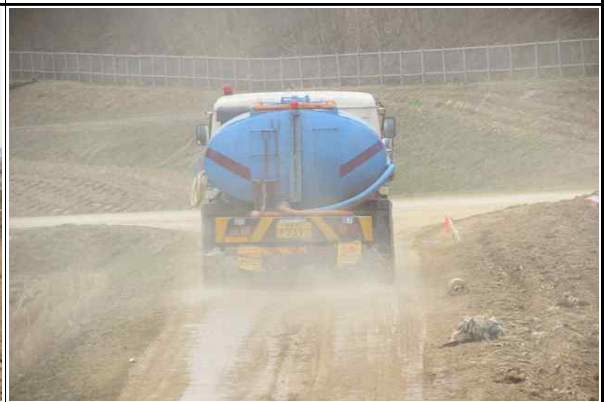
현장내 살수차 운용 현황
