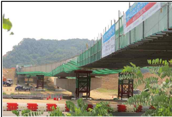
S1~S3 거더 거치 시공 현황 (2017.06.21)
