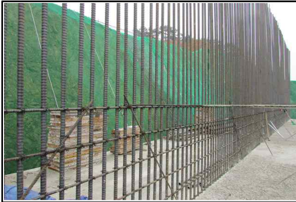
교대 A2 구체부 철근배근 시공 현황 (2017.01.12)
