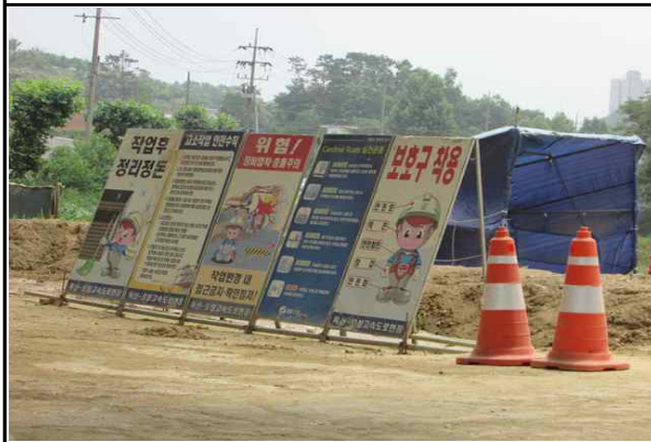
현장내 안전간판 설치 현황
