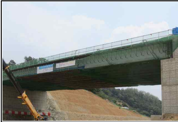
상부 시공 전경 (2017.06.21)
