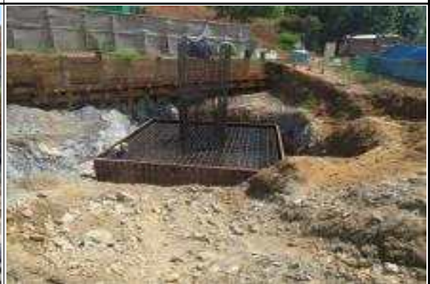
교각 P2 기초(오창) 시공 현황 (2015.06.29)
