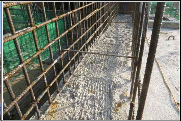
교대 A1 신·구 콘크리트 접합부 치핑상태 양호 (2017.01.03)
