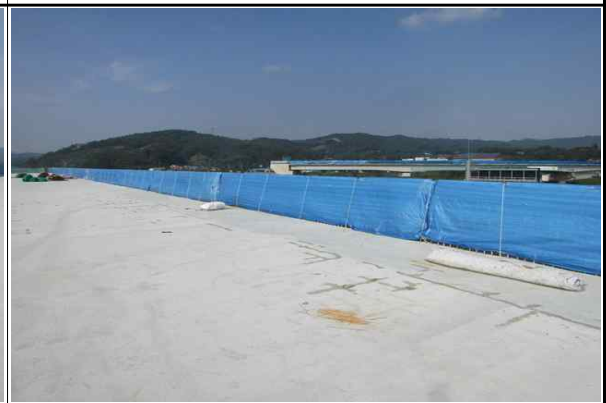
상부 방호벽 노출철근 보호덮개 설치 현황②(2016.10.11)
