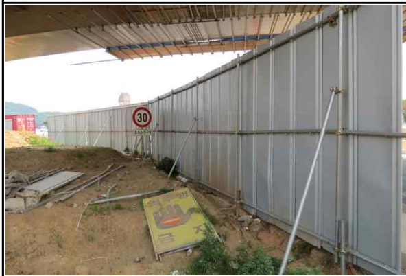
현장 인접도로 주변 안전휀스 설치 현황①
