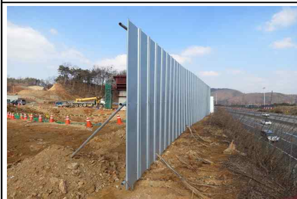
현장 인접도로 주변 안전휀스 설치 현황①
