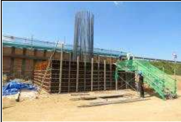
교각 P8 거푸집 설치 상태
