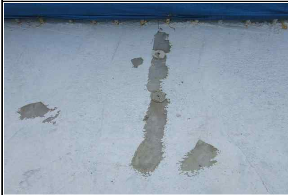
상부슬래브 균열 보수 현황 (2016.10.11)
