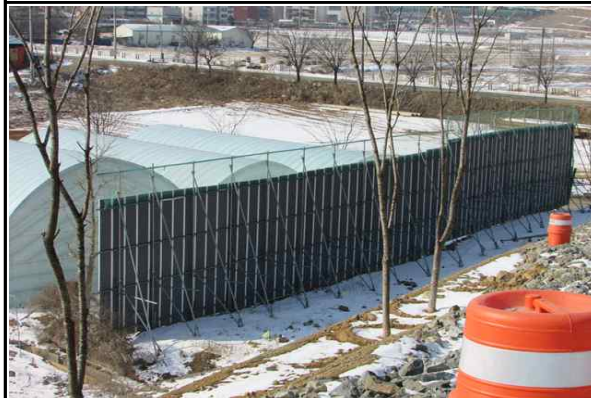
중점측 공사현장에 인접한 비닐하우스 주변 안전휀스 설치 현황
