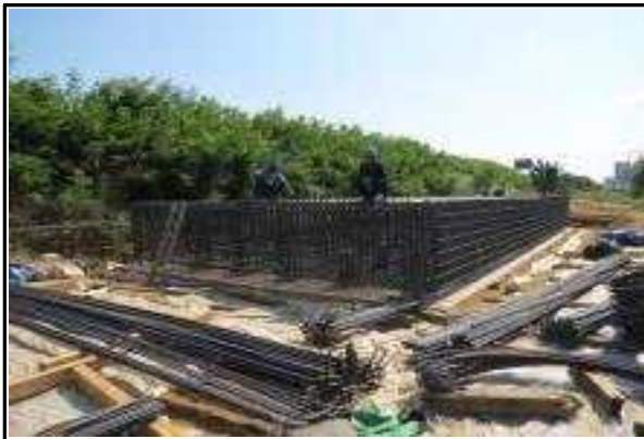
교각 P1 기초 시공 전경①
