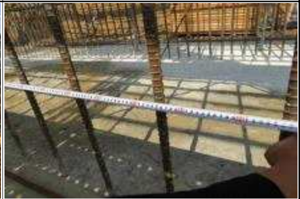
교대 A2 오창방향 벽체 철근배근상태 양호 (2015.09.04)
