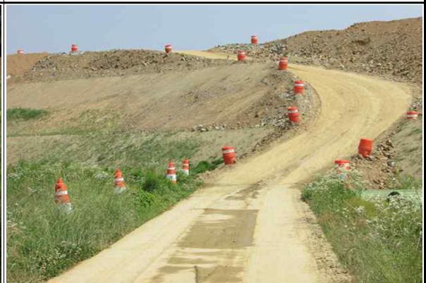
현장내 안전시설 설치 현황②
