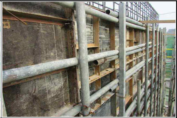
교대 A1 거푸집 설치 및 고정상태 양호②
