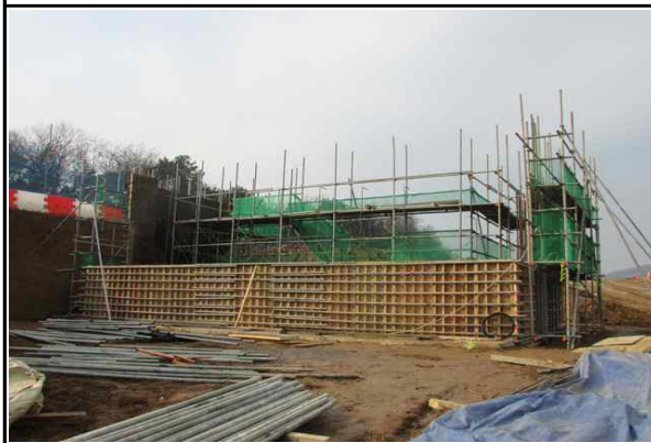
교대 A2 시공 전경 (2017.01.12)
