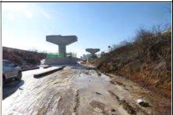
교각 P7~P8 시공현황(14.12.18)
