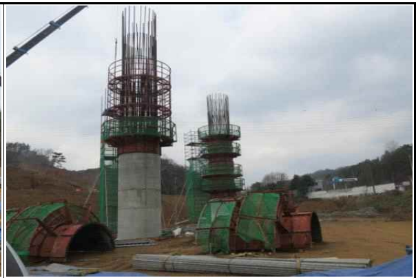
교각 P1 시공 현황② (2015.04.07)
