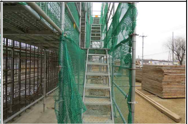
가설계단 설치 및 고정상태 양호
