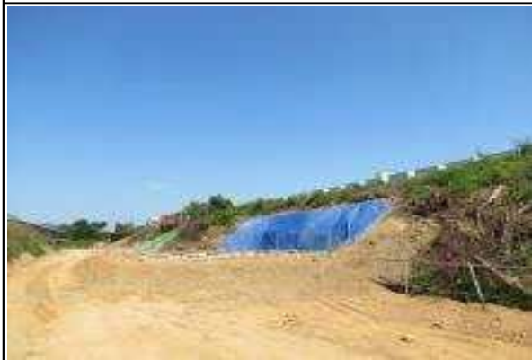
교각 P6 매입PHC말뚝 시공 현황
