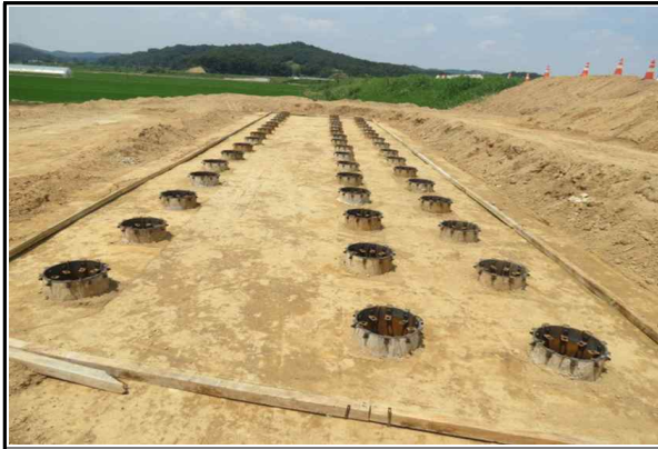
교대 A1 매입복합말뚝 시공 현황
