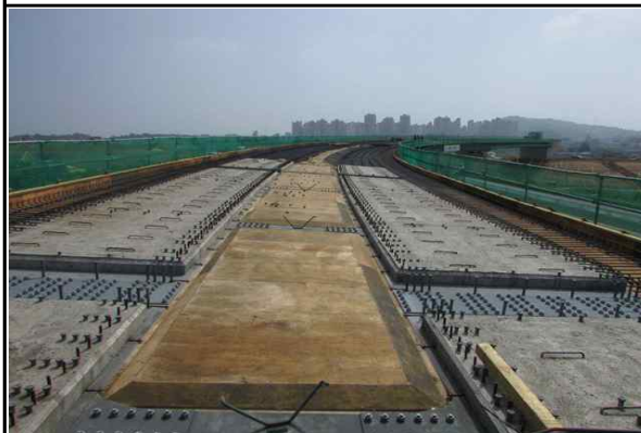
상부슬래브 S7~S10 시공 현황 (2016.06.13)
