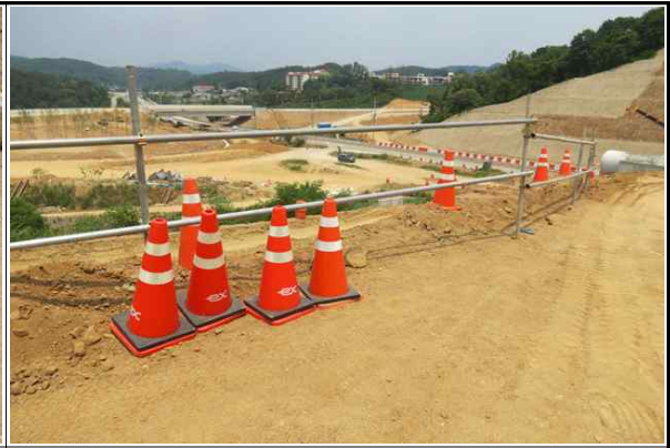
현장내 안전시설 설치 현황②
