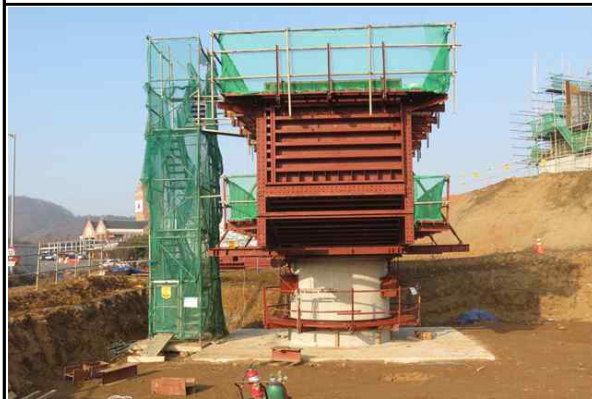
교각 P1 위킹타워 및 강재거푸집 설치 현황
