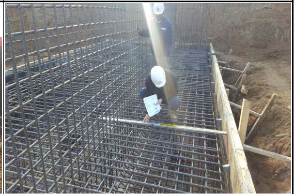
교대 A2 기초 철근배근간격 및 피복두께 확인 (2016.12.08)
