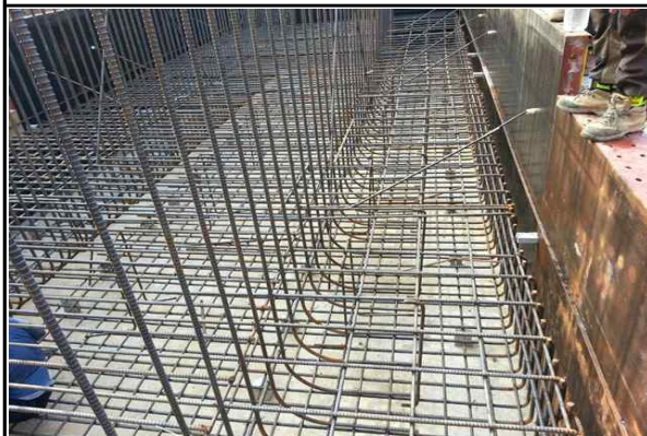
교대 A2 기초(옥산) 철근배근 시공 현황 (2015.08.07)
