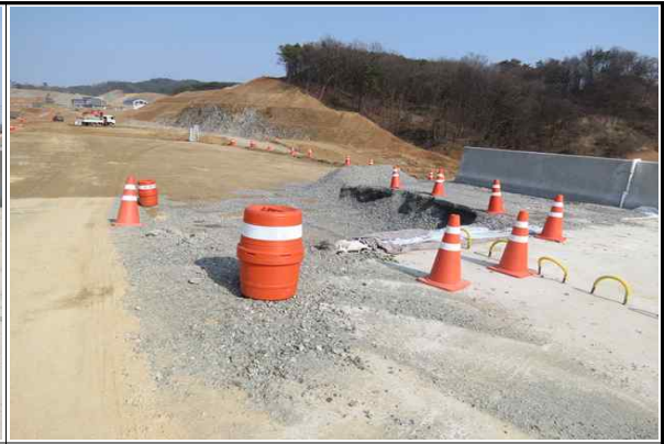
현장내 안전시설 설치 현황④
