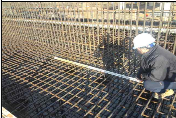
교대 A1(옥산) 기초 철근배근간격 실측 현황(2015.12.06)
