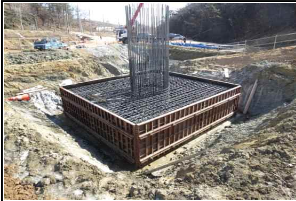
교각 P1 기초(옥산) 시공 현황 (2015.02.13)
