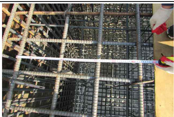
교각 P2 기초 철근배근간격 확인① (2017.01.23)
