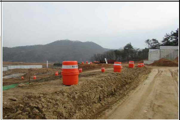
현장내 안전시설 설치 현황④
