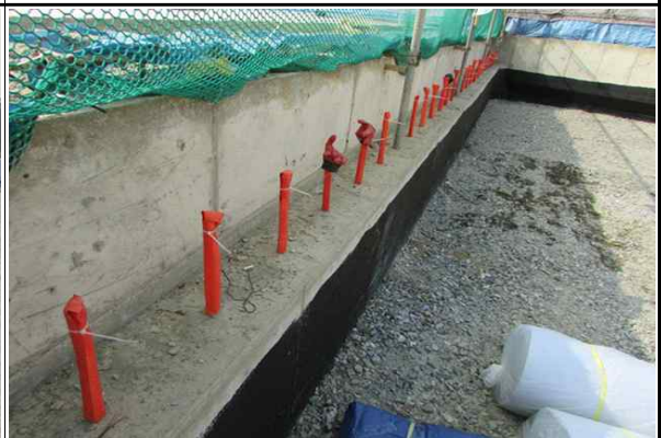
교대 파라펫 노출철근 보호덮개 설치 현황 (16.06.13)
