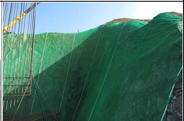
교대 A2 인접 법면 보호망 설치 현황②
