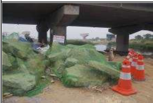
폐기물 임시 야적장 운용 상태 양호
