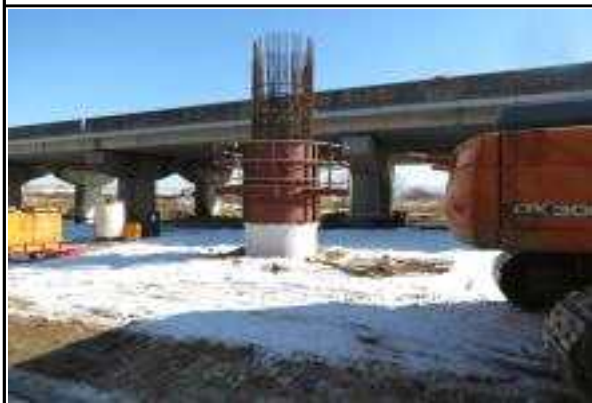
교각 P3 시공현황(14.12.18)
