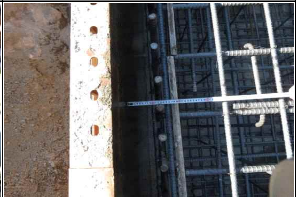
교각 P1 기초 피복두께 확인 전경 (2015.02.13)
