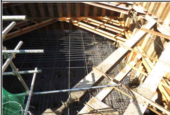
교각 P3(오창) 기초 철근배근 현황 (2015.03.04)
