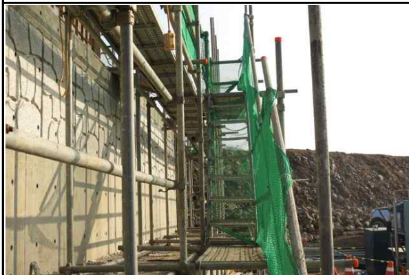
교대 A2 가설계단 설치 및 고정상태 양호①
