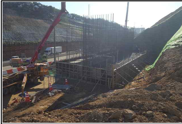
교대 A1 기초 시공 전경 (2016.11.01)
