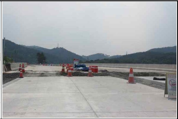
현장내 안전시설 설치 현황
