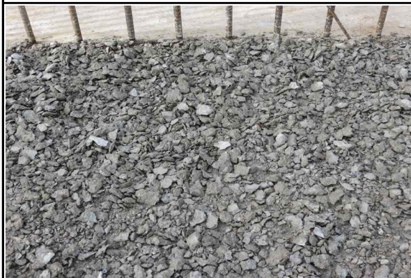
교대 A1 신·구 콘크리트 접합부 치핑상태 양호(2015.12.11)
