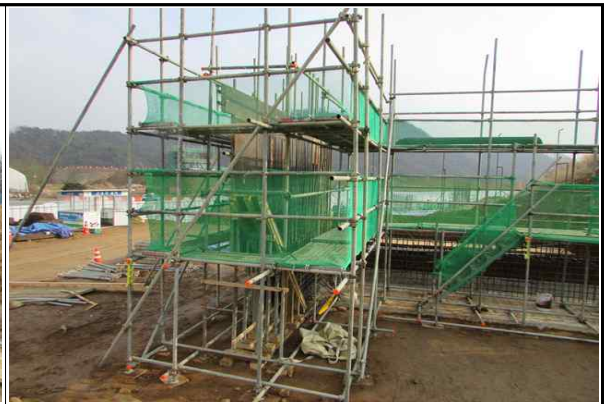
교대 A2 가설비계 설치 현황②
