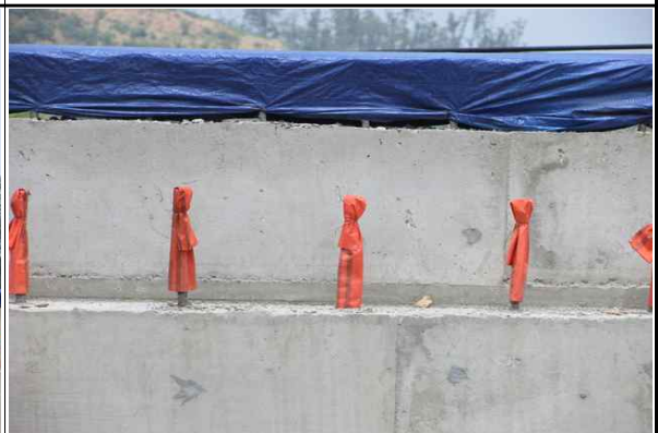
교대 A1 노출철근 보호덮개 설치 현황② (2016.06.13)
