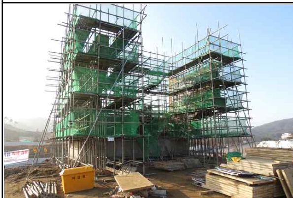
교대 A1 가설비계 설치 현황①
