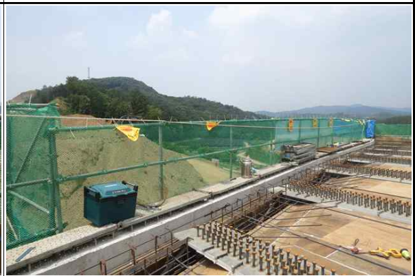
상부 안전난간 설치 현황②
