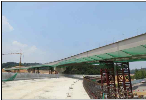
S1~S3 거더 거치 시공 전경 (2017.06.21)
