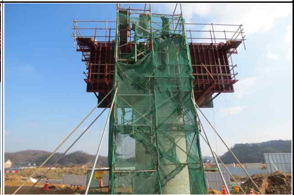
교각 P2 워킹타워 설치 상태②
