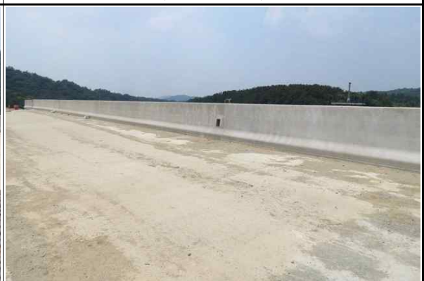
방호벽 시공상태 양호② (2017.06.21)
