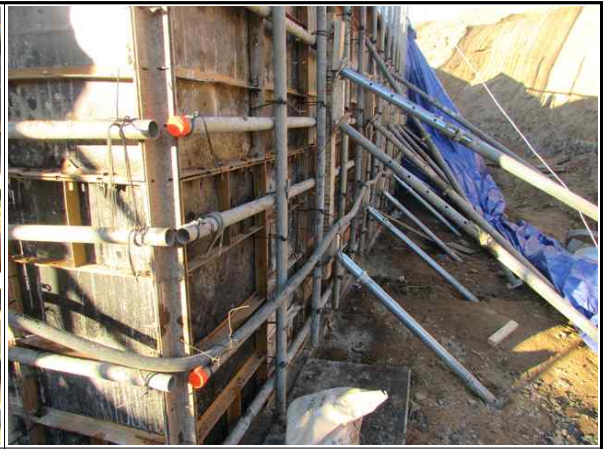
교각 P1 기초 거푸집 설치 상태②
