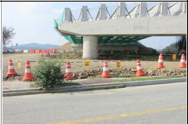
공사장 주변 안전시설 설치 현황
