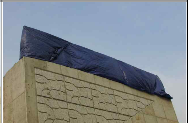
교대 A2 노출철근 보호덮개 설치 현황② (2017.01.12)
