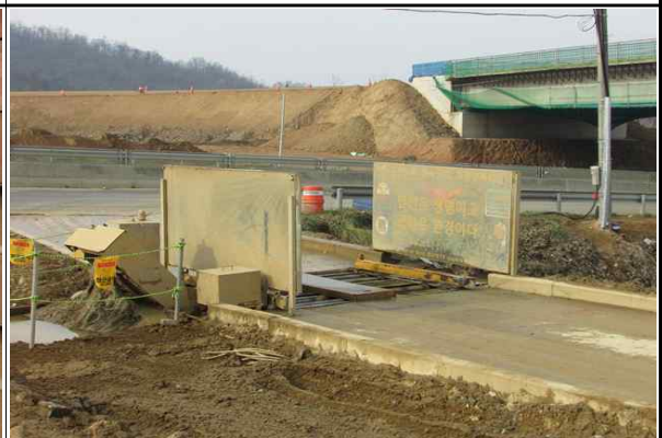
현장 진출로 세륜기 설치 현황
