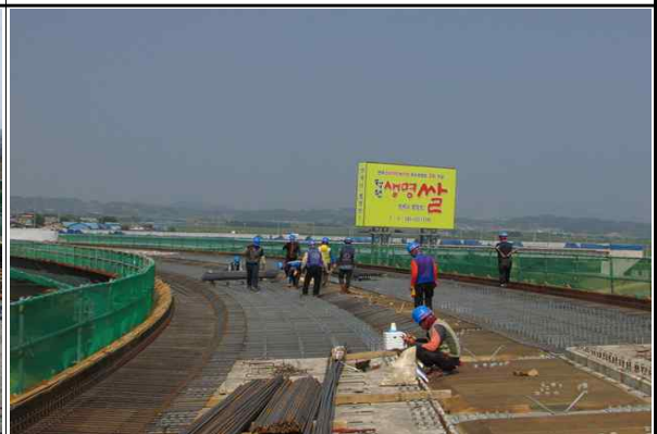
상부슬래브 S7~S10 철근배근 작업 현황 (2016.06.13)
