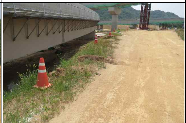
현장내 안전시설 설치 현황(2)
