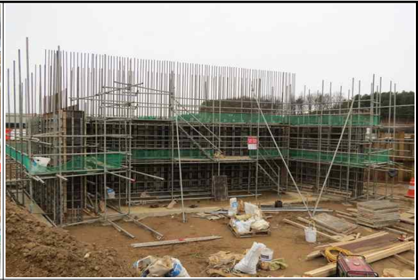
교대 A2(오창방향) 시공 전경 (2016.03.08)
