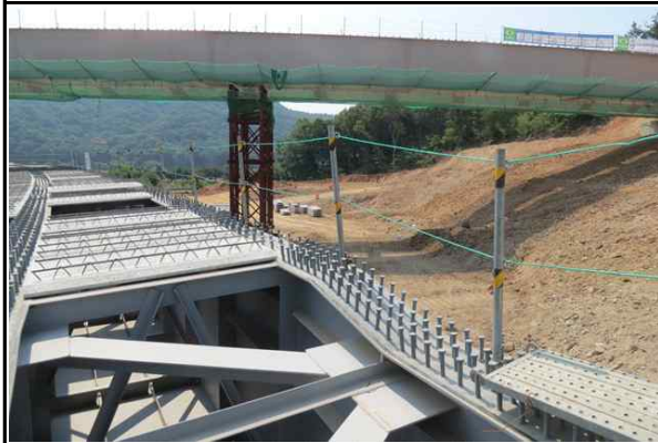
상부공 작업을 위한 안전시설 설치 현황①
