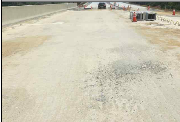
상부슬래브(옥산방향) 시공 현황 (2017.06.21)
