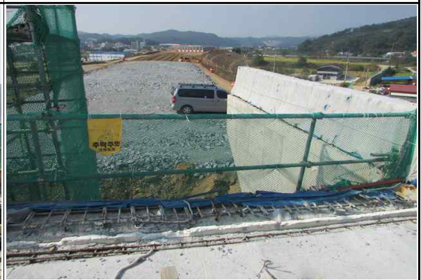
상부 안전난간 설치상태 양호③
