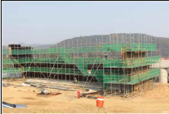
교대 A1 시공 현황 (2015.11)
