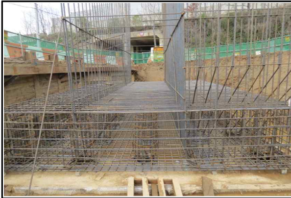
교대 A2 기초철근배근 현황
