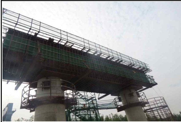
교각 P1 코핑부 강제거푸집 설치 현황
