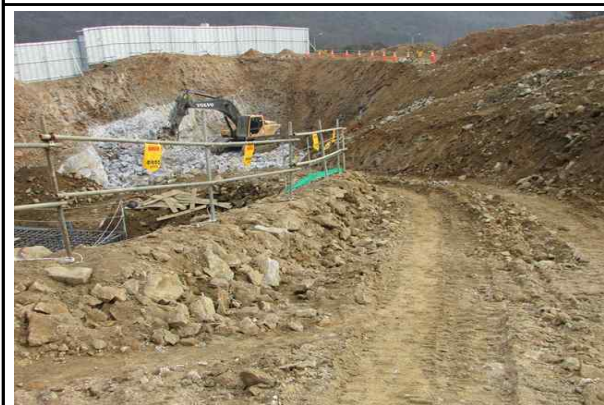
현장내 안전시설 설치 현황
