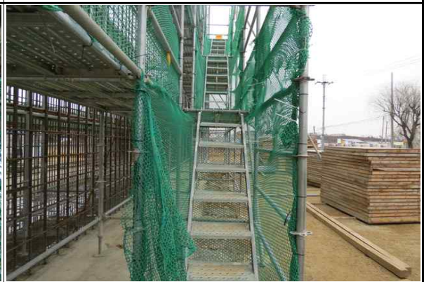
가설계단 설치 및 고정상태 양호
