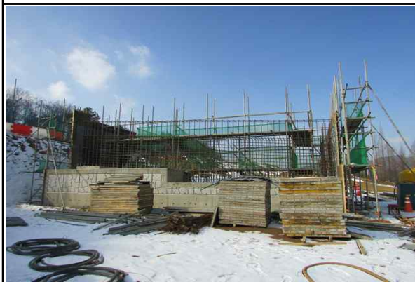
교대 A2 시공 전경 (2017.01.23)
