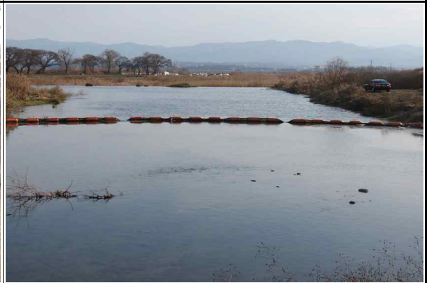
하천 하류부 오탁방지망 설치 현황
