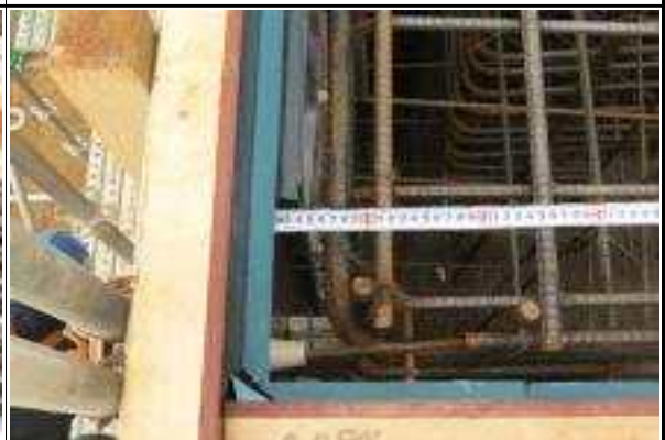
교대 A2 구체부 철근배근상태 양호(15.12.11)
