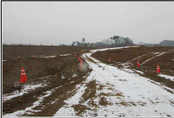
현장내 안전시설(라바콘) 설치 현황①
