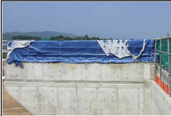
교대 A1 노출철근 보호덮개 설치 현황① (2016.06.13)
