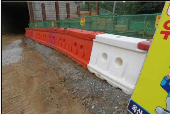
교각 P2 주변 인접도로 안전시설 설치 현황
