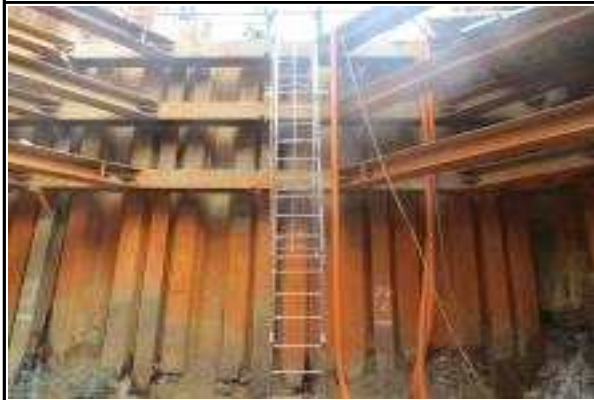
교각 P4 가시설(쉬트파일) 및 가설계단 현황
