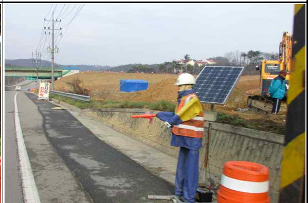
현장 인접도로 신호수마네킹 설치 현황
