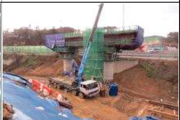
교각 P2 코핑부 강제거푸집 및 워킹타워 설치·운용 현황
