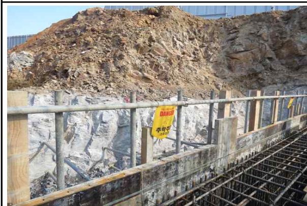
교각 P1 기초 작업장 주변 추락방지를 위한 안전휀스 설치 현황①
