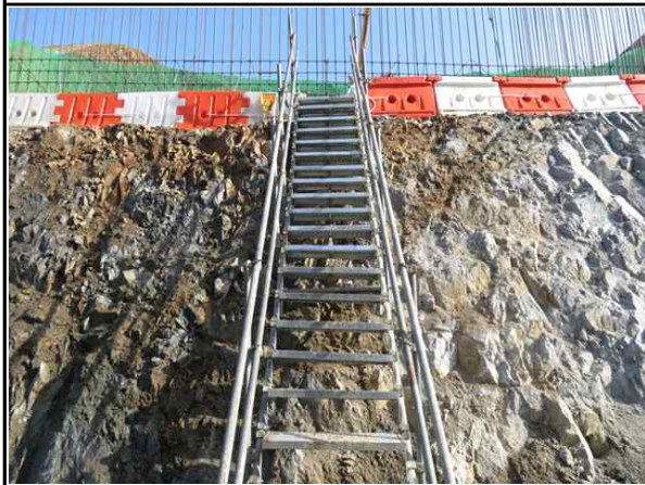
교대 A2 진입을 위한 가설계단 설치 현황
