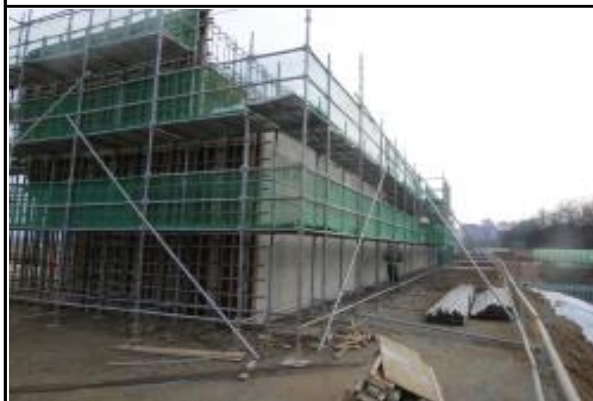
교대 A2 가설비계 및 거푸집 시공 현황
