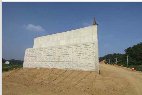
교대 A2(오창방향) 시공 전경① (2016.06.13)
