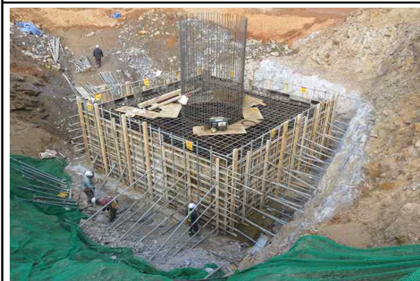
교각 P1 기초 철근배근 및 거푸집 시공 전경① (2017.02.06)
