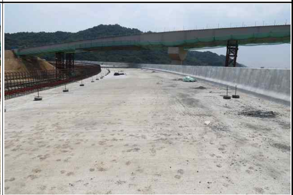
상부슬래브(S1~S3) 콘크리트 타설 완료② (2017.06.21)
