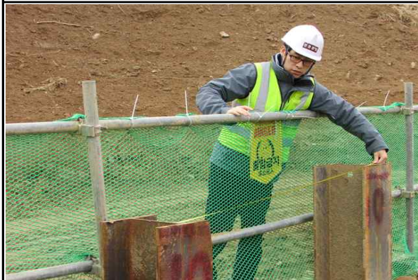
교각 P2 H-Pile 간격 실측 현황
