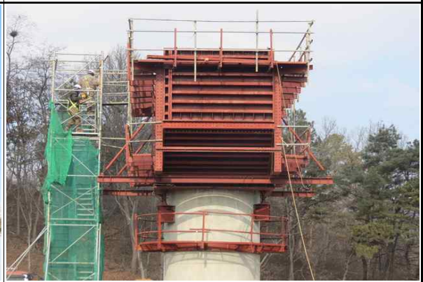
교각 P2 두부 강재거푸집 설치상태②
