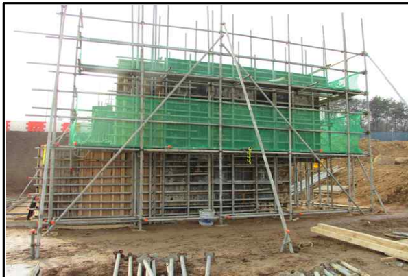
교대 A2 가설비계 설치 현황①
