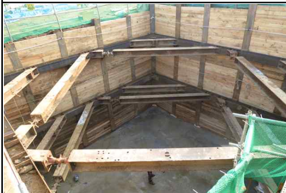
교각 P2 흙막이 가시설 시공 전경 (2017.01.03)
