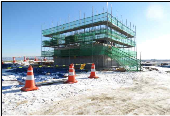
교대 A1 구체 시공 현황(15.12.18)
