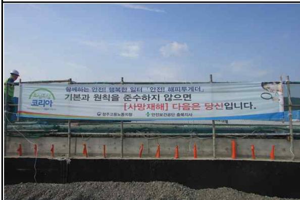
현장내 안전현수막 설치 현황
