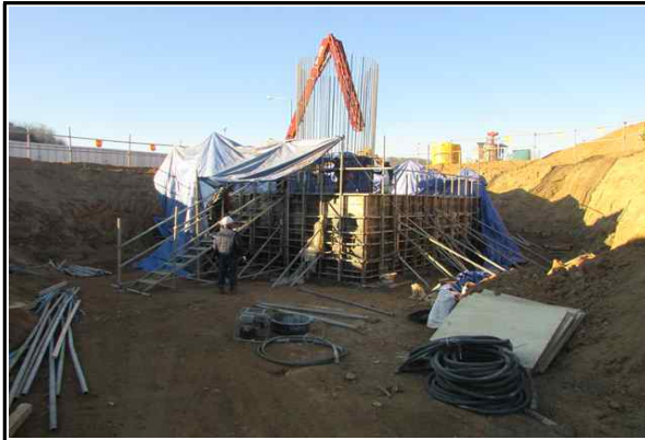
교각 P1 기초 철근배근 및 거푸집 시공 전경 (2016.12.06)
