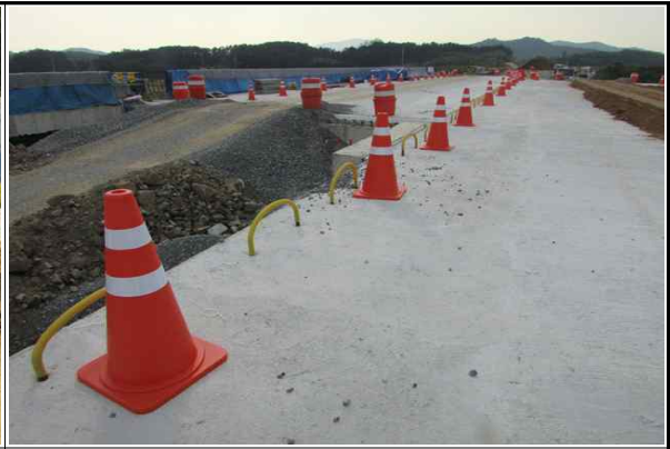
안전시설(PE드럼, 라바콘) 설치 현황②
