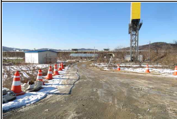
교대 A1 주변 인접도로 안전시설 설치 현황
