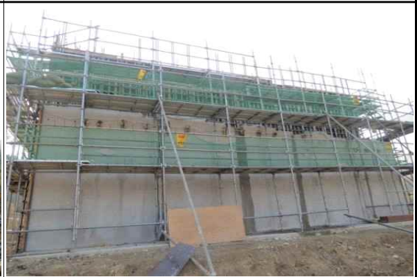
교대 A2 오창방향 시공 현황 (2015.11.03)
