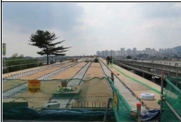
상부 바닥판 거푸집 설치 현황
