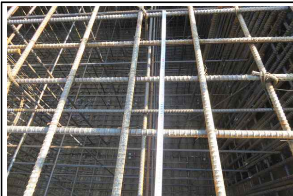
교각 P1 기초 철근배근간격 확인 (2017.02.06)
