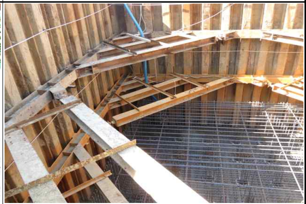
교각 P3(오창) 가시설(쉬트파일) 시공 현황
