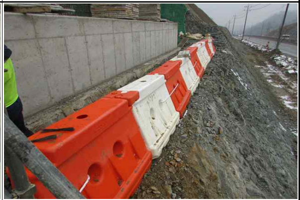
교대 A2 작업장 주변 안전시설(PE방호벽) 설치 현황②
