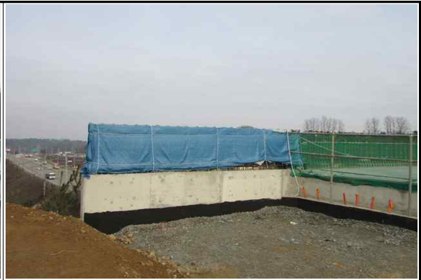
교대 파라펫 노출철근 보호덮개 설치 현황 (2016.12.13)
