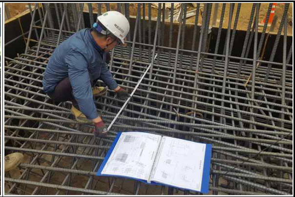
교대 A1 기초 철근배근간격 실측 현황① (2016.11.01)
