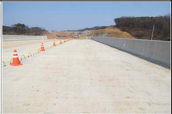
상부슬래브 시공 현황② (2017.04.07)
