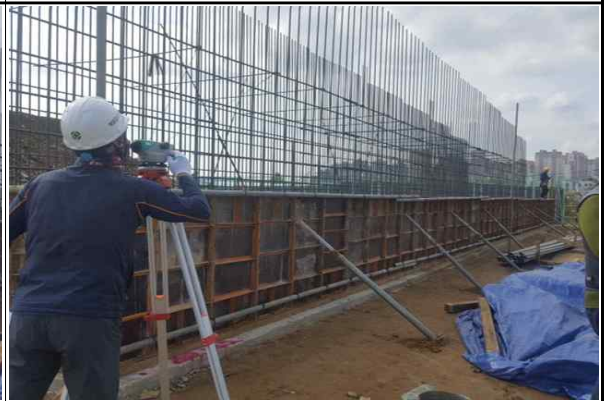
교대 A2 기초 시공 현황① (2016.10.07)
