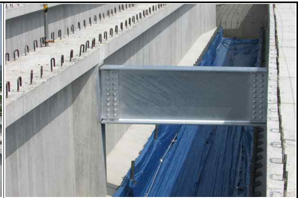
거더 전도방지를 위한 강재 격벽 설치 현황 (2016.06.13)
