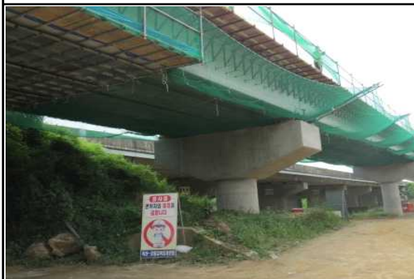
상부 추락방지망 설치 현황①
