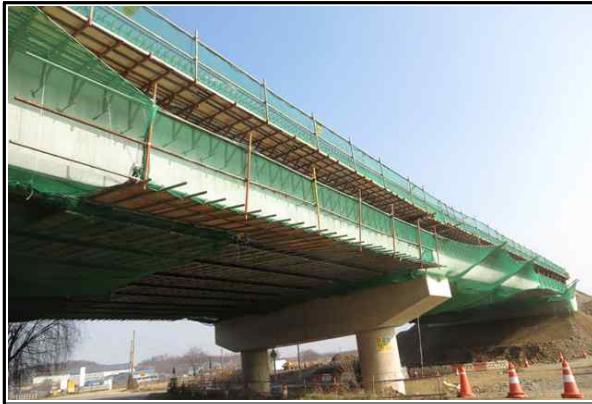
북현3교 상부 시공 현황① (2017.01.03)
