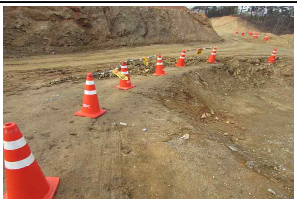
현장내 안전시설 설치 현황
