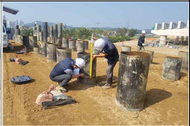
교대 A2 매입강관말뚝 검측 현황② (2016.09.24)
