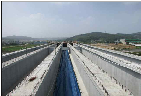
상부 거더(S1~S2) 거치 현황 (2016.06.13)
