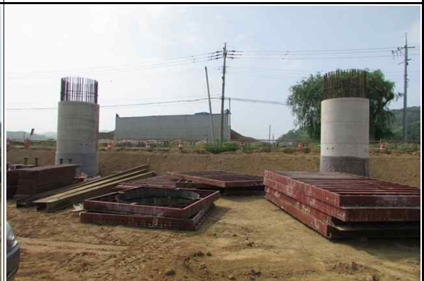
교각 P1 시공 전경 (2016.06.13)
