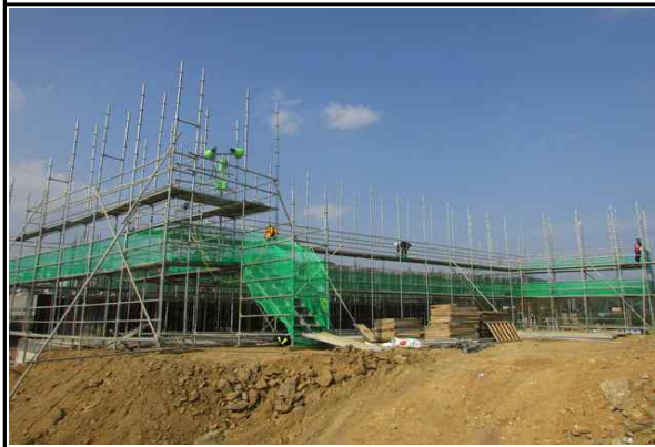
교대 A2 가설비계 설치 현황①
