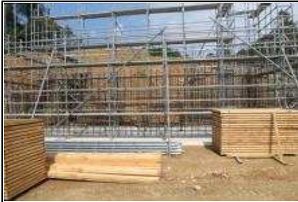
교대 A2 옥산방향 시공 현황 (2015.09.04)
