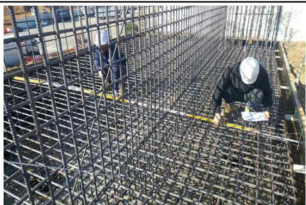
교대 A1 기초 철근배근간격 및 피복두께 확인(2016.11.25)
