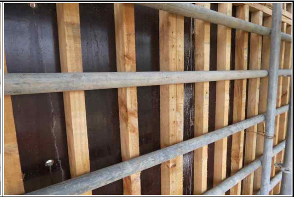
교대 A2 구체 거푸집 설치 현황
