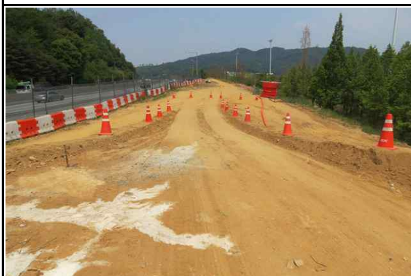
현장내 안전시설 설치 현황(1)
