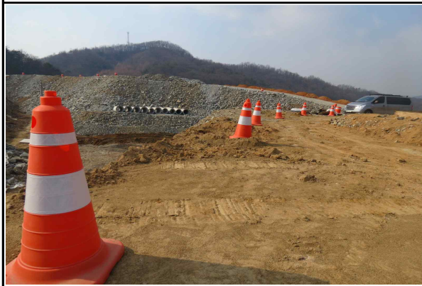
현장내 안전시설(라바콘) 설치 현황
