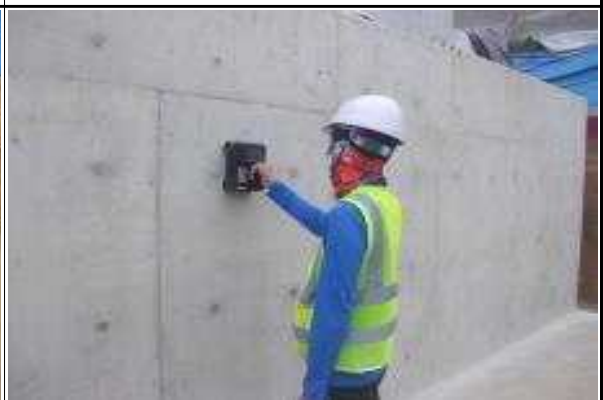
철근배근탐사 시험 현황②
