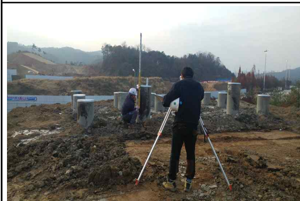
교대 A1 내부굴착강관말뚝 검측 현황① (2016.11.14)
