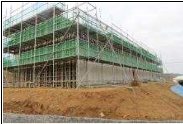
교대 A1 가설비계 및 거푸집 시공 현황
