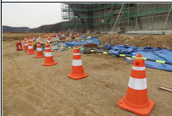
현장내 안전시설(라바콘) 설치 현황
