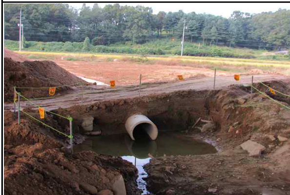
현장내 가설도로 및 임시배수관 시공 현황①
