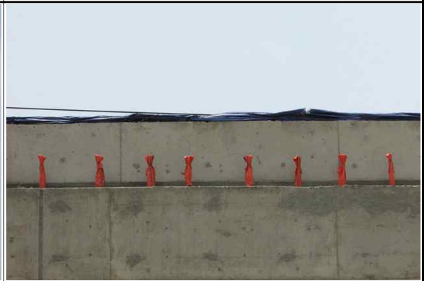
교대 A2 노출철근 보호덮개 설치 현황② (2016.06.13)
