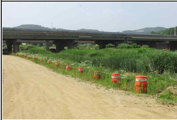
현장내 안전시설 설치 현황③
