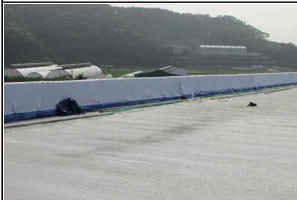
상부 방호벽 보호덮개 설치 현황 (16.06.13)
