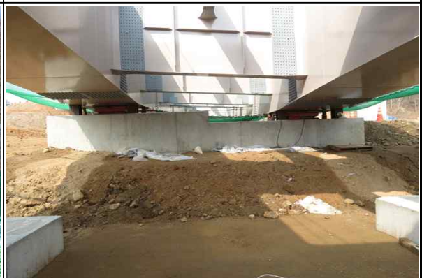
교각 P1 시공 전경 (2017.04.07)
