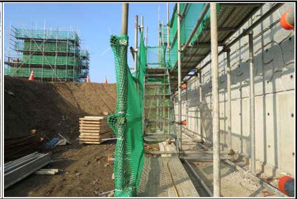
교대 A1 가설계단 설치 상태 양호
