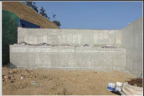
교대 A2(옥산방향) 시공 현황 (2016.06.13)
