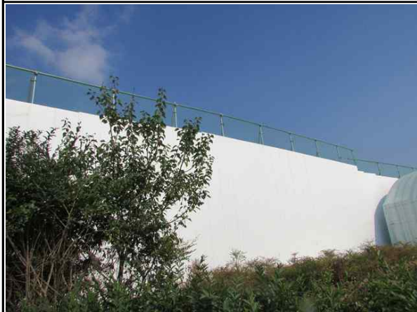
가설방음벽 설치 현황①
