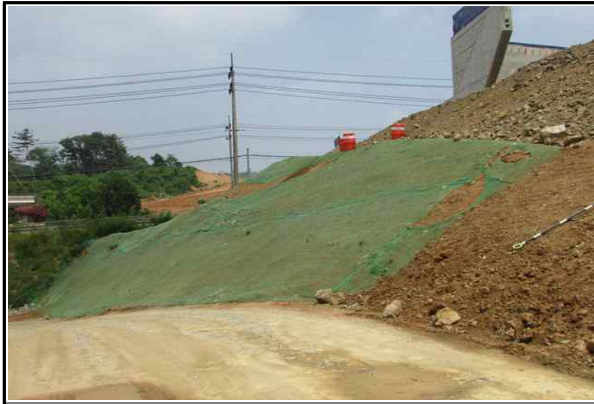
교대 A1 인접법면 보호상태 양호
