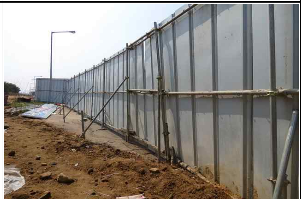
현장 인접도로 주변 안전휀스 설치 현황②
