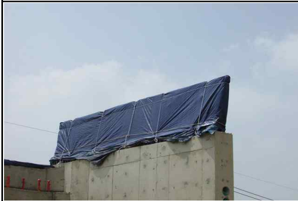
교대 A2 노출철근 보호덮개 설치 현황① (2016.06.13)
