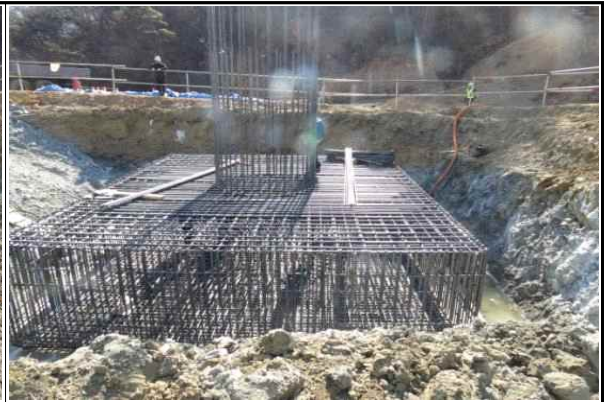
교각 P1 기초(오창) 시공 현황 (2015.02.13)
