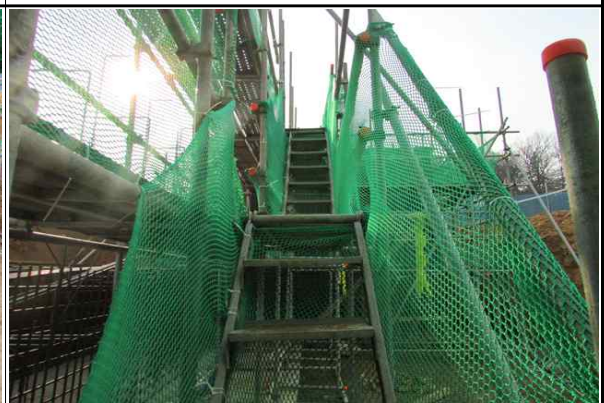
교대 A2 가설계단 설치 상태 양호
