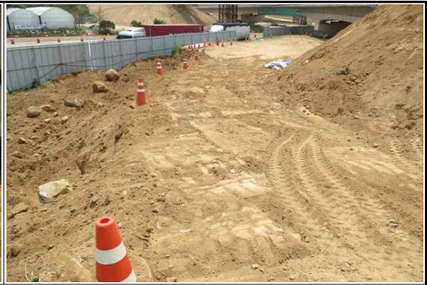
현장내 안전시설 설치 현황(4)
