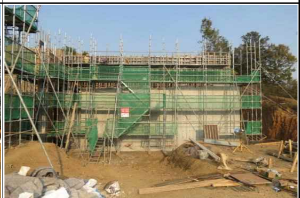
교대 A2 오창방향 시공 현황 (2015.11.03)
