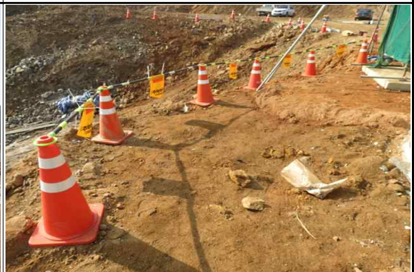
작업장 주변 안전시설(라바콘) 설치 현황
