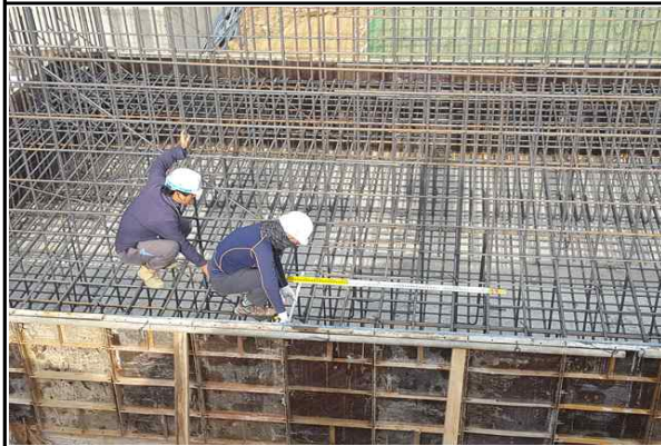
교대 A2(오창) 기초 철근배근간격 실측 현황(2016.03.31)
