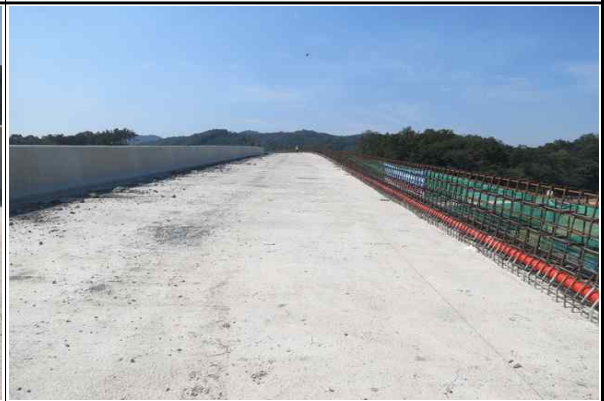
S1~S3 상부슬래브 시공 현황② (2017.09.26)
