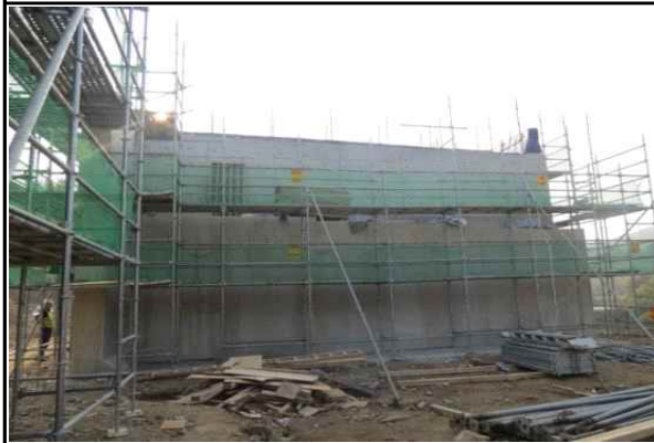
교대 A1 옥산방향 시공 현황 (2015.11.03)
