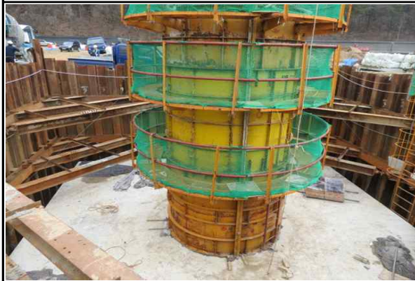
교각 P2(옥산) 시공 현황 (2015.04.07)
