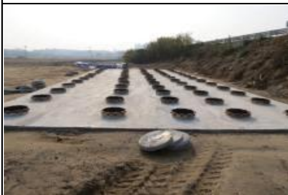
교대 A2 기초 시공 전경
