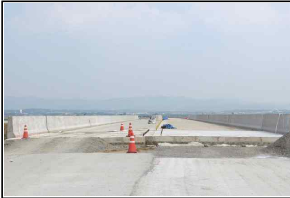
상부슬래브 및 방호벽 시공 현황① (2017.06.21)
