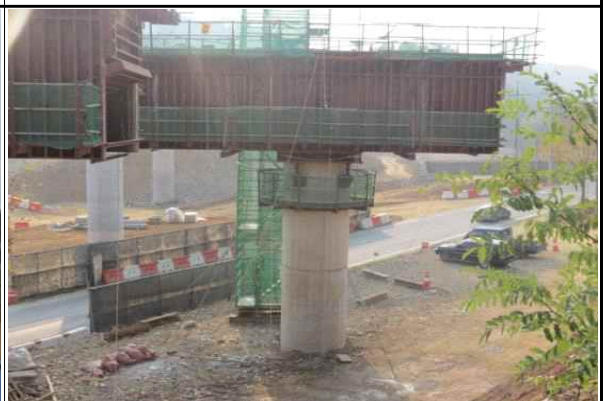
교각 코핑부 강제거푸집 설치 현황
