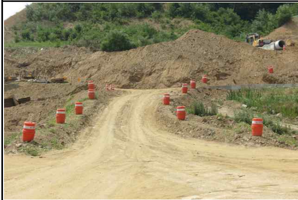
현장내 안전시설 설치 현황②
