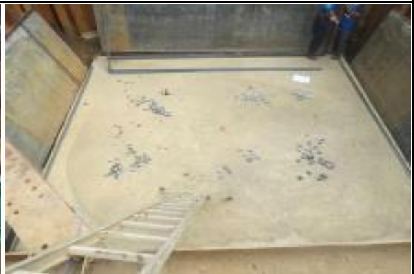
교각 P3 기초 버림 콘크리트 시공 현황
