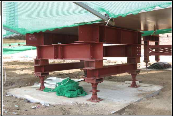
A-1 (G2) 가설벤트 시공 현황
