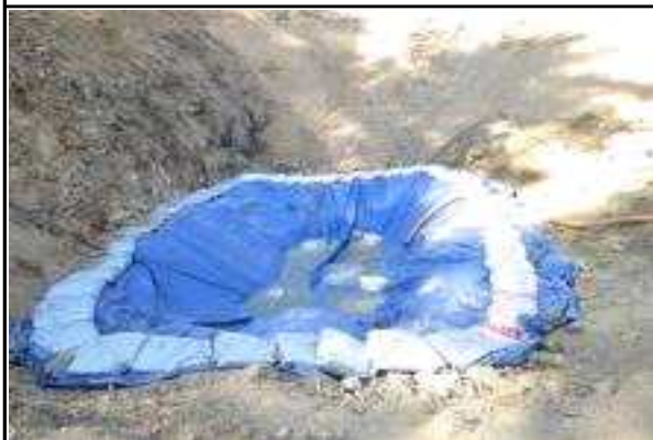
침사지 설치 현황
