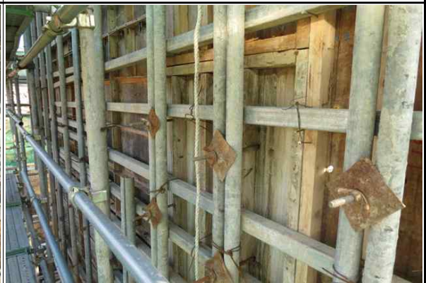
교대 A1 거푸집 설치 상태 양호
