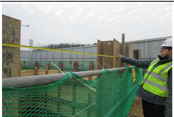
H-Pile 간격 실측 현황
