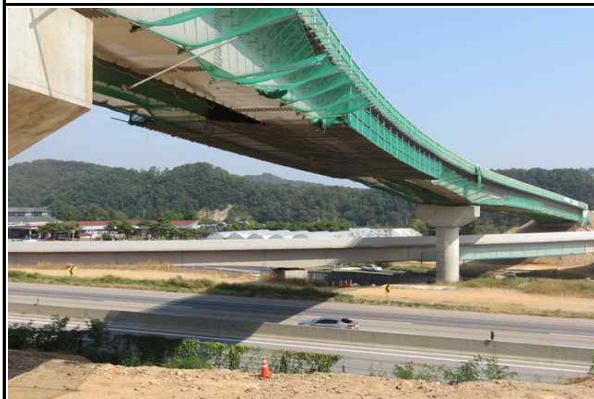
상부 낙하물 방지망 설치 현황①
