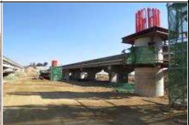
교각 P1~P4 시공현황(15.02.13)
