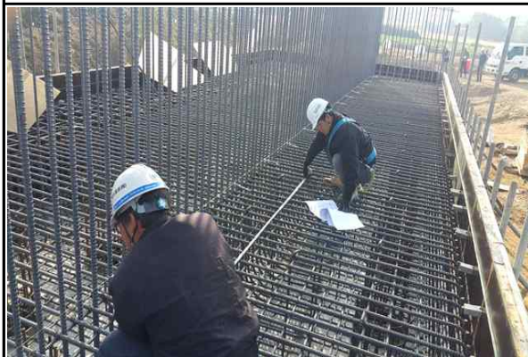
교대 A1 철근배근간격 실측 현황 (2015.11.04)
