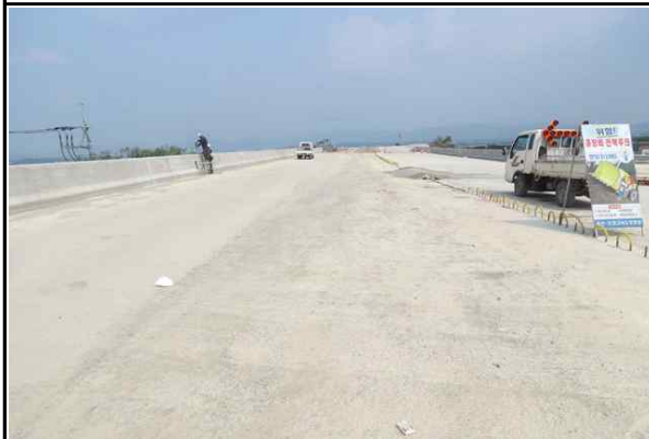
상부슬래브(옥산방향) 시공 전경 (2017.06.21)
