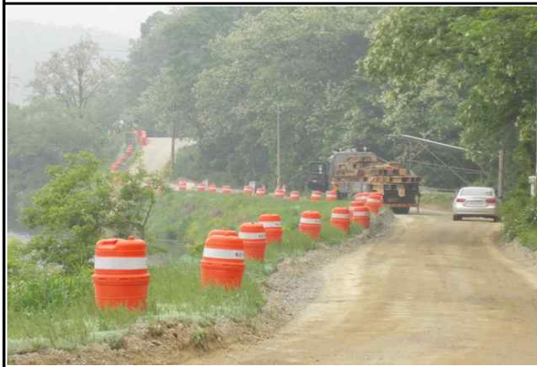
현장 진출입로 안전시설(PE드럼) 설치 현황
