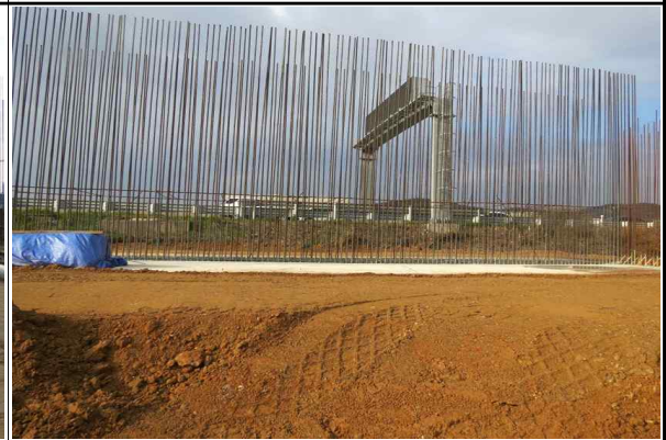
교대 A2 시공 전경 (2015.12.11)
