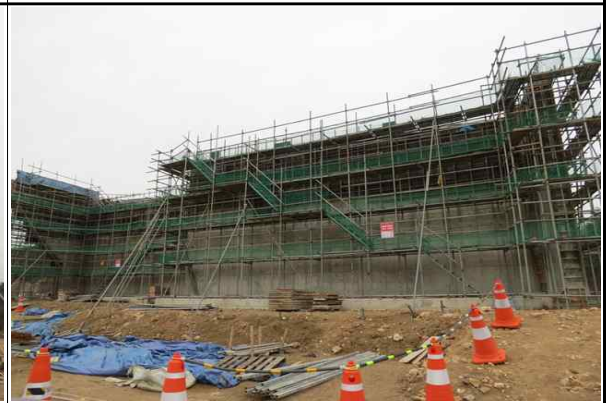
교대 A1 거푸집 및 가설비계 설치 현황②
