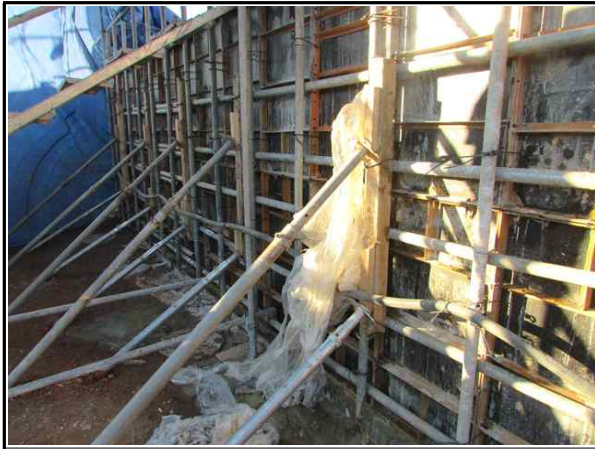
교각 P1 기초 거푸집 설치 상태①
