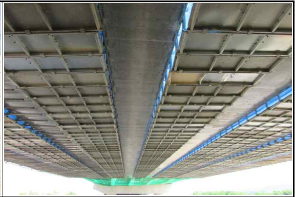
상부 추락방지시설 설치 및 고정상태 양호
