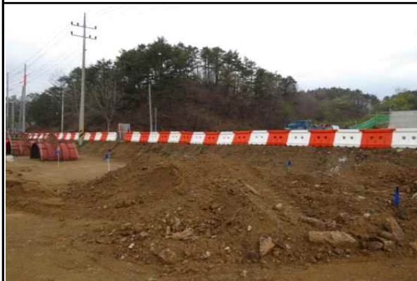
현장 인접도로 안전시설(PE방호벽) 설치상태 양호
