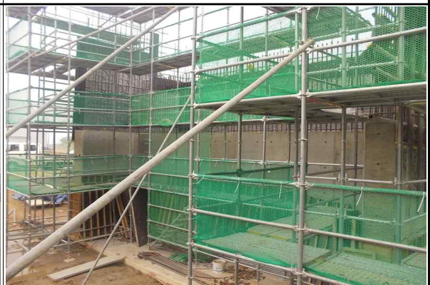
교대 A2 시공 현황(15.05.15)
