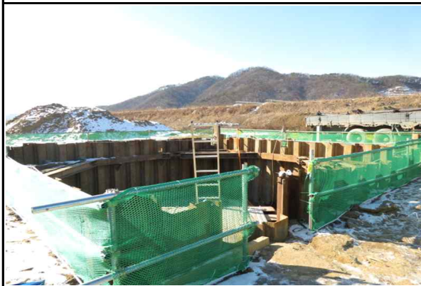
현장내 안전난간 및 NET 설치 현황
