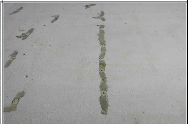
상부슬래브 균열보수 현황 (2016.10.11)
