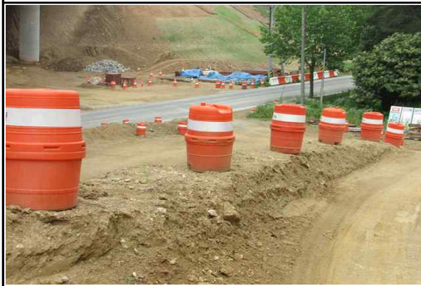
현장내 안전시설 설치 현황⑤
