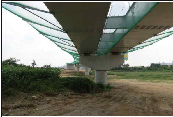
거더거치 시공 현황 (2015.09.04)
