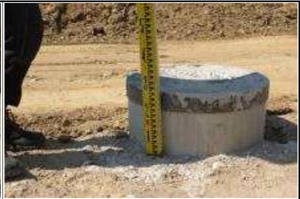
교각 P5 매입PHC말뚝 제원 및 간격 실측
