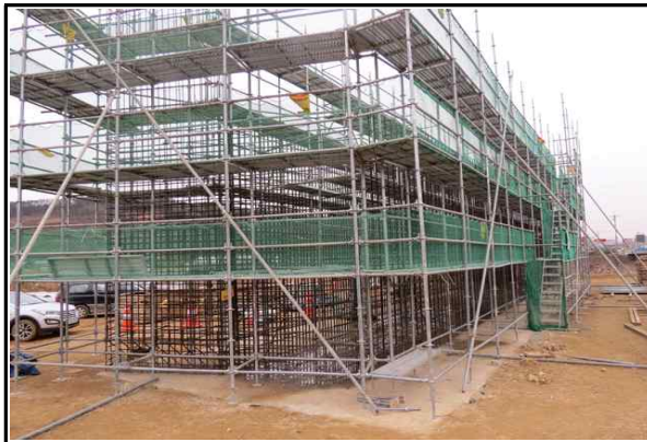
교대 A1 시공 전경 (2016.03.08)
