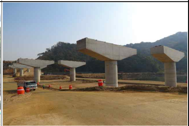
교각 P1~P4(양방향) 시공 현황 (2015.11.03)
