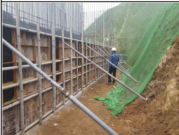
교대 A1 기초 거푸집 설치 현황
