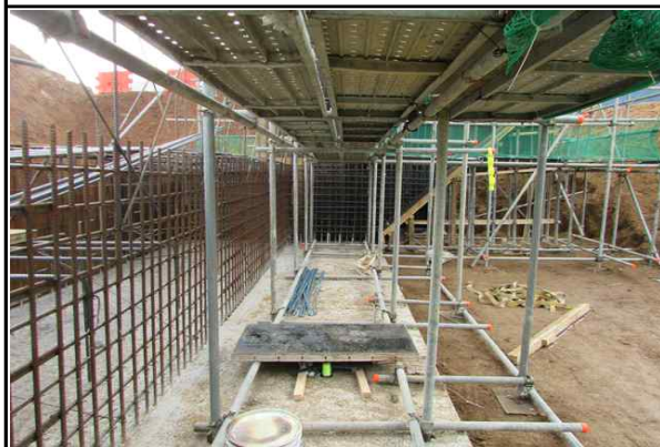
교대 A2 가설통로 설치 상태 양호
