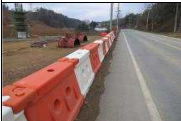
현장 인접도로 안전시설 설치 현황 ①
