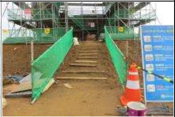
교대 A2 진입부 임시 통로 설치 상태 양호
