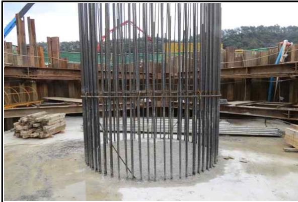
교각 P1(오창) 시공 현황 (2015.04.07)
