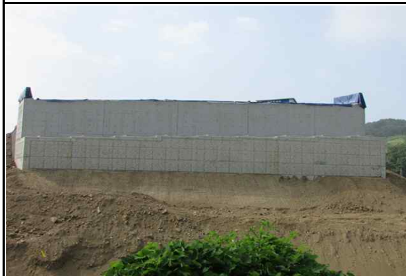
교대 A1 시공 전경 (2016.06.13)
