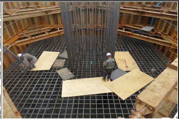
교각 P1(옥산) 기초 철근배근 시공 현황 (2015.04.07)
