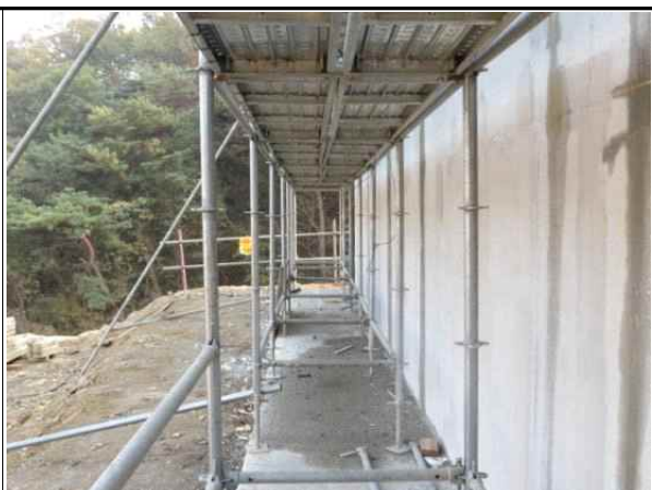
교대 가설비계 설치·고정 상태 양호
