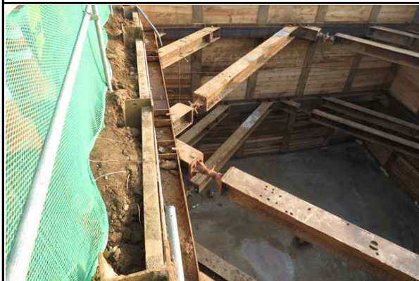
교각 P2 띠장 + 사보강재 연결부 상태 양호①
