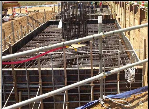
교각 P1 흙막이 가시설 시공 현황②
