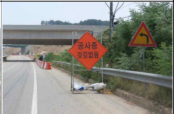
현장 인접도로 안전시설 설치 현황
