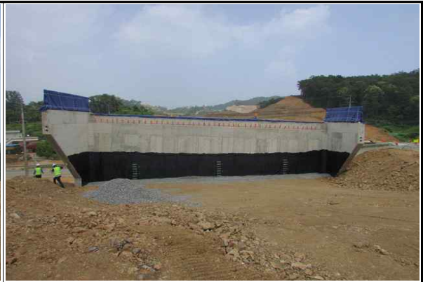
교대 A1 시공 현황② (2016.06.13)
