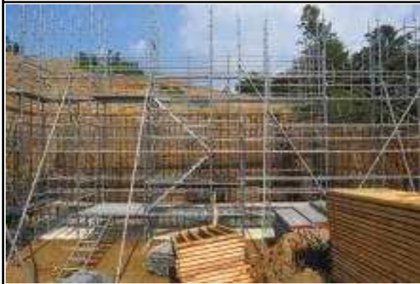
교대 A2 오창방향 시공 현황 (2015.09.04)
