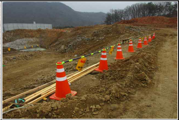
현장내 안전시설 설치 현황②
