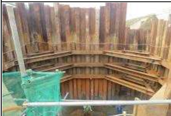
교각 P4 기초 가시설 설치 및 시공현황
