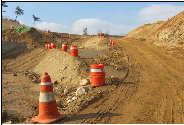
현장내 안전시설 설치 현황
