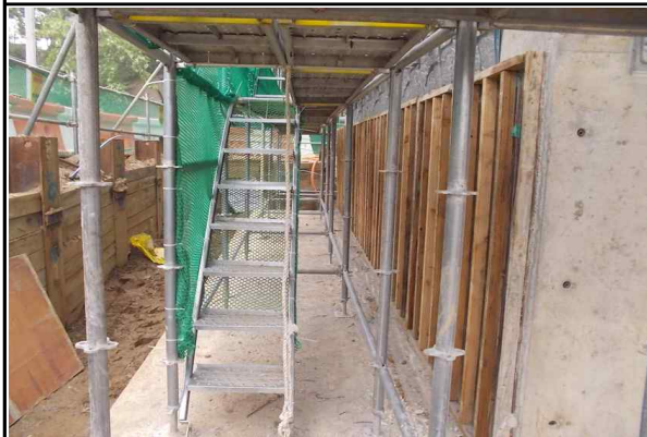
가설계단 설치 상태 양호
