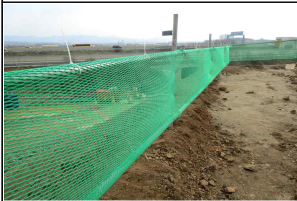
작업장 주변 안전난간 설치 현황
