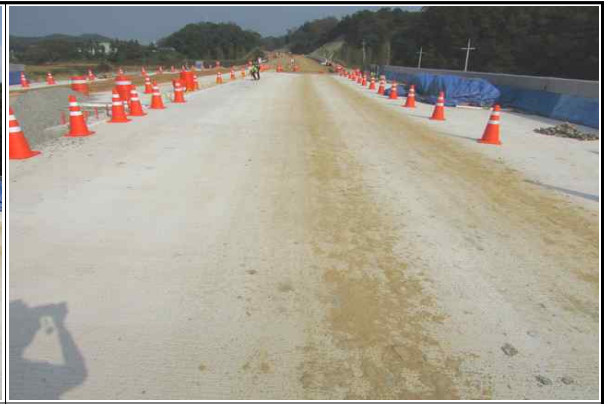
상부슬래브 콘크리트 외관상태 양호 (2016.10.11)
