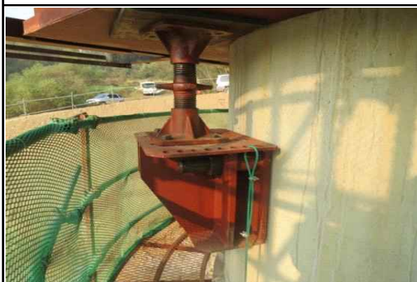
강제거푸집 설치·고정 상태 양호①
