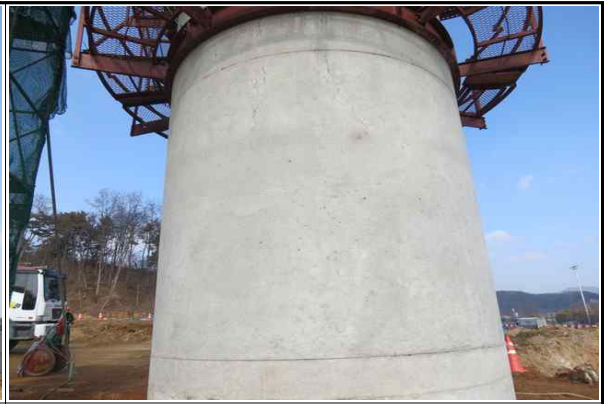
교각 P2 기둥부 시공 상태 양호 (2017.02.06)
