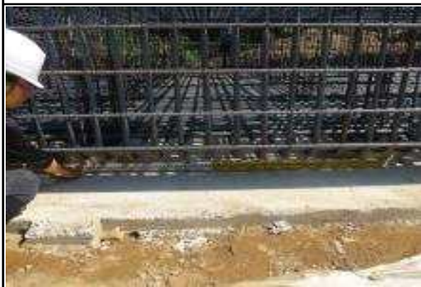
교각 P1 기초 철근배근 상태 확인①
