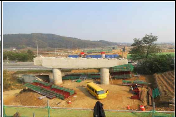
교각 P1 시공 현황 (2015.11)
