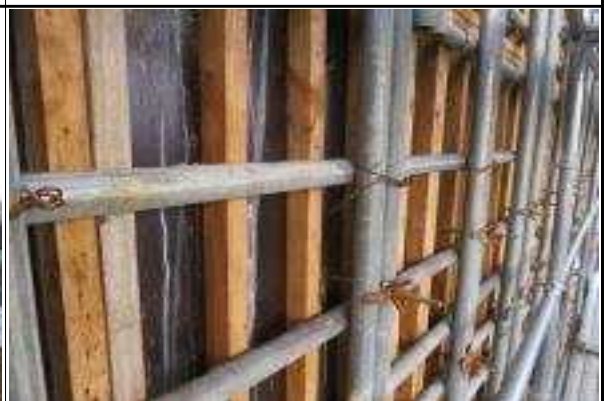
교대 A2 거푸집 설치·고정 상태 양호
