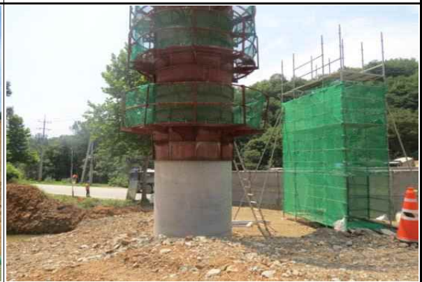
교각 P3 기둥 옥산방향 시공 현황 (2015.06.29)
