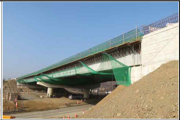
북현3교 상부 시공 현황② (2017.01.03)
