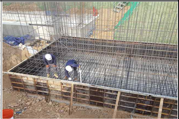
교대 A2(옥산) 기초 거푸집 및 피복두께 측정 현황(2016.03.31)
