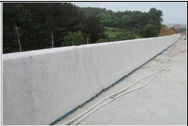
방호벽 노출철근 보호덮개 설치상태 양호 (2016.06.13)
