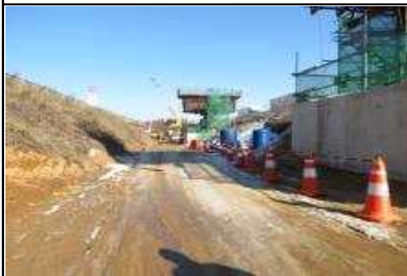
교각 P5~P6 시공현황(14.12.18)
