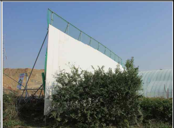
가설방음벽 설치 현황②
