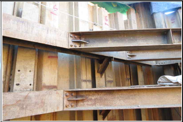
띠장 사보강재 접합부 설치 상태 양호
