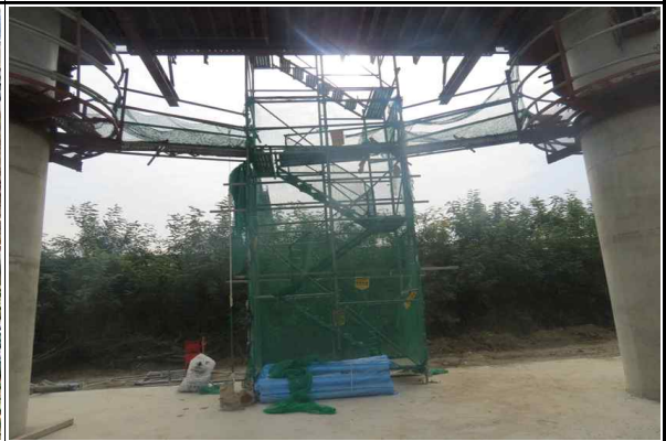
교각 P1 워킹타워 설치 및 고정상태 양호
