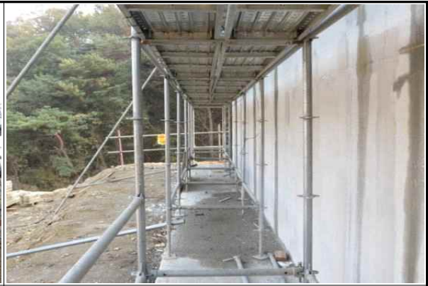
교대 가설비계 설치·고정 상태 양호
