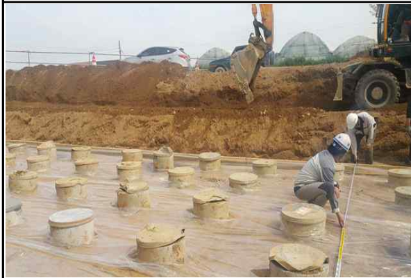
교각 P1 매입PHC말뚝 검측 현황 (2016.04.26)
