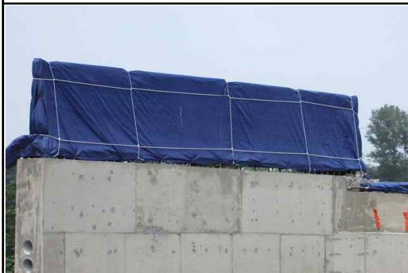
교대 A1 노출철근 보호덮개 설치 현황① (2016.06.13)
