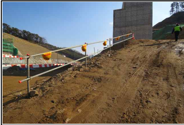
교대 A1 진입로 안전난간 설치 현황①
