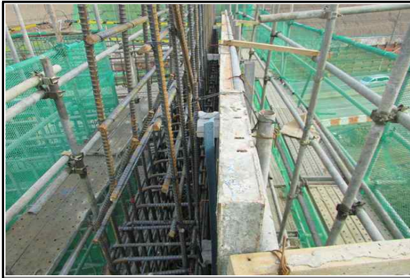
교대 A1 거푸집 설치 및 고정상태 양호①
