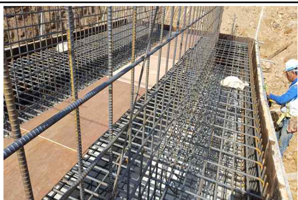
교대 A2 기초 철근배근 및 거푸집 시공 전경②(2016.10.07)
