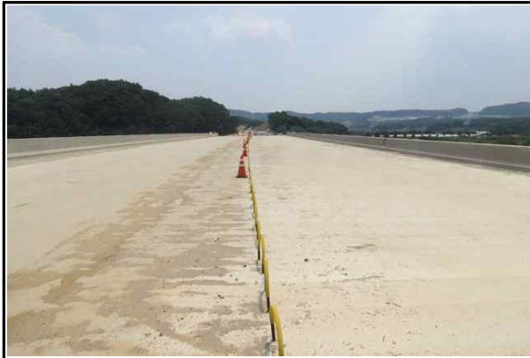
상부슬래브 시공 전경 (17.06.21)
