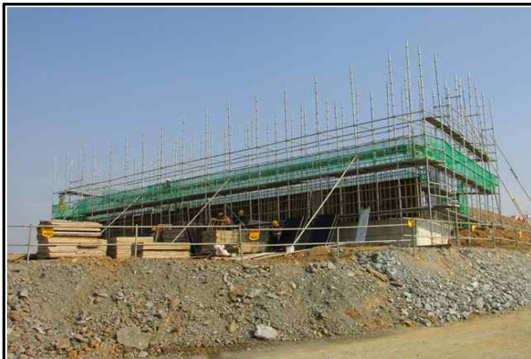
교대 A2 시공 전경① (2016.10.11)
