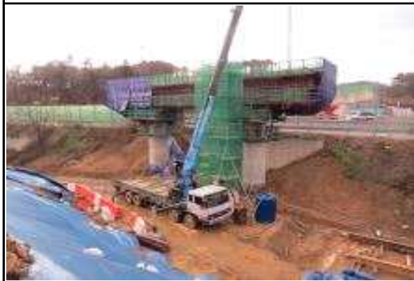
교각 P2 시공 현황 (2015.12)
