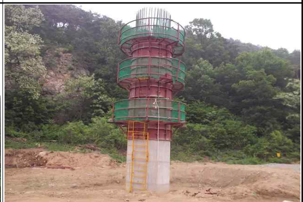
교각 기둥부 강제거푸집 설치 현황②
