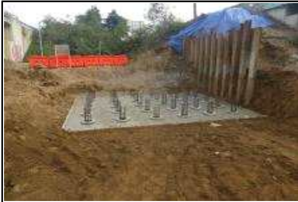
교각 P1 매입PHC말뚝 시공 현황
