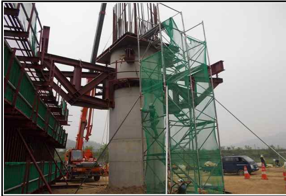
위킹타워 설치 현황①
