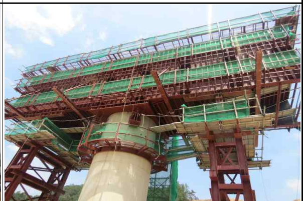
교각 코핑부 강제거푸집 설치 현황②
