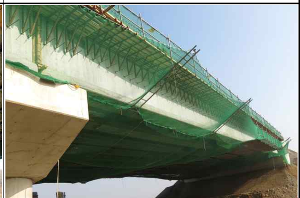
상부 낙하물방지망 설치 현황②
