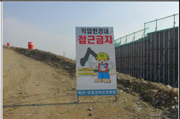
공사현장내 안전표지판 설치 현황
