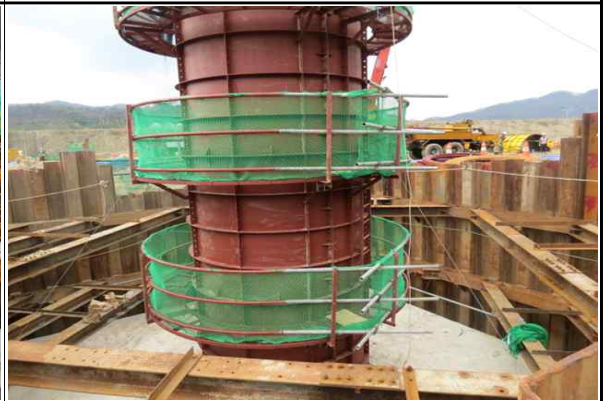
교각 P2(오창) 시공 현황 (2015.04.07)
