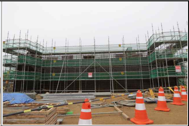
교대 A2 시공 전경 (2016.03.08)
