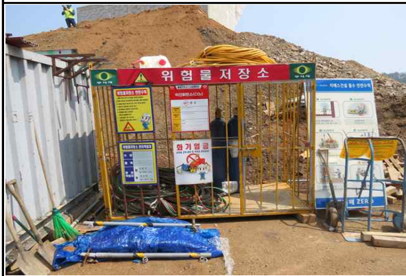
현장내 위험물저장소 설치 및 운용 현황
