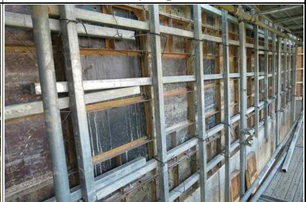
교대 A2 거푸집 설치 및 고정상태 양호②
