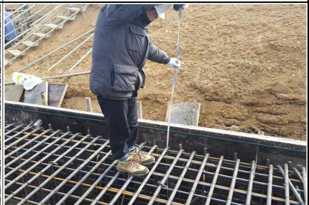
교대 A2(오창) 기초 거푸집 및 피복두께 실측 현황(2016.02.03)
