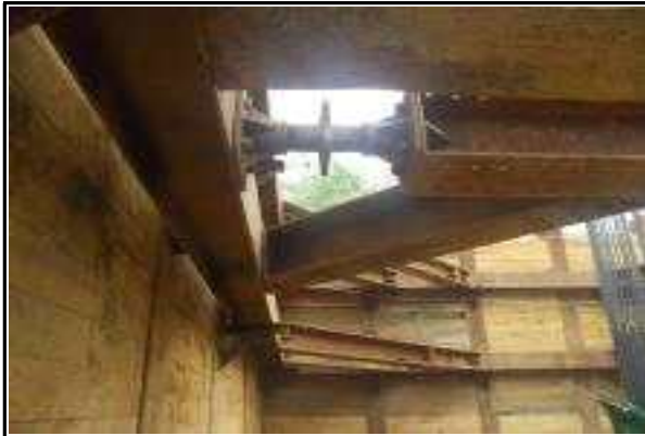
교각 P2(오창) 띠장 사보강재 및 토류판 설치 상태 양호
