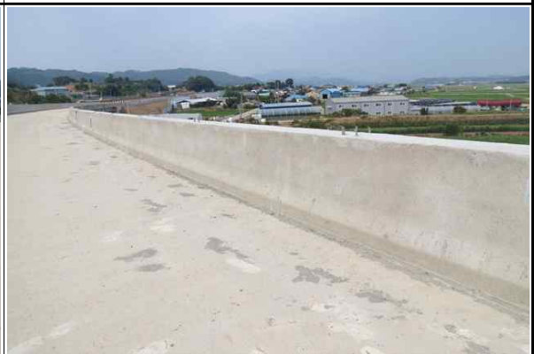
방호벽 시공 전경② (2017.06.21)
