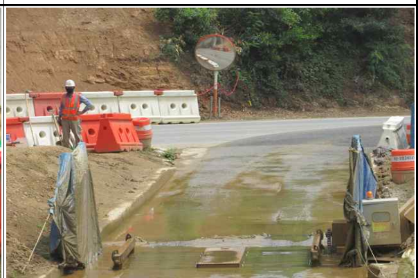
현장 진출입로 세륜기 설치 및 운용 현황
