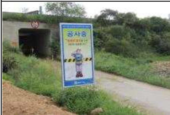
교각 P9 주변 인접도로 안전간판 설치 현황
