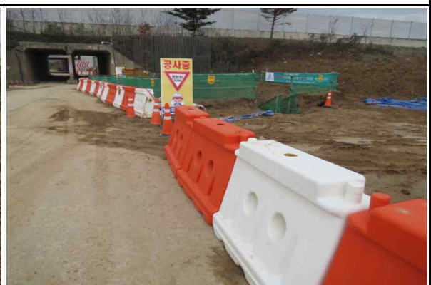
교대 A2 주변 인접도로 안전시설 설치 현황
