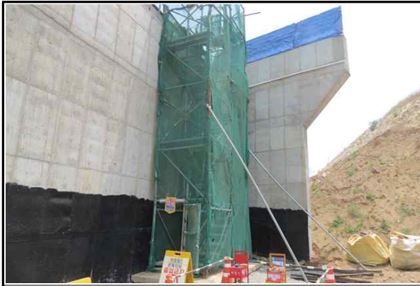
교대 A1 상부 진입을 위한 위킹타워 설치 현황
