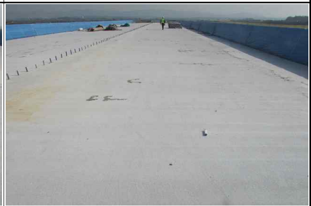
상부슬래브(동서울방향) 시공 현황 (2016.10.11)
