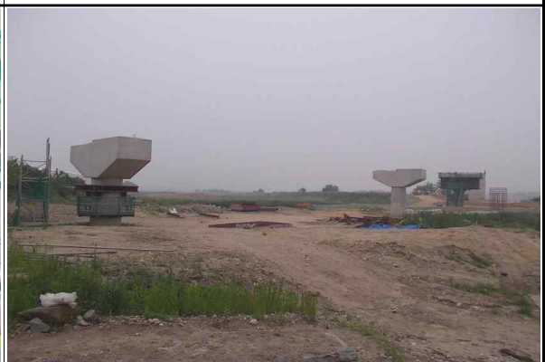
교각 P1~P3 시공 현황(15.05.15)
