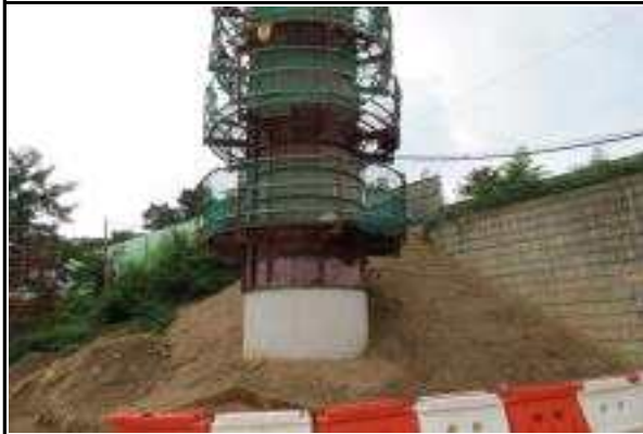
교각 P2(오창) 시공 현황 (2015.09)
