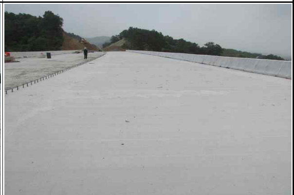
상부슬래브(오창방향) 시공 전경 (2016.06.13)
