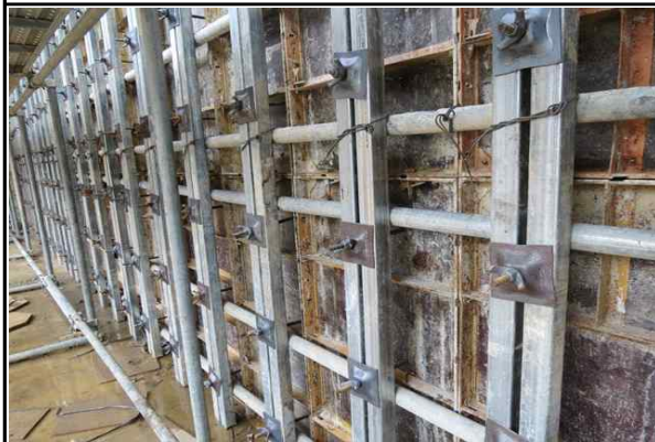
교대 A2 거푸집 설치 현황①
