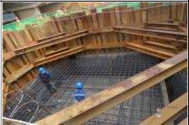
교각 P2 가시설 설치 및 기초철근배근 현황
