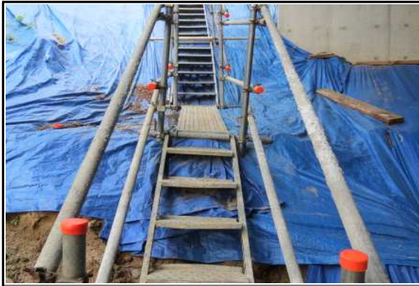
교대 A1 상부진입을 위한 가설계단 설치 현황
