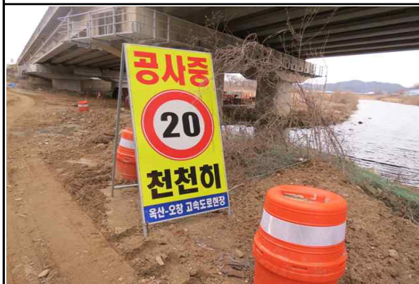
현장내 안전시설 설치 현황④
