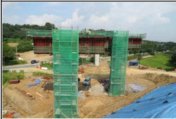
교각 위킹타워 설치 현황
