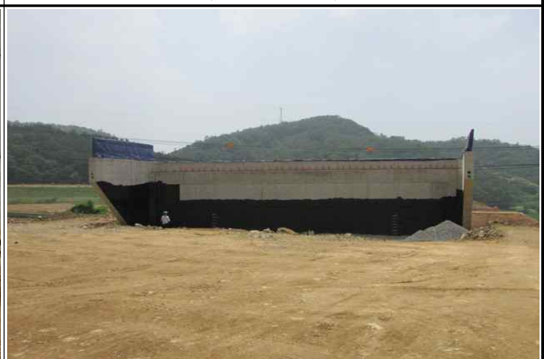
교대 A2 시공 현황② (2016.06.13)
