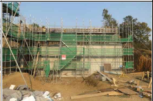
교대 A2 오창방향 시공 현황 (2015.11.03)
