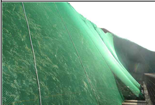
교대 A2 인접 법면 보호망 설치 현황①
