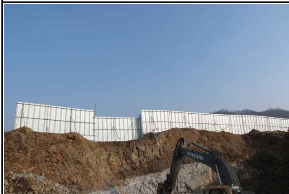
현장 인접도로 주변 안전휀스 설치 현황①
