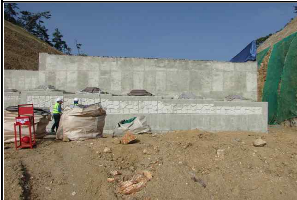
교대 A2(오창방향) 시공 현황 (2016.06.13)
