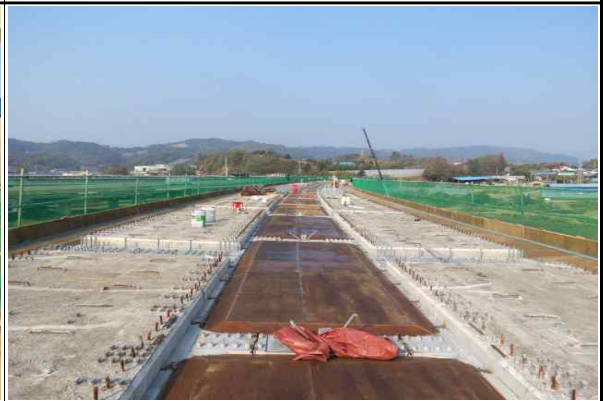
상부 바닥판 거푸집 및 Half-Deck 시공 현황(2015.11.03)
