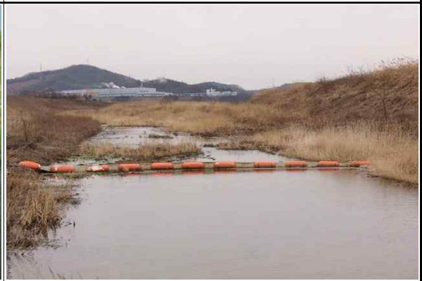
하천 하류부 오탁방지망 설치 현황
