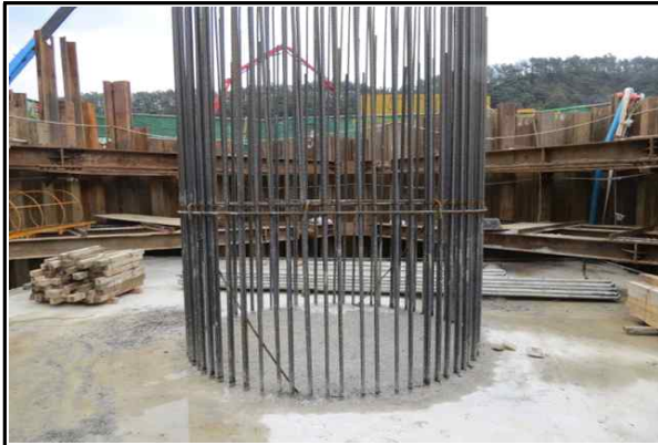
교각 P1(오창) 시공 현황 (2015.04.07)
