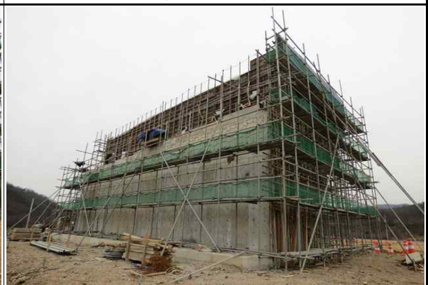
교대 A1(양방향) 시공 현황② (2016.03.08)
