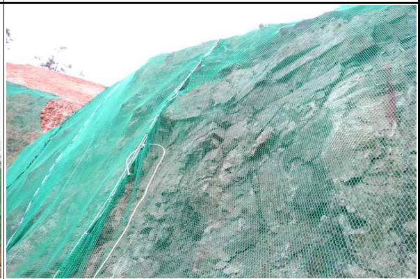
교대 A2 인접 법면 보호망 설치 현황
