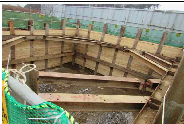
교각 P2 흙막이 가시설 시공 전경 (2016.12.13)
