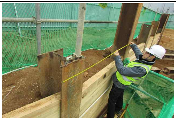
교각 P1 H-Pile 간격 실측 현황
