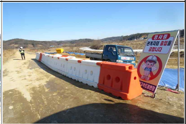
현장내 안전시설 설치 현황
