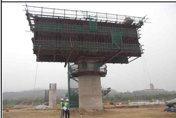
교각 코핑부 강제거푸집 설치 현황①
