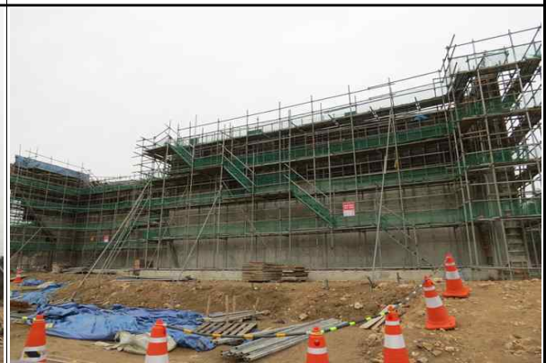
교대 A1 거푸집 및 가설비계 설치 현황②
