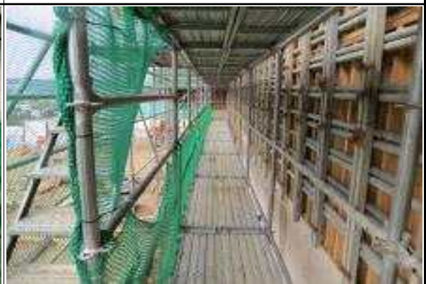
교대 A1 가설통로 설치·고정 상태 양호①
