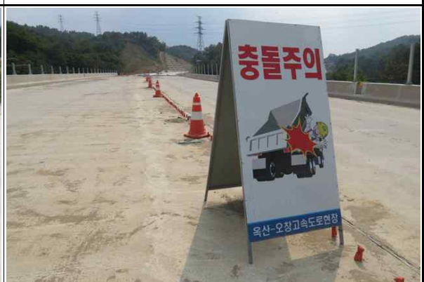
현장내 안전시설 설치 현황②
