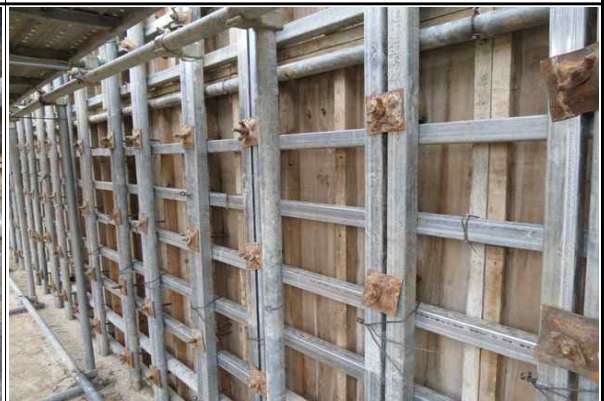
교대 A2 거푸집 설치 현황②
