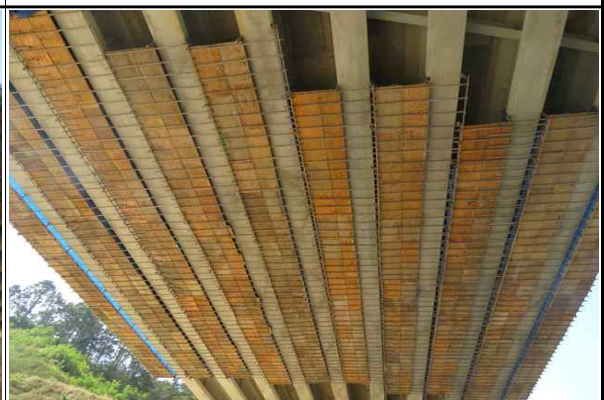
낙하물 방지지설 설치 및 고정상태 양호②
