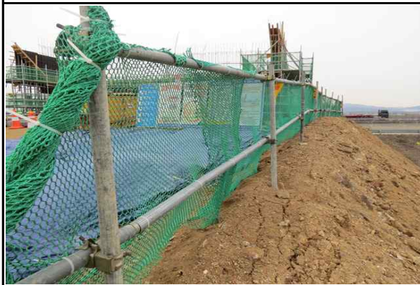
작업장 주변 안전휀스 설치 현황
