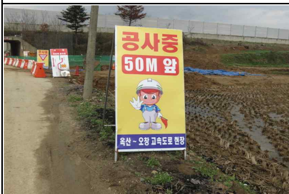
교대 A2 주변 인접도로 안전간판 설치 현황
