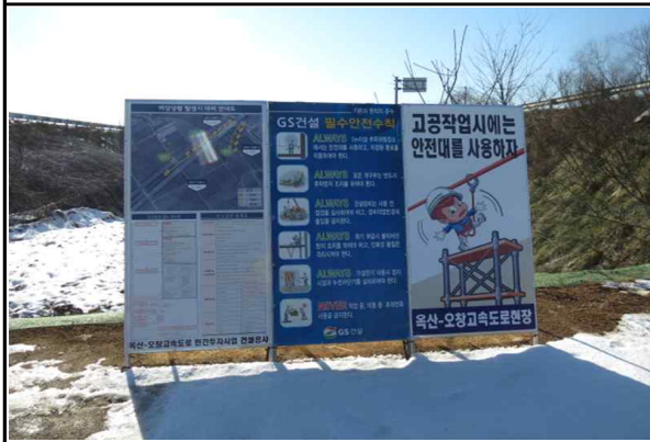
현장내 안전간판 설치 현황①
