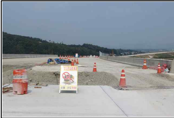
현장내 안전시설 설치 현황
