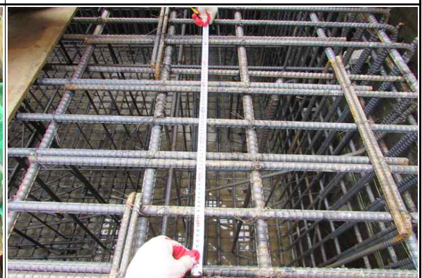
교각 P2 기초 철근배근간격 확인 (2017.01.12)
