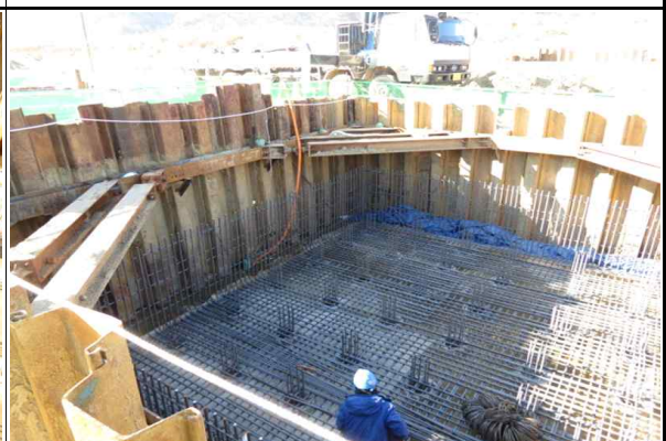
교각 P2(옥산방향) 기초철근 조립 중 현황
