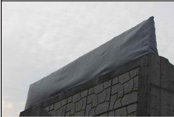
교대 A2 노출철근 보호덮개 설치 현황① (2016.12.13)
