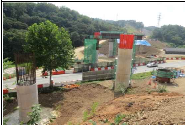
교각 P1~P3 시공 현황 (2015.09.04)
