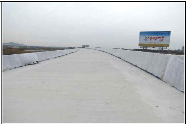
상부슬래브 시공 현황② (2016.03.08)
