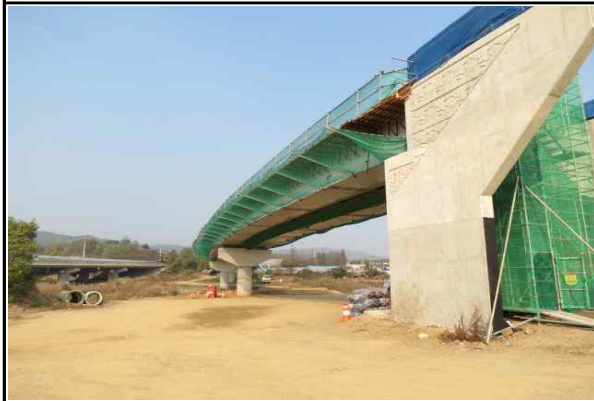
시점부 시공 현황 (2015.11.03)
