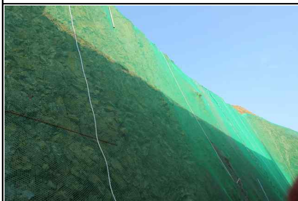
교대 A2 인접 법면 보호망 설치 현황①
