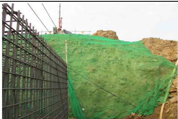
교각 P2 인접 법면 보호망 설치 현황②
