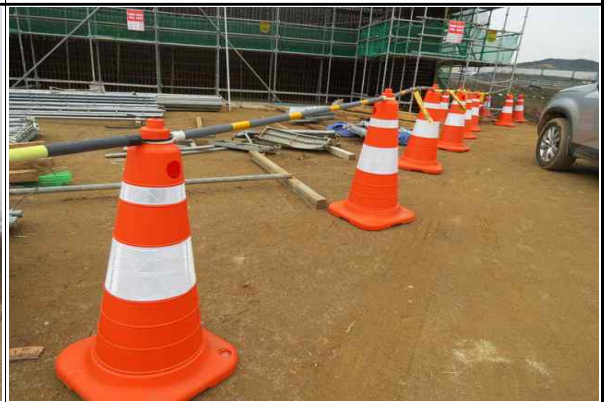
현장내 안전시설 설치 현황②
