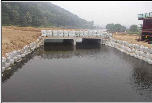
현장내 PC BOX(임시 배수관) 시공 현황
