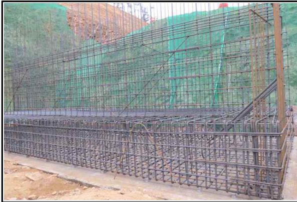
교대 A2(옥산) 기초 철근배근 현황 (2016.03.08)
