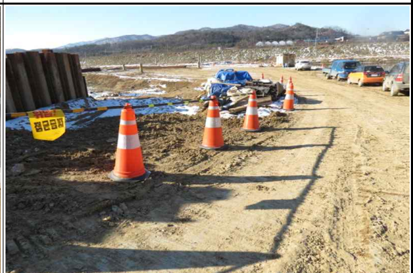
현장내 안전시설 설치 현황
