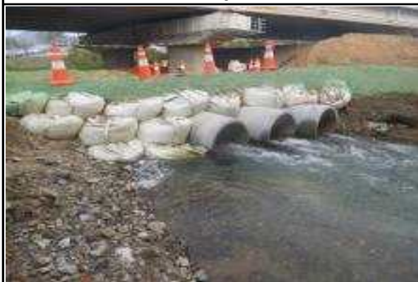
가설도로 및 배수관로 설치 현황
