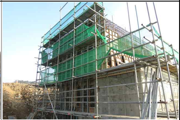
교대 A2 가설비계 설치 현황②
