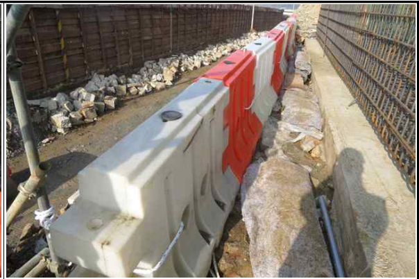
교대 A2 작업장 주변 안전시설(PE방호벽) 설치 현황②
