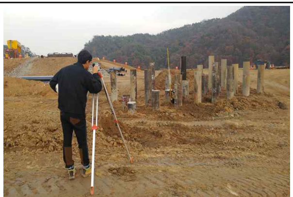
교대 A2 내부굴착강관말뚝 검측 현황② (2016.11.14)
