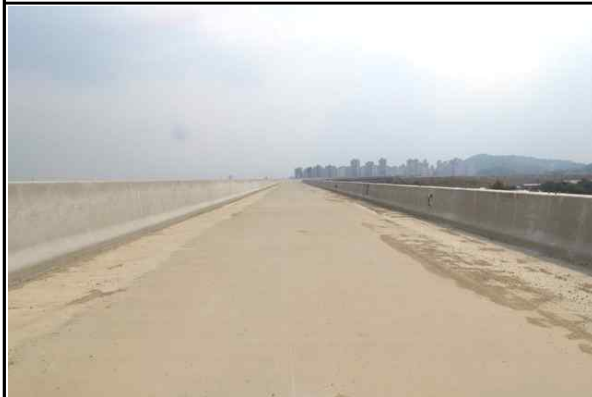
상부슬래브 S1~S10 시공 전경① (2017.06.21)
