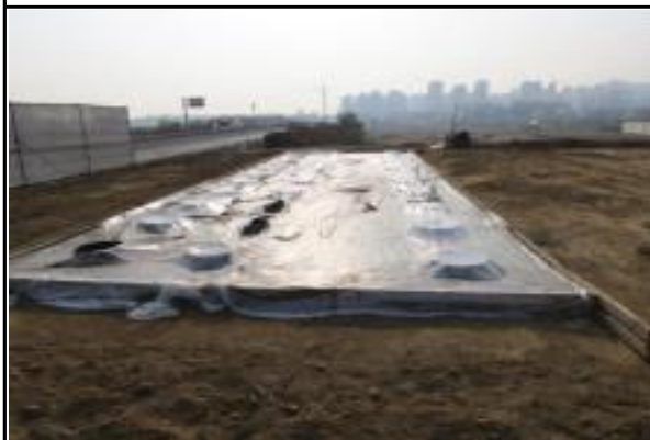
교대 A1 기초 시공 전경
