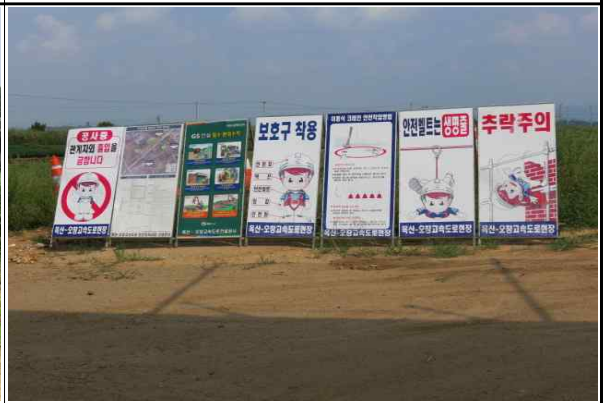
현장내 안전간판 설치 현황
