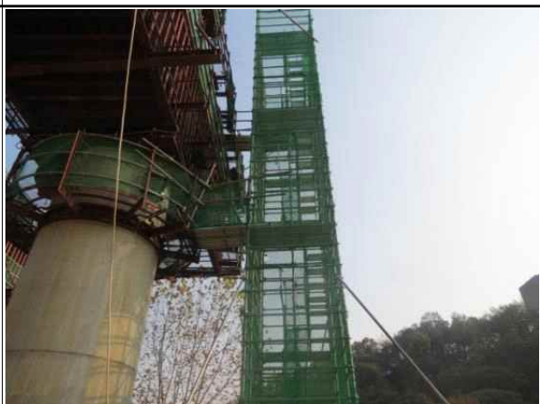
교각 워킹타워 설치·고정 상태 양호
