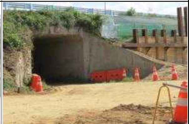
교각 P5 주변 인접도로 안전시설 설치 현황
