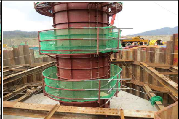
교각 P2(오창) 시공 현황 (2015.04.07)
