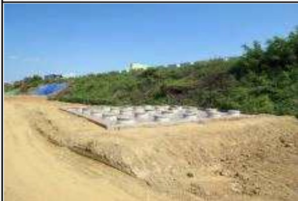
교각 P7 매입PHC말뚝 시공 현황
