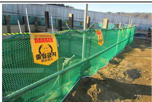
교각 P2 가시설 주변 추락방지를 위한 안전휀스 설치 현황②
