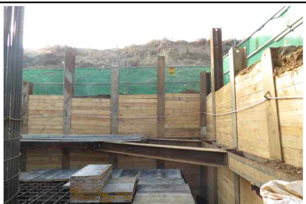
교각 P1 흙막이 가시설 시공 현황②
