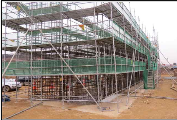
교대 A1 가설비계 설치 현황①
