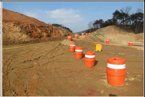
현장내 안전시설 설치 현황
