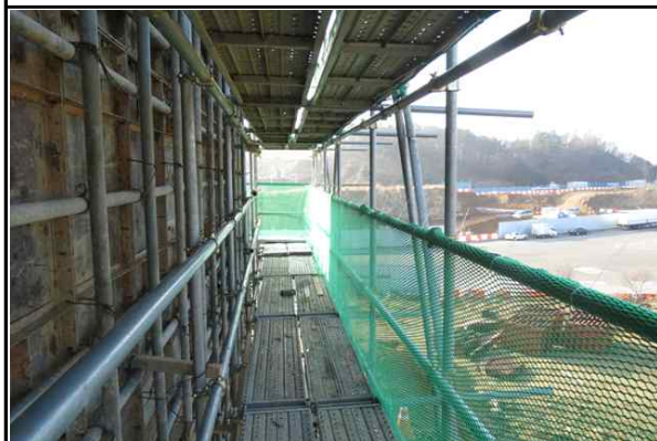
교대 A1 가설통로 설치 상태 양호
