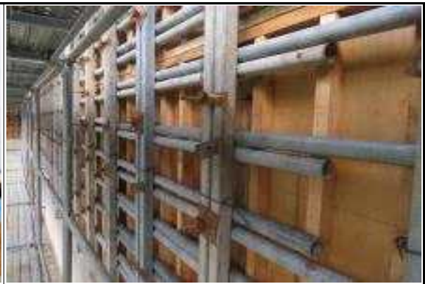
교대 A1 거푸집 설치·고정 상태 양호
