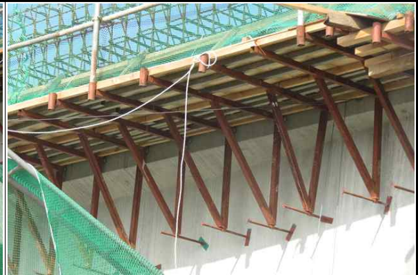
거푸집 설치 및 고정상태 양호
