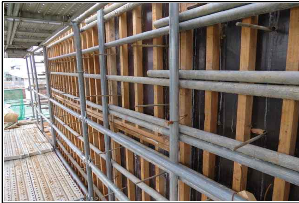
교대 A1 구체 거푸집 설치 현황
