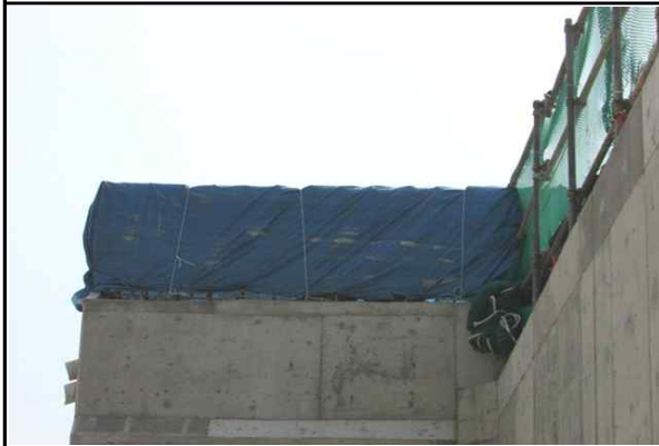
교대 A2 노출철근 보호덮개 설치 현황 (2016.06.13)
