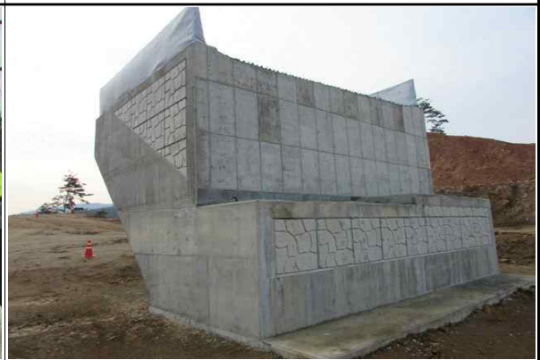
교대 A2 시공 전경 (2016.12.13)
