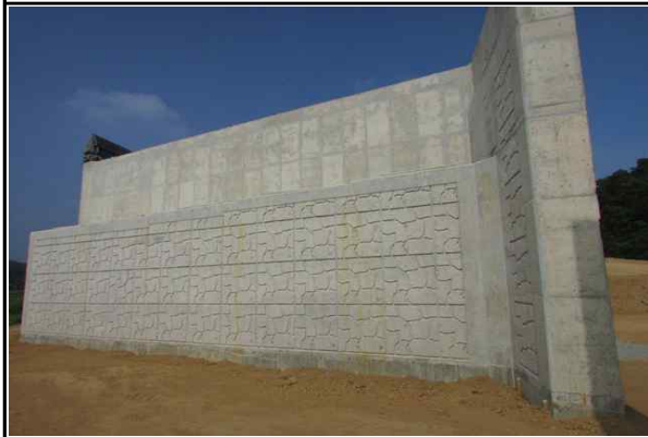
교대 A2(옥산방향) 시공 전경① (2016.06.13)
