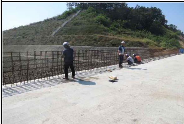
상부 방호벽 철근배근 현황① (2016.12.13)
