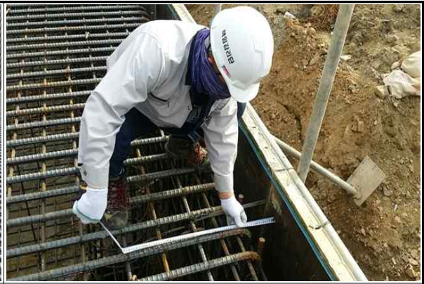
교대 A1(옥산) 기초 피복두께 실측 현황 (2016.04.27)
