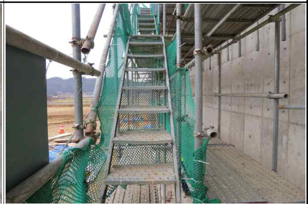
가설계단 설치 및 고정상태 양호
