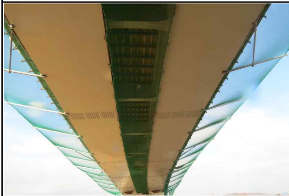
상부 추락방지망 설치 현황
