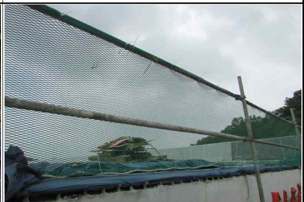
상부 안전난간 설치상태 양호
