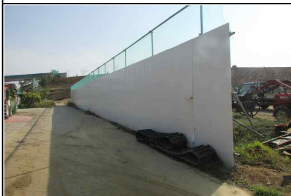
인접 농가시설 주변 안전휀스 설치 현황③
