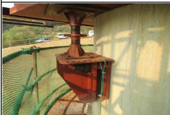
강제거푸집 설치·고정 상태 양호①
