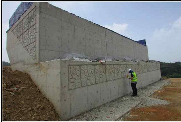
교대 A1 시공 현황① (2016.06.13)
