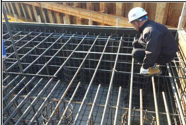
교대 A2(옥산) 기초 철근배근 실측 현황 (2016.02.03)
