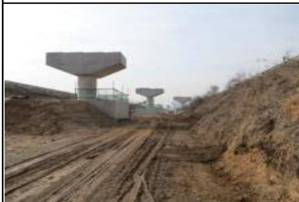
교각 P6~P8 시공현황(15.02.03)
