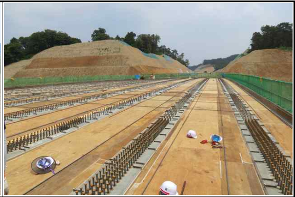
상부 바닥판 거푸집 설치 완료 (2017.06.21)
