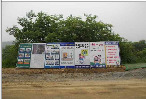
현장내 안전간판 설치 현황
