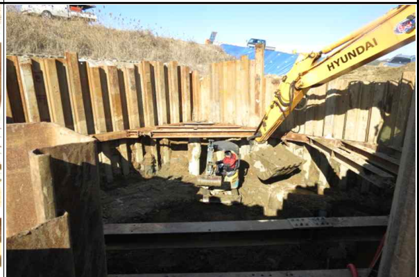
교각 P1(옥산방향) 기초 터파기 시공 현황
