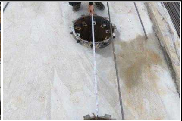
교대 A1 강관말뚝 제원 및 간격 확인 전경 (2015.09.04)
