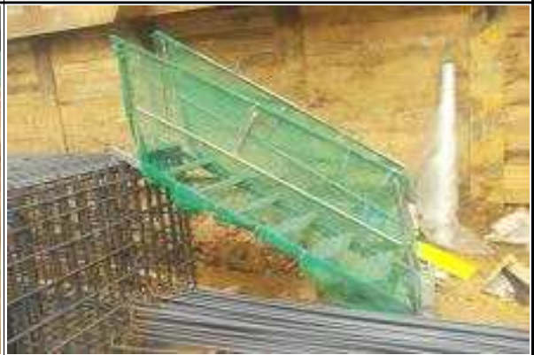
기초 시공을 위한 가설계단 설치 상태 양호
