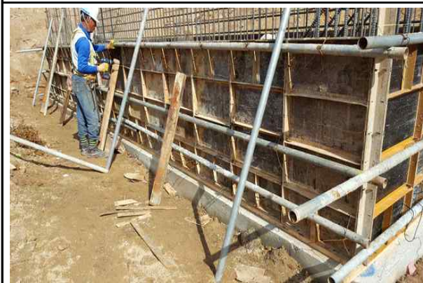
교대 A2 기초 거푸집 설치 현황①
