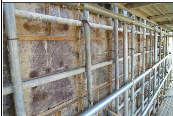
교대 A1 거푸집 설치 상태 ①
