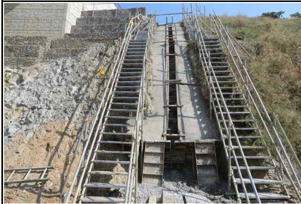
교대 A2 상부진입을 위한 가설계단 설치 현황
