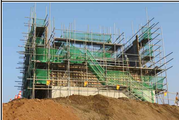
교대 A1 시공 전경① (2017.01.03)
