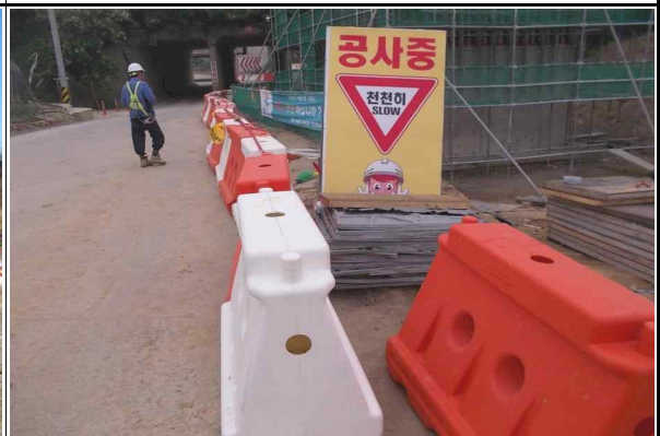
교대 A2 주변 인접도로 안전시설 설치 현황
