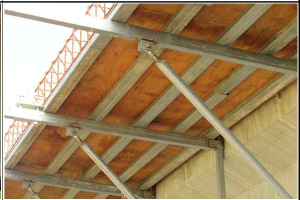
캔틸레버부 거푸집 설치 상태 양호
