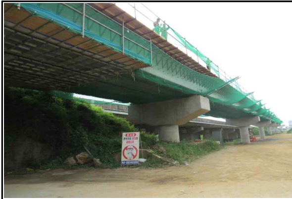
S1~S6 거더 거치 시공 현황 (2015.09.04)
