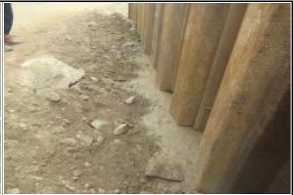
교각 P3 가시설 배면 지반 상태
