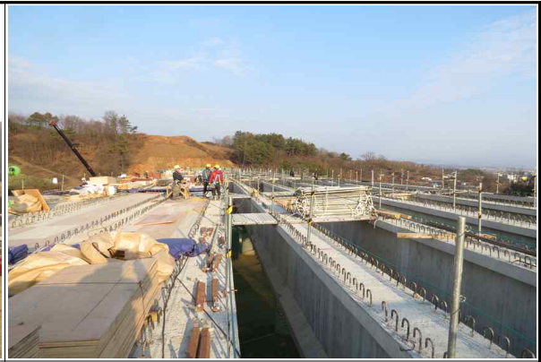
전 경간(S1~S4) 거더 거치 완료 (2015.12.11)
