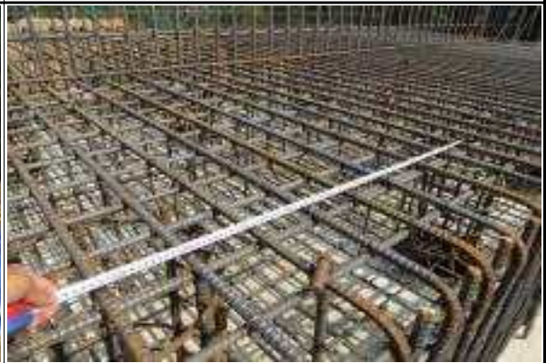
교대 A1 기초(오창) 철근배근간격 확인 전경(2015.09.04)
