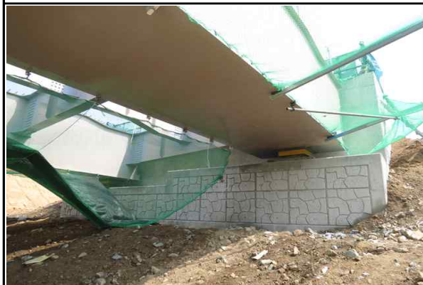
교대 A1 시공 전경 (2017.04.07)
