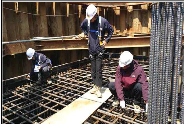
교각 P1(오창) 기초 철근배근간격 실측 현황(2015.04.02)
