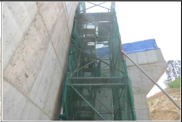
위킹타워 설치 및 고정 상태 양호
