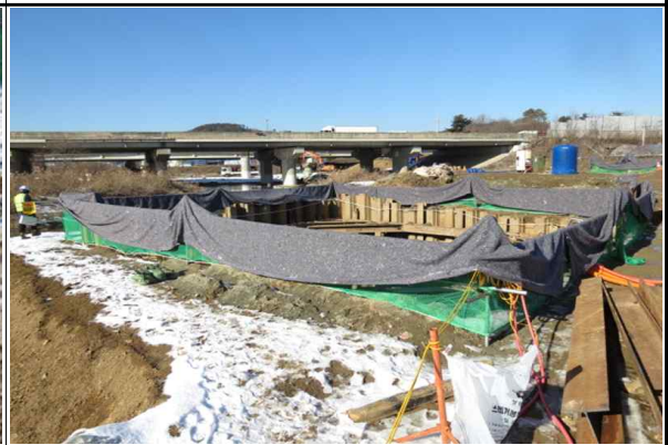
교각 P2 흙막이 가시설 시공 현황
