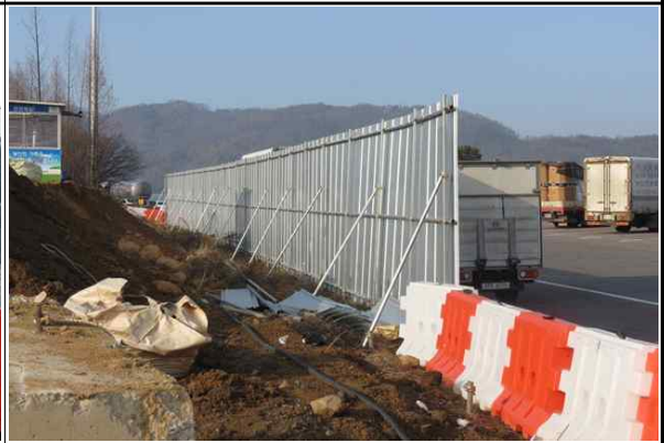
현장 인접도로 주변 안전휀스 및 PE방호벽 설치 현황②
