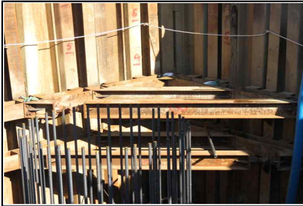
띠장 사보강재 설치 상태 양호
