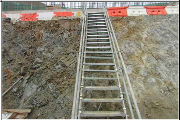
교대 A2 가설계단 설치 및 고정상태 양호
