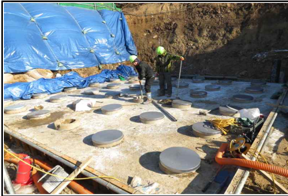
교각 P4(옥산) 매입PHC말뚝 시공 현황 (2014.12.18)
