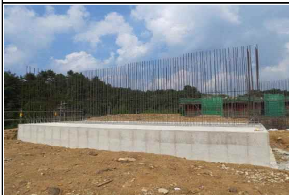
교대 A1 옥산방향 시공 현황 (2015.09.04)
