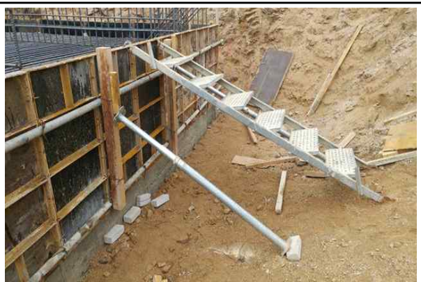
교대 A1 가설계단 설치 상태
