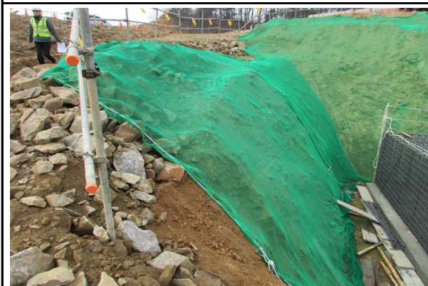
교각 P2 인접 법면 보호망 설치 현황①
