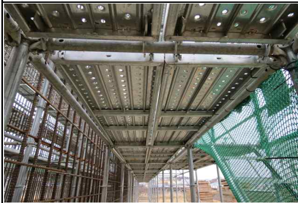
작업발판 설치 및 고정상태 양호
