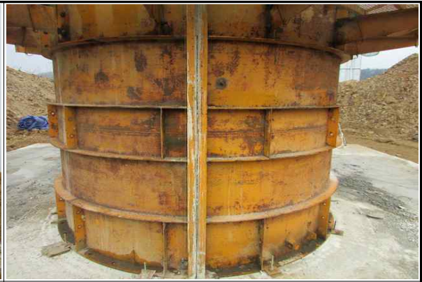
교각 P2 기둥부 강재거푸집 설치 상태②
