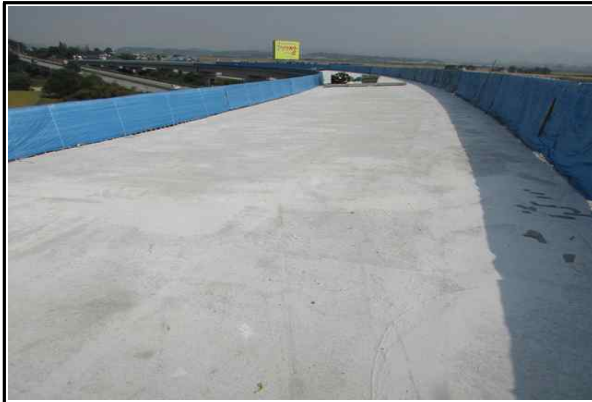
상부슬래브 S7~S10 콘크리트 타설 완료 (2016.10.11)
