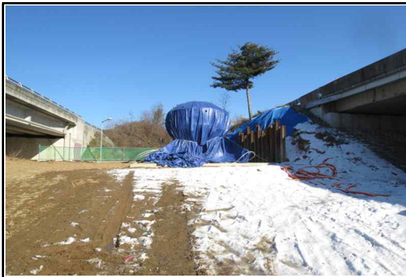
교각 P1 시공현황(14.12.18)
