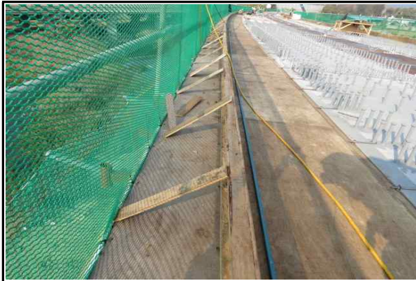
바닥판 캔틸레버부 거푸집 설치 및 고정상태 양호
