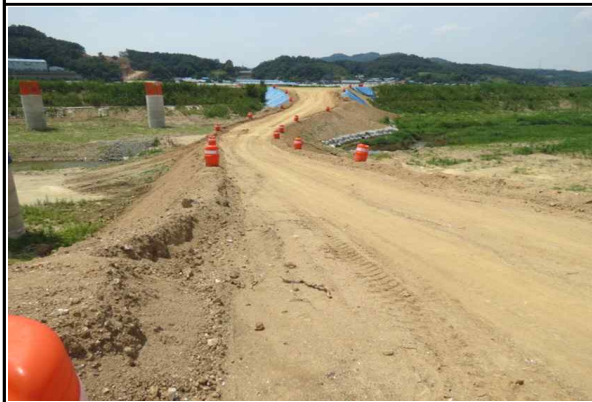
가설도로 다이크 주변 안전시설 설치 현황
