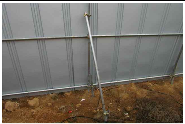
안전휀스 설치 및 고정상태 양호②
