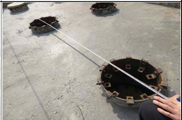
교대 A2 매입강관말뚝 제원 및 간격 확인 (2016.02.04)
