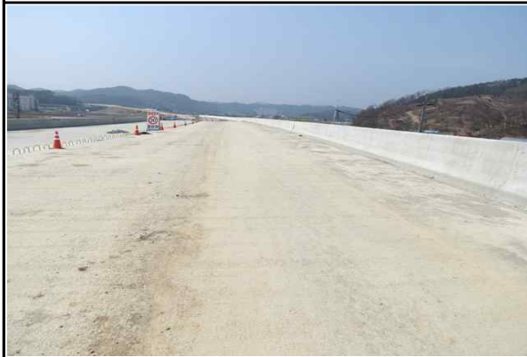
상부슬래브(옥산방향) 시공 전경 (2017.04.07)
