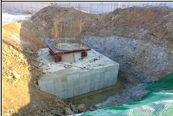
교각 P1 시공 전경 (2017.02.14)
