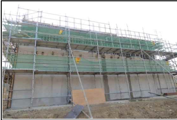
교대 가설비계 설치 현황
