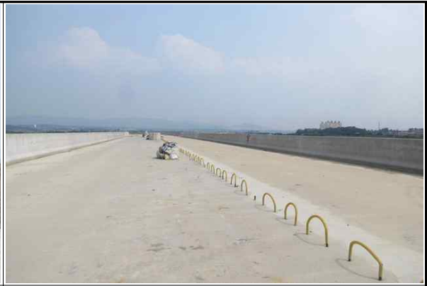
상부슬래브 및 방호벽 시공 현황② (2017.06.21)
