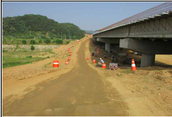
현장내 안전시설 설치상태 양호①
