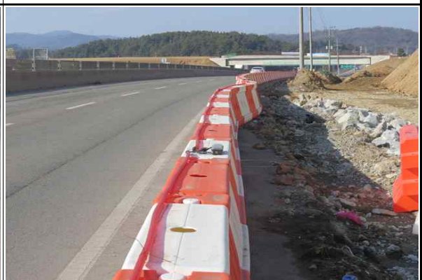
인접도로 주변 안전시설(PE방호벽) 설치 현황②
