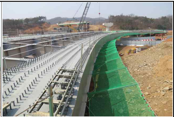
상부 거더(S1~S3) 거치 현황② (2017.04.07)
