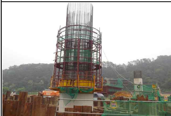
교각 기둥부 강제거푸집 설치 현황①
