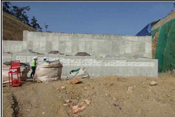
교대 A2(오창방향) 시공 현황 (2016.06.13)
