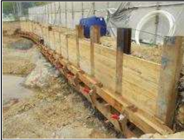
교각 P2 흙막이 시공 현황
