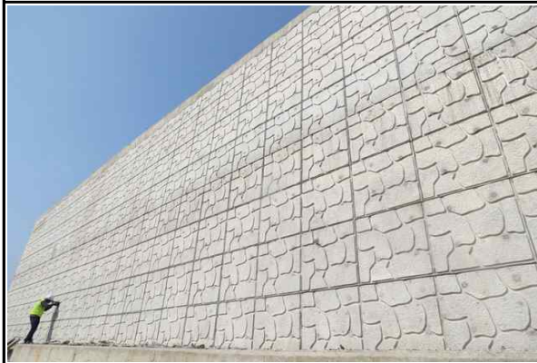
교대 A2 전면부 시공 전경 (2017.04.07)
