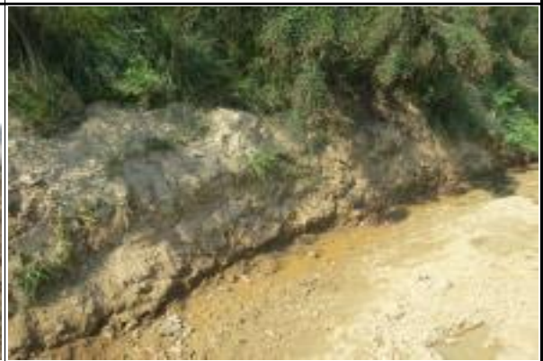
교각 P1 측면 가배수로 설치 현황①
