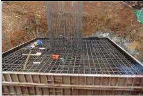
교각 P3 기초(옥산) 시공 현황 (2015.04.07)
