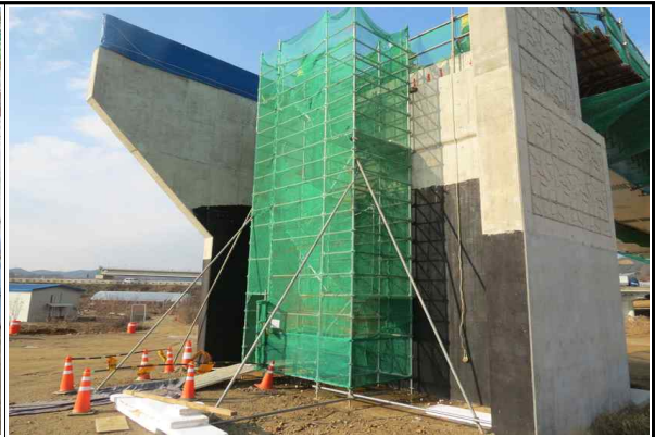
교대 A1 워킹타워 설치 현황
