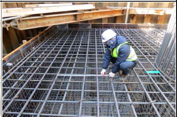
교각 P3(옥산) 기초 철근배근간격 실측 (2015.03.04)
