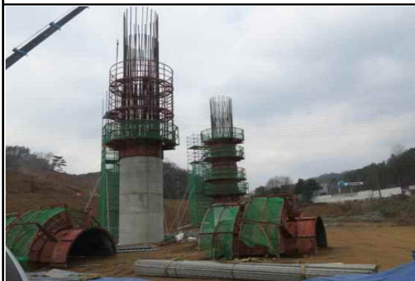
교각 기둥부 강제거푸집 설치 현황
