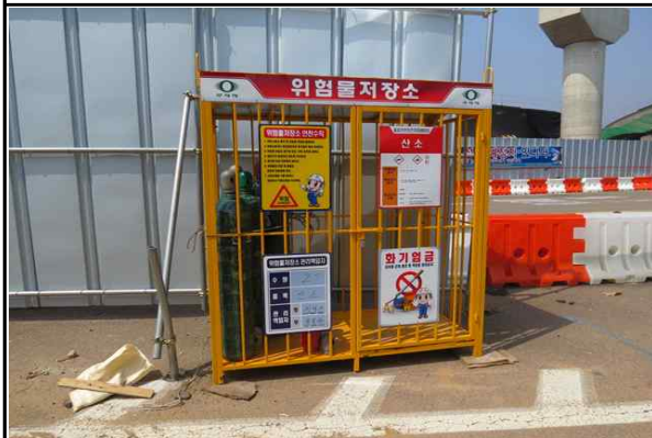
현장내 위험물저장소 설치 및 운용 현황
