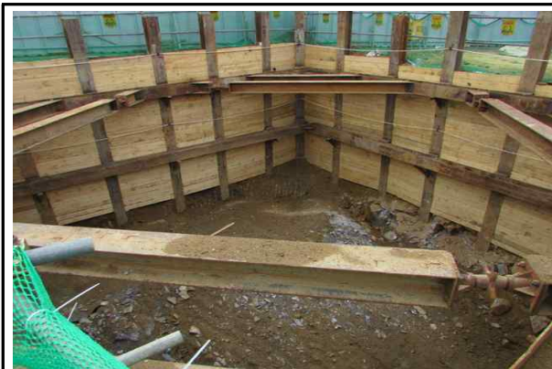
교각 P1 흙막이 가시설 시공 현황①
