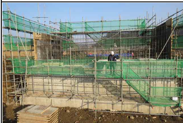
교대 A1 가설비계 설치 현황①
