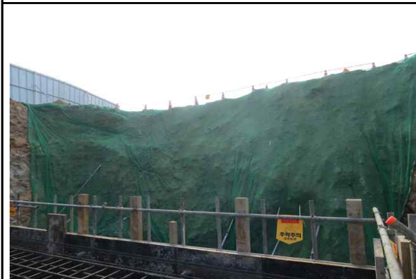
교각 P1 인접 법면 보호망 설치 현황①
