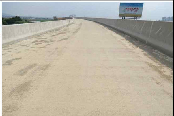
상부슬래브 시공 전경② (2017.06.21)
