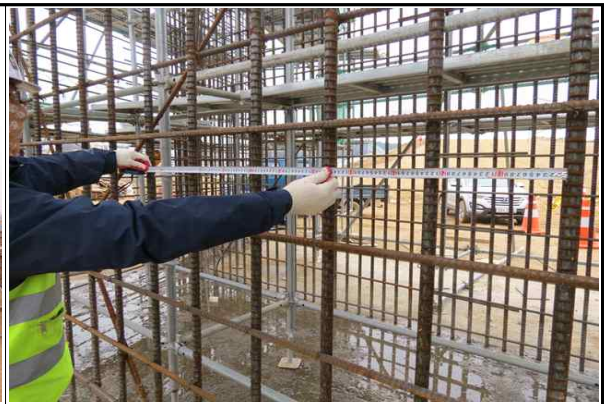
교대 A1 구체 철근 배근간격 확인 (2016.03.08)
