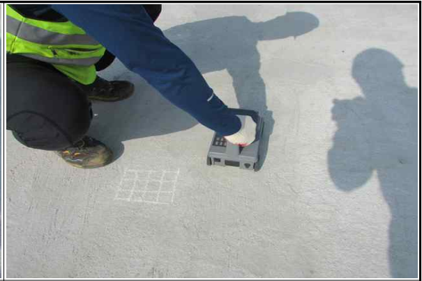
철근배근탐사 시험 현황②
