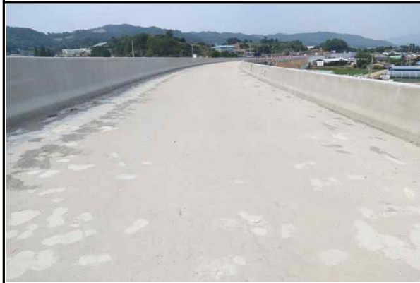
상부슬래브 시공 전경① (2017.06.21)
