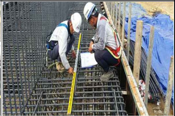
교대 A2 기초 철근배근간격 확인 전경 (2015.10.06)
