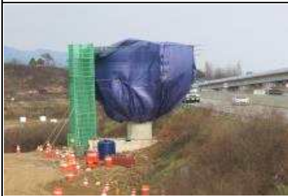
교각 P9 시공현황(15.12.11)
