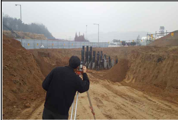
교각 P1 내부굴착강관말뚝 검측 현황① (2016.11.18)
