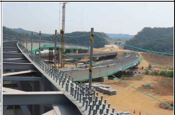
상부공 작업을 위한 추락방지 안전시설 설치 현황②
