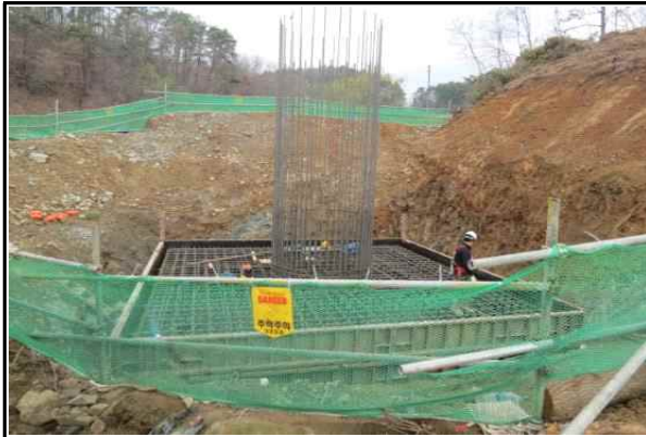
현장주변 안전난간 설치상태 양호
