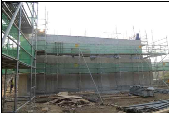
교대 A1 옥산방향 시공 현황 (2015.11.03)
