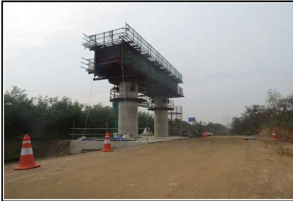
교각 P1 시공 전경① (2014.10.30)
