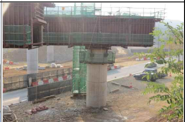
교각 코핑부 강제거푸집 설치 현황
