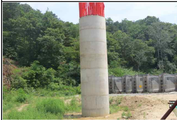
교각 P4(오창) 시공 현황 (2015.06.29)
