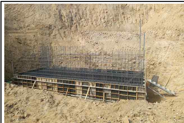
교대 A1 기초 철근배근 및 거푸집 시공 전경①(2016.10.20)
