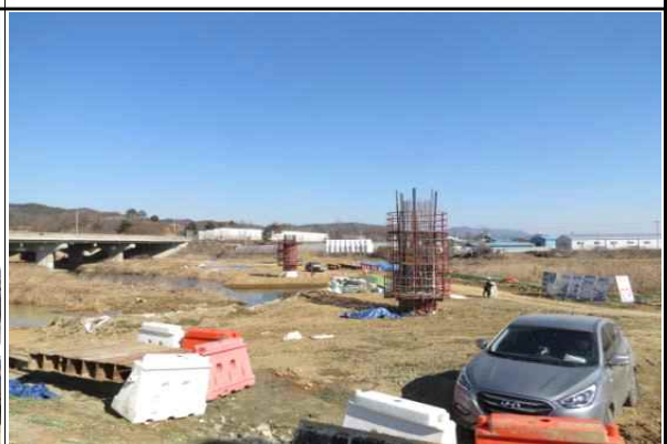
교각 P1~ P3 시공 현황(15.02.13)
