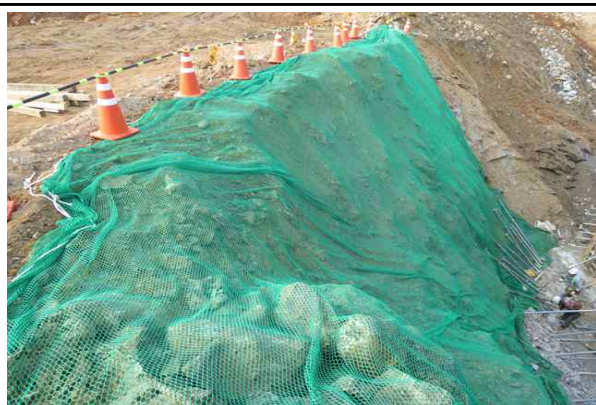
교각 P1 인접 법면 보호망 설치 현황②
