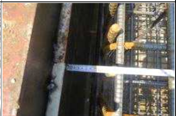
교각 P2 기초 피복두께 확인 전경 (2015.06.29)
