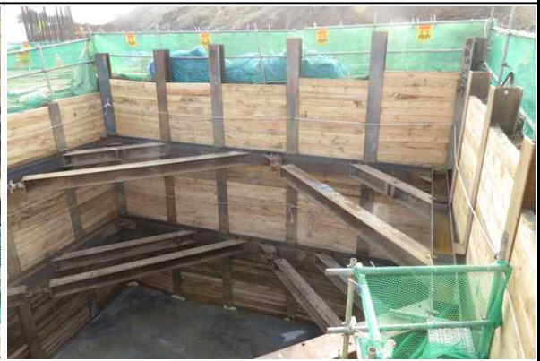
교각 P2 흙막이 가시설 시공 현황②
