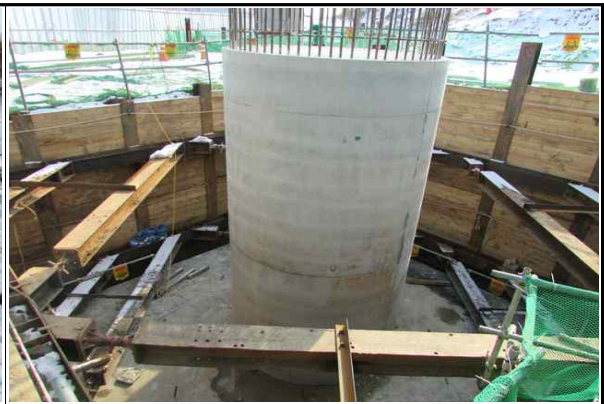
교각 P2 시공 현황② (2017.01.23)
