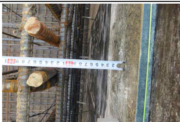
교각 P1 기초 피복두께 확인 (2017.02.06)
