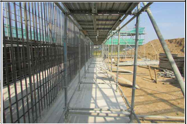
교대 A2 가설비계 설치 현황②
