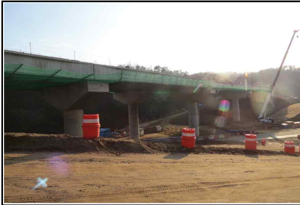
상부 시공 전경 (2015.12.11)
