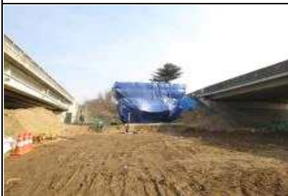
교각 P1 시공현황(15.02.03)
