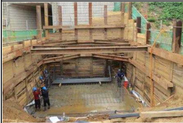
교각 P2(옥산) 기초 시공 현황 (2015.09.04)
