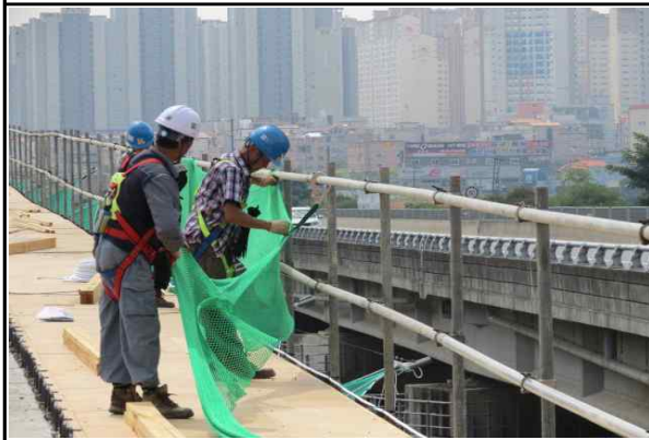
상부 안전Net 설치 현황
