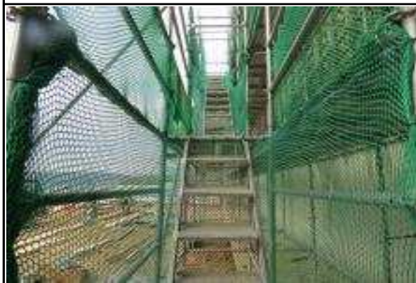
교대 A1 가설통로 설치·고정 상태 양호①
