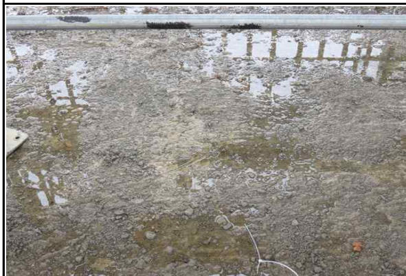
교대 A1 신·구 콘크리트 접합부 치핑상태 양호① (16.03.08)
