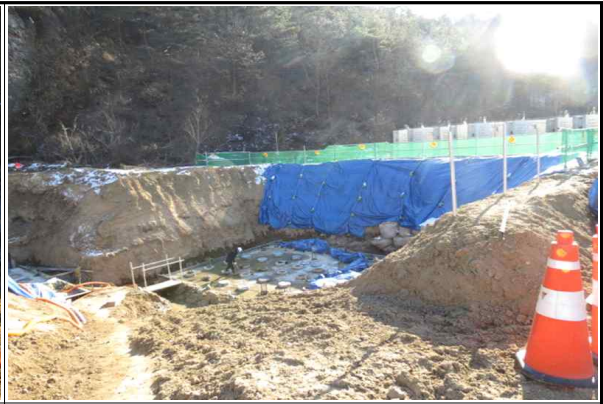
교각 P4(오창) 매입PHC말뚝 시공 현황 (2014.12.18)
