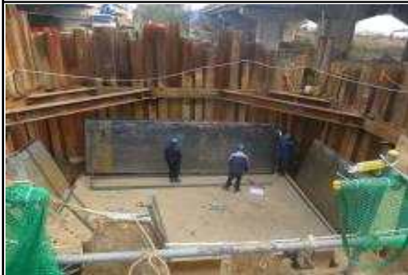
교각 P3 기초 가시설 설치 및 시공현황
