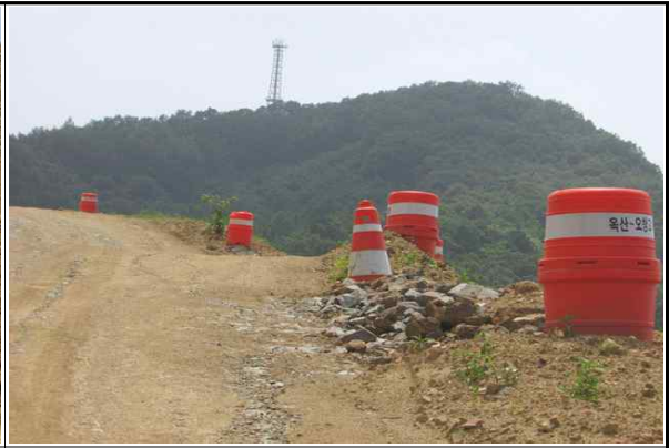
현장내 안전시설 설치상태 양호①
