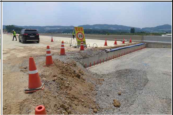
현장내 안전시설 설치상태 양호④
