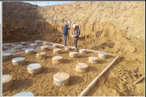
교각 P1 내부굴착강관말뚝 검측 현황② (2016.11.18)
