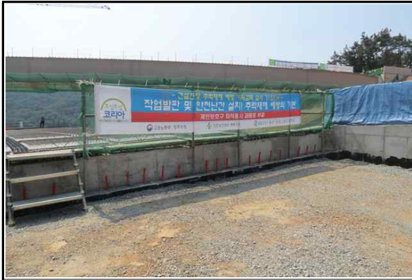
시점측 진입부 안전시설 설치 현황
