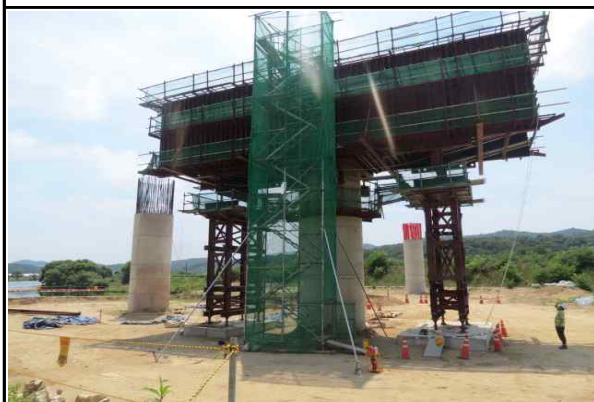
교각 코핑부 시공을 위한 가설벤트 및 워킹타워 설치 현황
