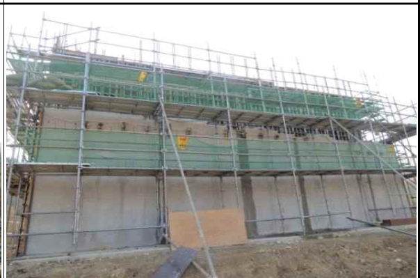
교대 A2 오창방향 시공 현황 (2015.11.03)
