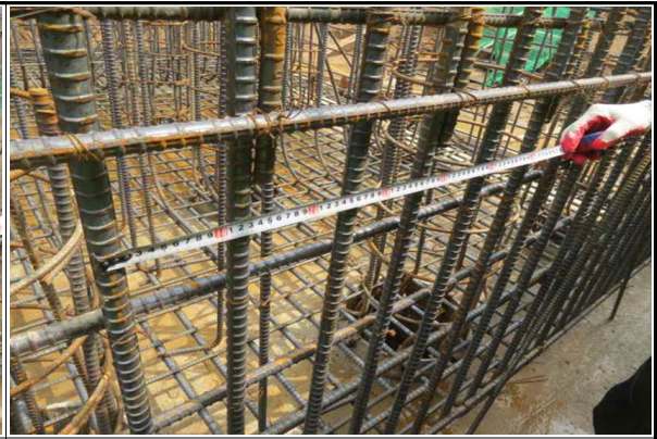
교대 A2 기초 철근배근간격 확인 전경
