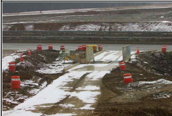
현장 진출로 세륜기 설치 및 운용 현황
