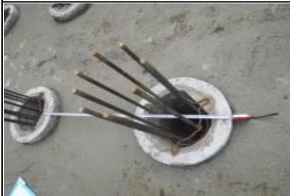
교각 P1 매입PHC말뚝 제원 및 간격 실측
