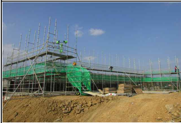
교대 A2 가설비계 설치 현황①
