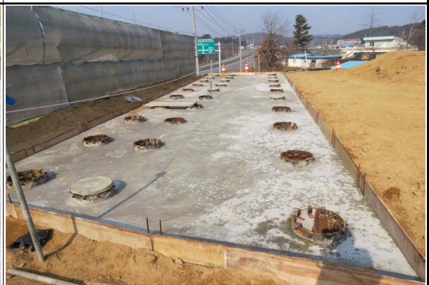
교대 A2 기초 말뚝 시공 전경 (2016.02.04)
