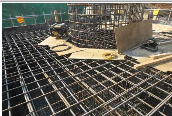
교각 P1 기초 철근배근 및 거푸집 시공 전경② (2017.02.06)
