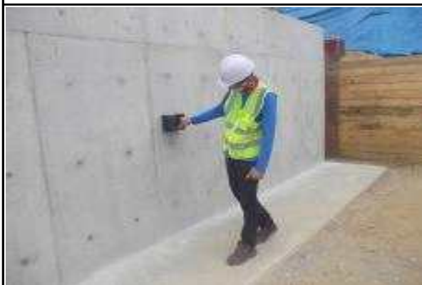
철근배근탐사 시험 현황①
