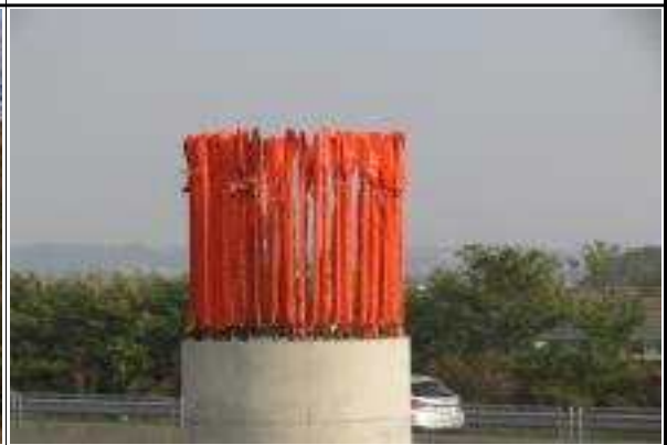
기둥부 노출철근 보호덮개 설치 현황(15.11.03)
