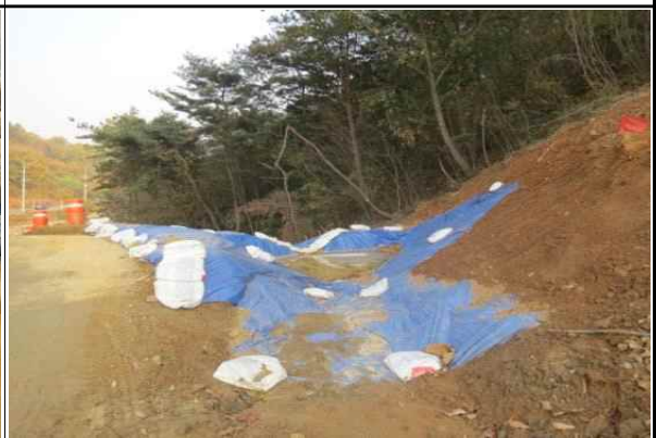
침사지 설치 현황
