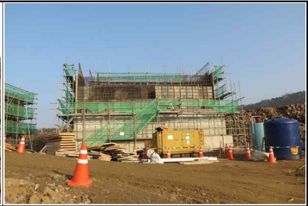
교대 A2 시공 전경 (2017.01.03)
