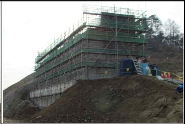
교대 A1 시공 전경② (2016.12.13)
