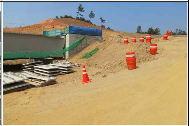
현장내 안전시설 설치 현황①
