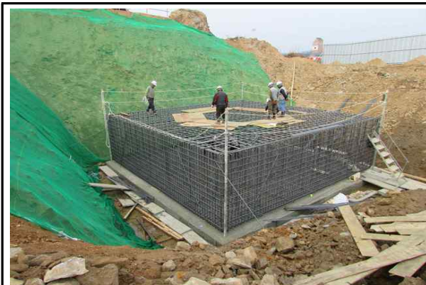
교각 P2 기초 철근배근 시공 현황 (2016.11.25)
