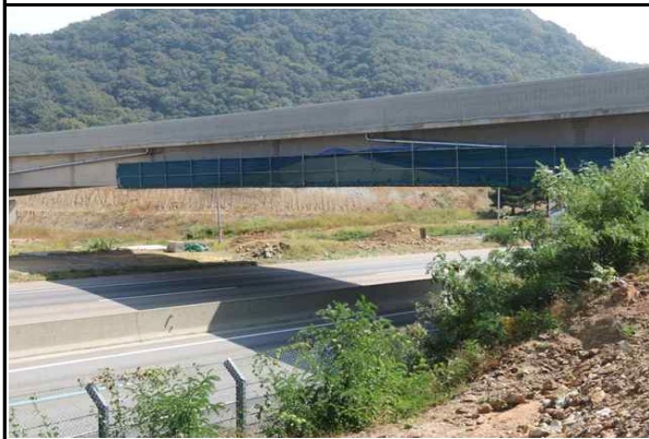
상부 낙하물방지시설 설치 전경
