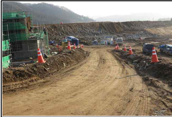
현장내 안전시설 설치 현황
