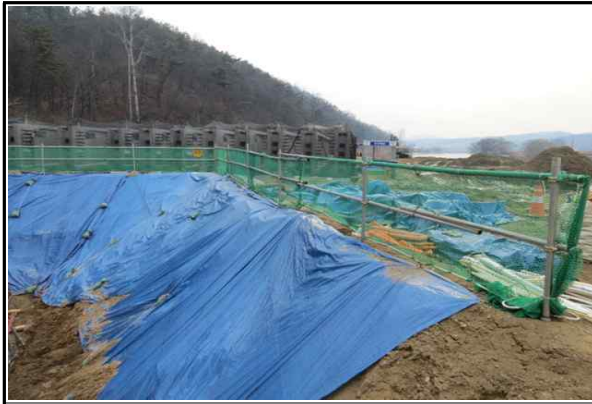
공사장 주변 안전시설 설치 현황
