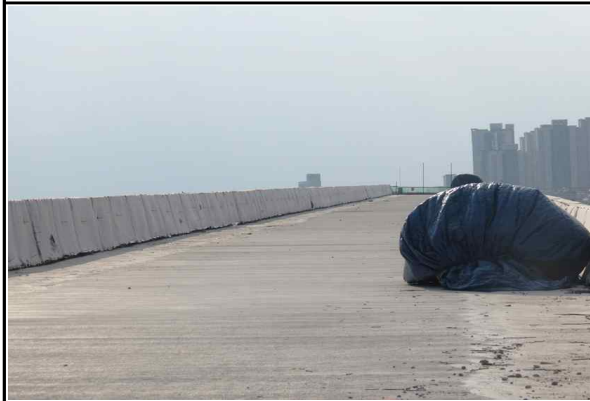
상부슬래브 S1~S6 콘크리트 타설 완료 (2015.11.03)
