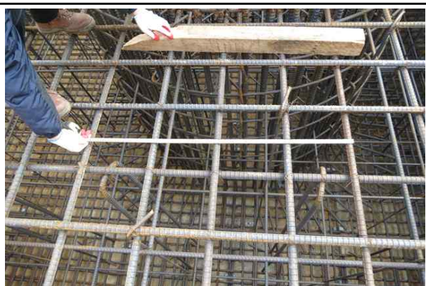
교각 P1 기초 철근배근간격 확인 (2017.01.03)
