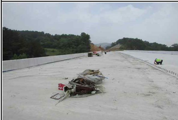
상부슬래브(옥산방향) 시공 전경 (2016.06.13)
