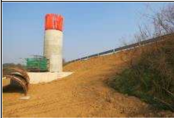
교각 P9 시공현황(15.11.03)
