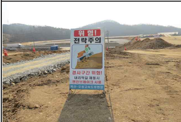
현장내 안전간판 설치 현황
