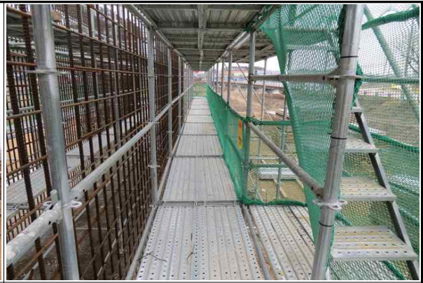
교대 A1 가설비계 설치 현황②
