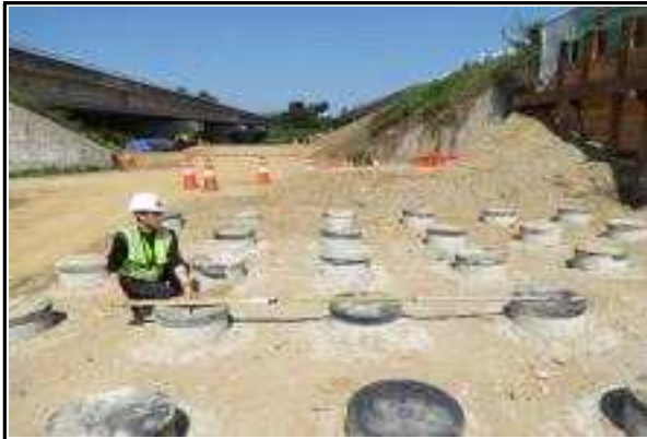
교각 P5 매입PHC말뚝 제원 및 간격 실측
