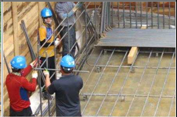
교각 P2(옥산) 기초 철근배근 시공 현황 (2015.09.04)
