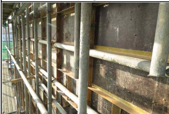
교대 A2 거푸집 설치 및 고정상태 양호①
