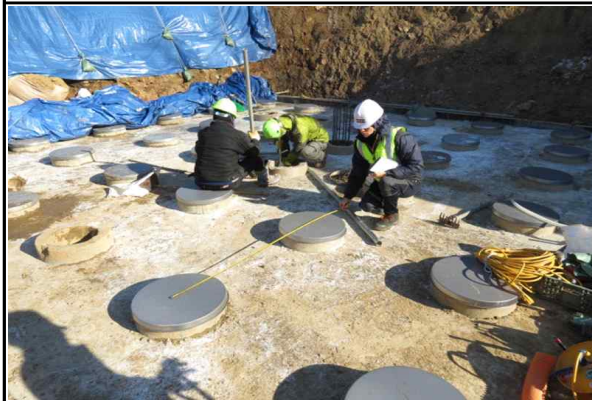
교각 P4(옥산) 매입PHC말뚝 제원 및 간격 실측(2014.12.18)
