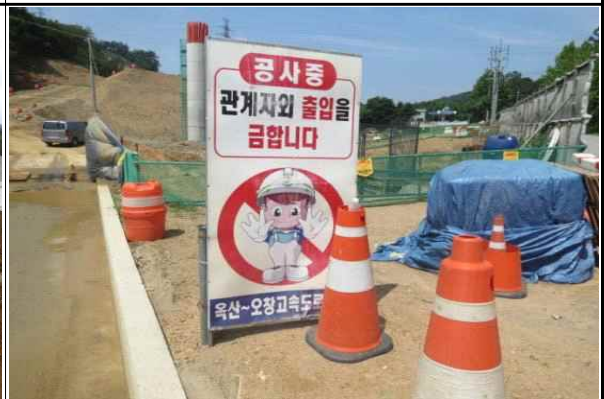
현장 출입구 공사 안내간판 설치상태 양호
