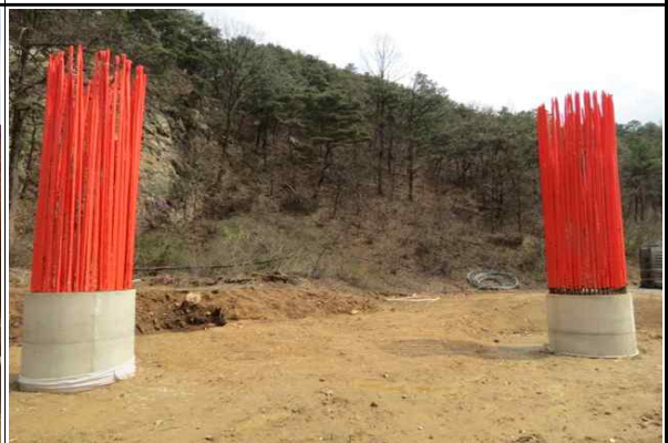
교각 P4(양방향) 시공 현황 (2015.04.07)
