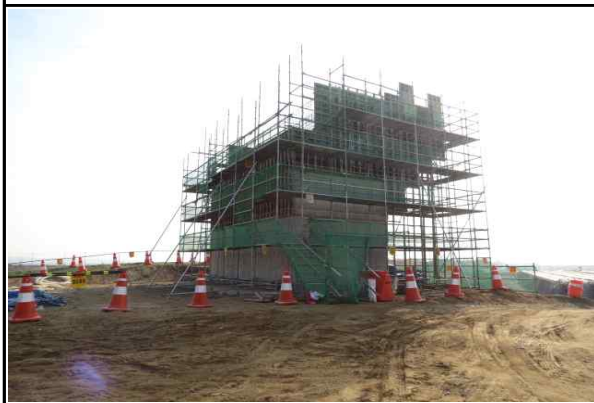
교대 A1 구체 시공 현황(15.02.03)
