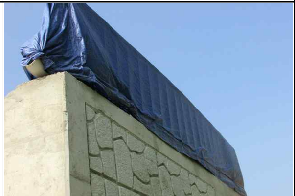
교대 A2 노출철근 보호덮개 설치 현황 (2016.06.13)
