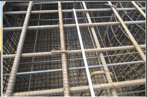
교각 P1 기초 철근배근간격 확인 (2016.12.06)
