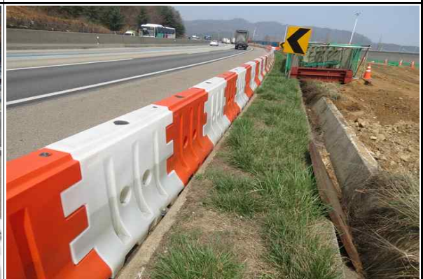
현장인접도로 주변 PE방호벽 설치 현황②
