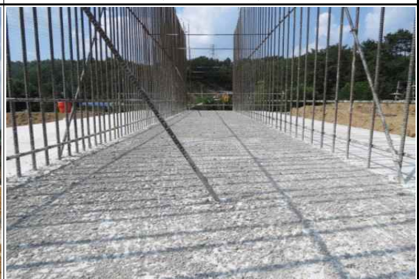
교대 A1 옥산방향 신·구 콘크리트 접합부 치핑상태 양호 (2015.09.04)
