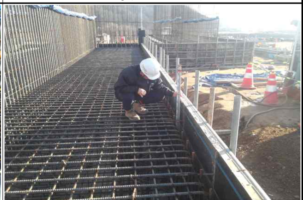
교대 A1(오창) 기초 거푸집 및 피복두께 측정 현황(2015.12.06)
