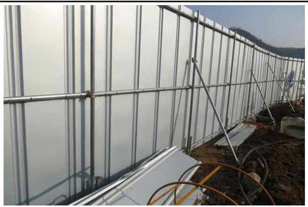
현장 인접도로 주변 안전휀스 설치 현황②
