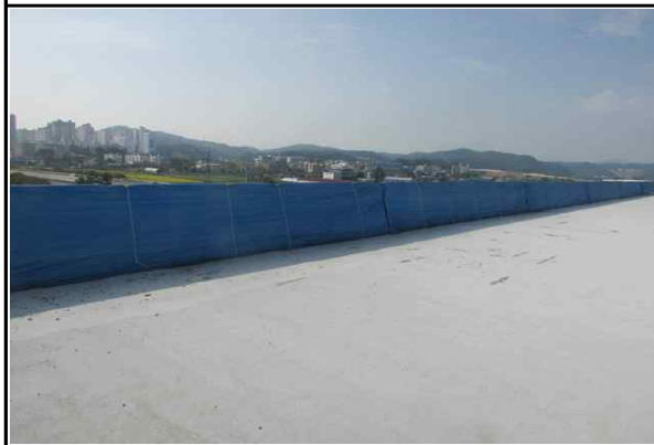
상부 방호벽 노출철근 보호덮개 설치 현황①(2016.10.11)
