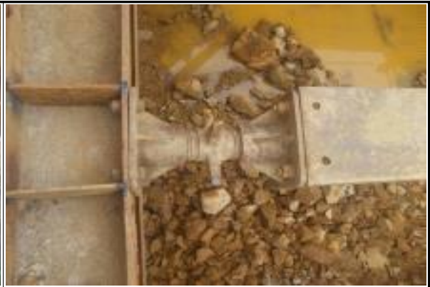
교각 P2(오창) 띠장 + 잭 연결부 설치 상태 양호
