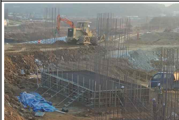
교대 A2 기초 철근배근 및 거푸집 시공 전경 (2016.11.25)
