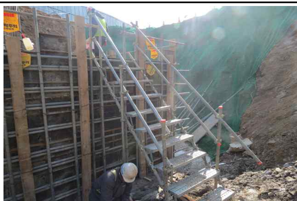
교각 P1 가설계단 설치 상태
