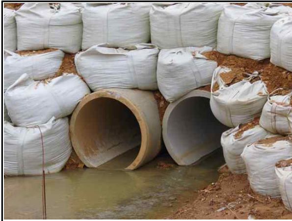
임시배수관 시공 및 배수 상태 양호
