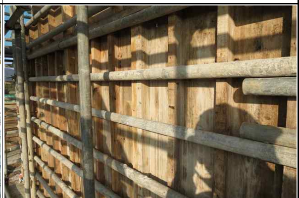
교대 A1 거푸집 설치 상태②
