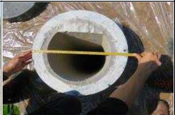
교각 P7 매입PHC말뚝 제원 실측
