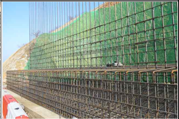
교대 A2 기초 시공 전경① (2017.01.03)
