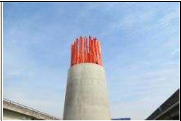
기둥부 노출철근 보호덮개 설치 현황(15.02.03)
