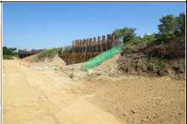
교각 P5 매입PHC말뚝 시공 현황
