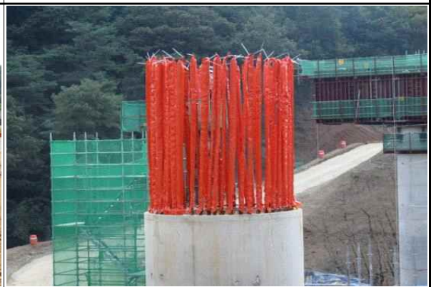
교각 상단 노출철근 보호상태 양호 (2015.09.04)
