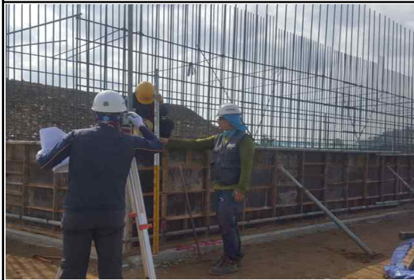
교대 A2 기초 시공 현황① (2016.10.07)
