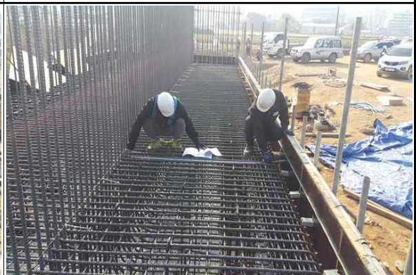
교대 A1 철근배근간격 및 피복두께 실측 현황 (2015.11.04)
