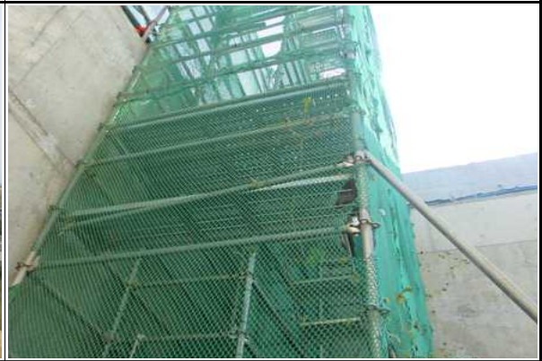
교대 A2 위킹타워 설치상태 양호
