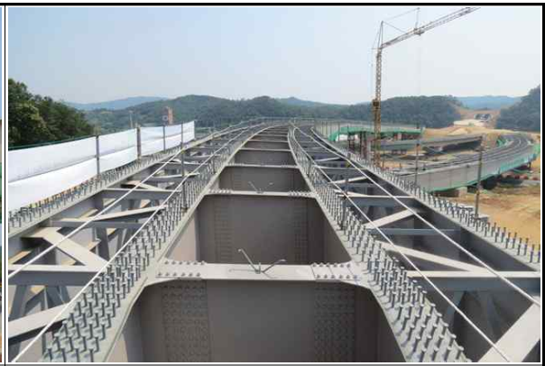
S1~S3 상부 시공 현황 (2017.06.21)
