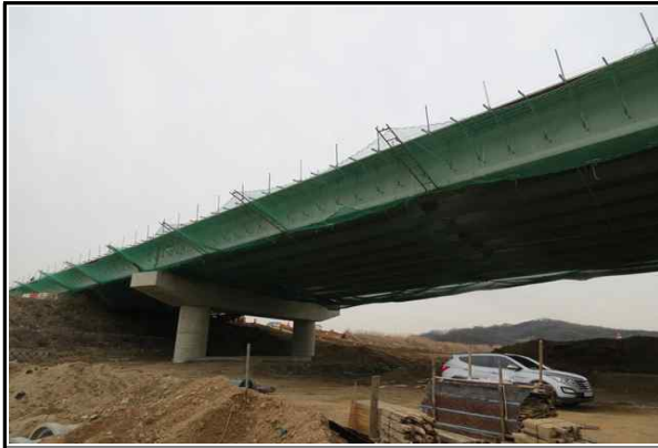
용두천교 상부 시공 현황① (16.03.08)
