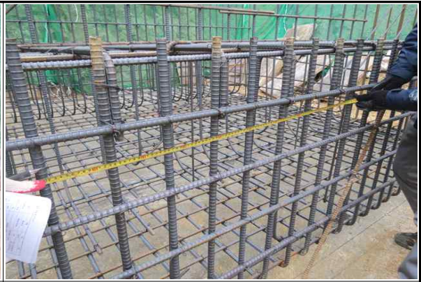
교대 A2(옥산) 기초 철근배근간격 실측 현황(2016.03.08)
