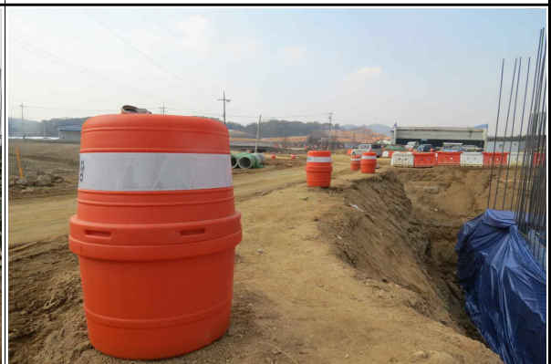
현장내 안전시설 설치 현황②
