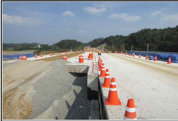
상부 시공 전경 (2016.10.11)
