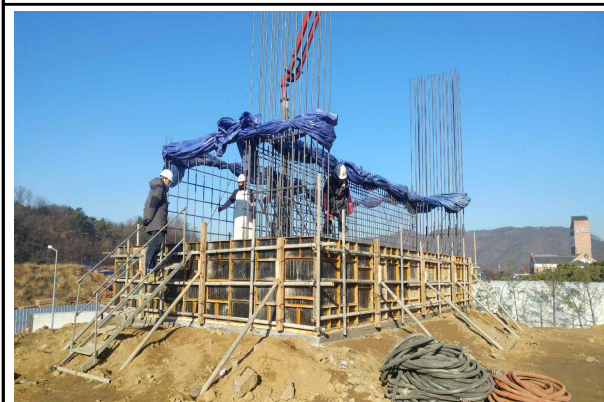
교대 A1 기초 거푸집 및 가설계단 설치 상태
