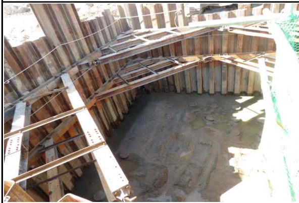
교각 P2(오창) 가시설(쉬트파일) 시공 현황
