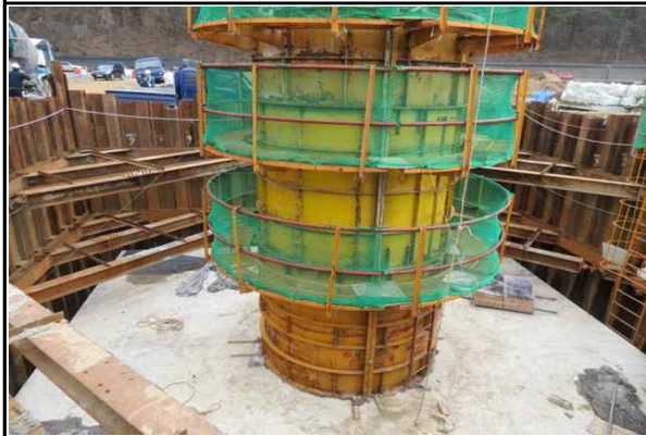
교각 P2(옥산) 시공 현황 (2015.04.07)
