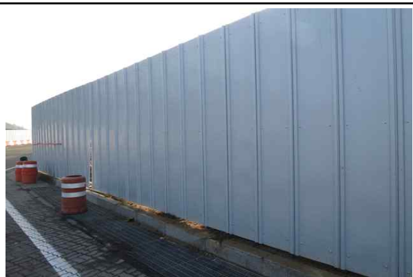
현장 인접도로 주변 안전휀스 설치 현황②
