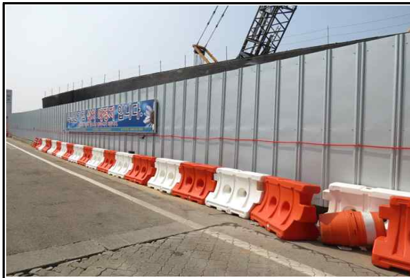
현장 인접도로 주변 안전휀스 설치 현황①
