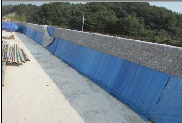
상부 방호벽 노출철근 보호덮개 설치 현황 (2016.10.11)
