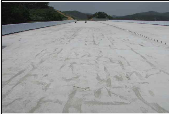
상부슬래브 옥산방향 시공 현황 (2016.06.13)
