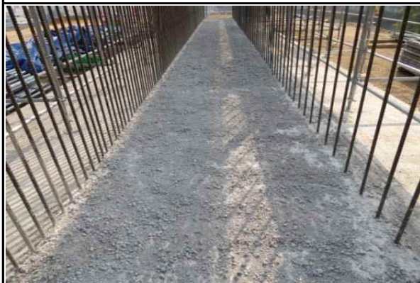
교대 A2 신·구 콘크리트 접합부 치핑상태 양호(2015.11)
