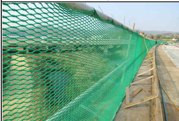
상부 안전난간 설치 현황①
