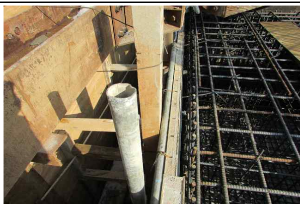
교각 P2 기초 거푸집 설치 상태②
