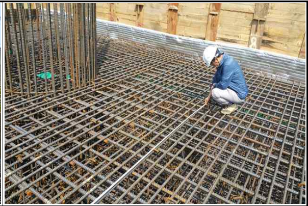
교각 P1 기초 철근배근 실측 현황 (2016.05.16)
