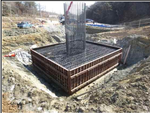
교각 P1 기초(옥산) 거푸집 시공 현황
