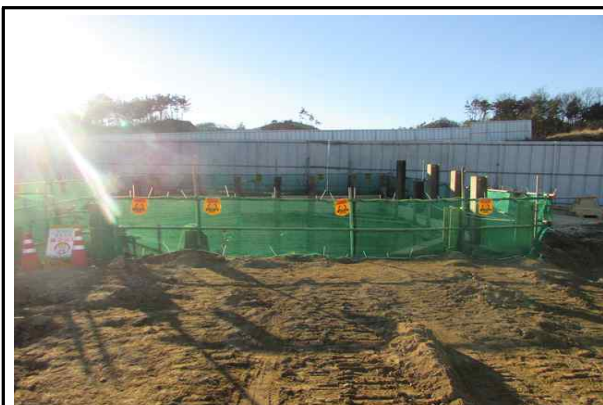
교각 P2 가시설 주변 추락방지를 위한 안전휀스 설치 현황①
