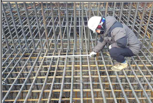
교대 A2(오창) 기초 철근배근간격 실측 현황(2016.02.03)
