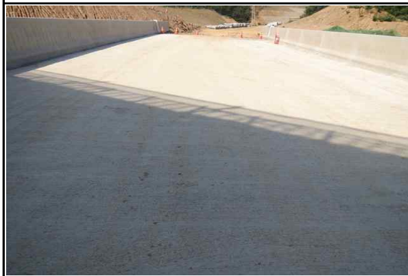
상부슬래브 시공 현황① (2017.09.26)
