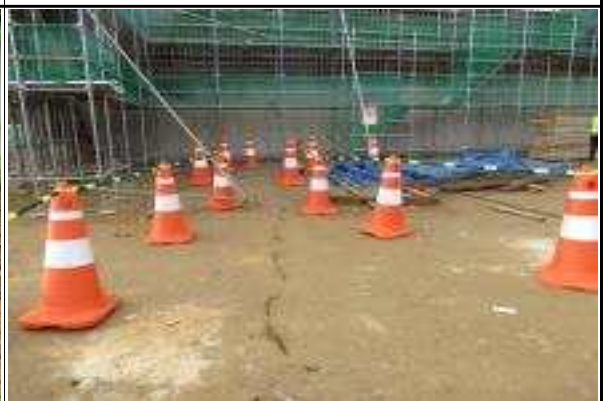
현장내 안전시설 설치 현황
