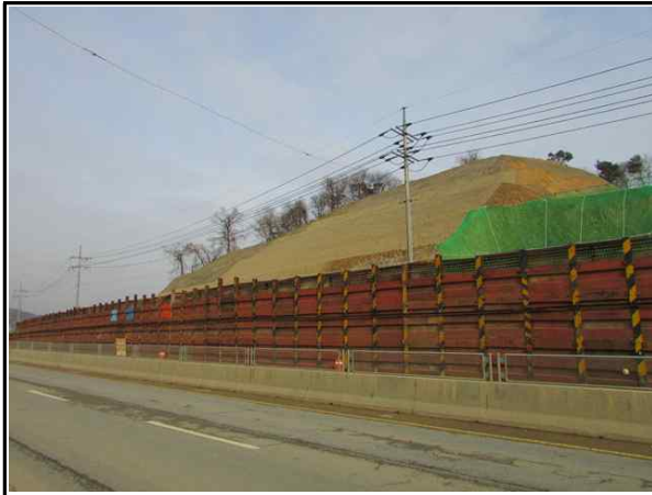
현장 인접도로 주변 흙막이 가시설 시공 현황①
