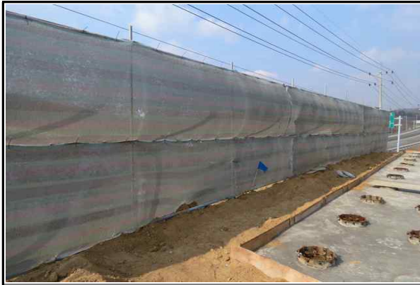
현장내 인접도로 헨스 설치 현황
