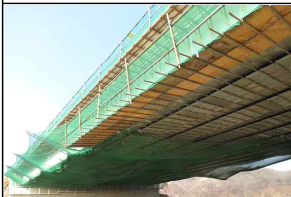
상부 낙하물방지망 설치 현황①
