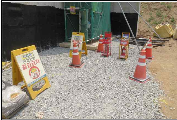
현장내 안전시설 설치 현황①
