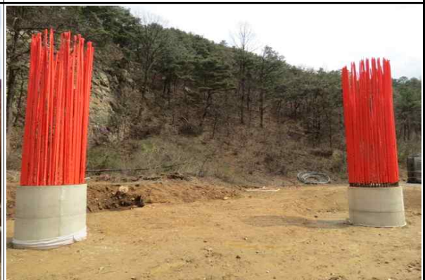
교각 P4(양방향) 시공 현황 (2015.04.07)
