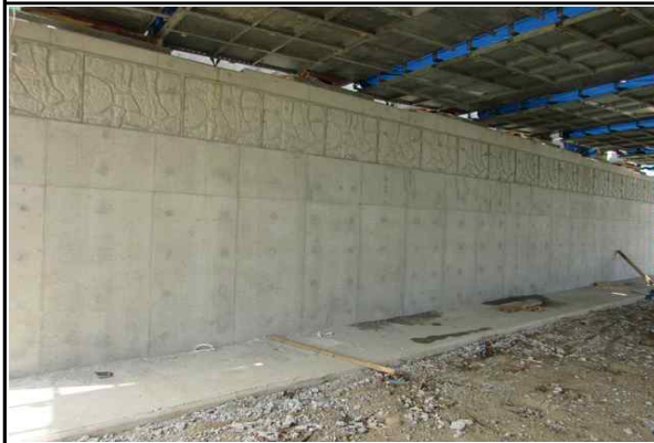
교대 A1 시공 전경① (2016.06.13)
