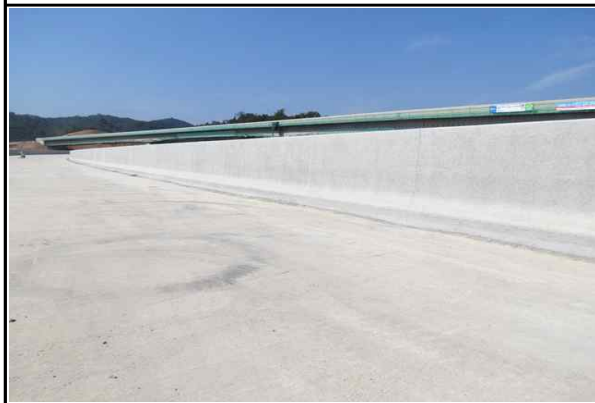
방호벽 시공 현황① (2017.09.26)
