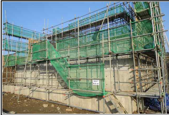
교대 A1 시공 전경 (2017.01.03)
