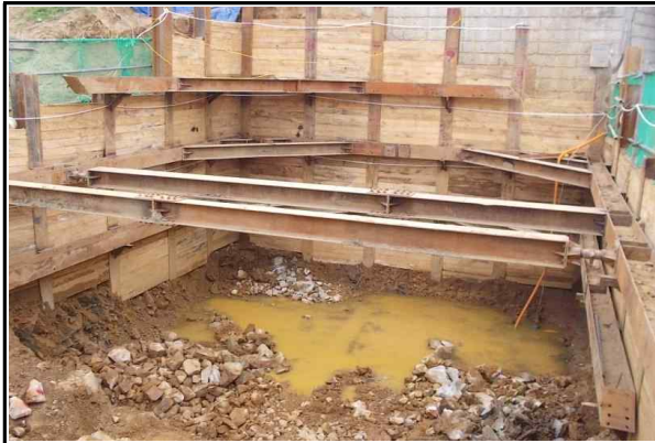
교각 P2(오창) 흙막이 가시설 시공 현황 (2015.05.15)
