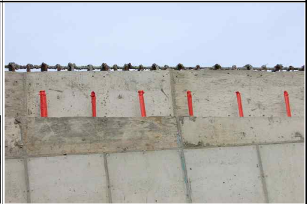
교대 A2 노출철근 보호덮개 설치 현황② (2016.12.13)
