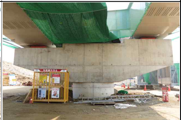
교각 P1 시공 전경 (2017.04.07)
