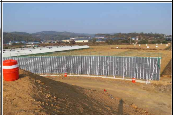
인접 농가시설 주변 안전휀스 설치 현황②
