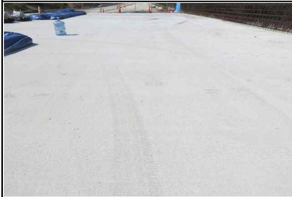
상부슬래브 시공 현황① (2017.09.26)
