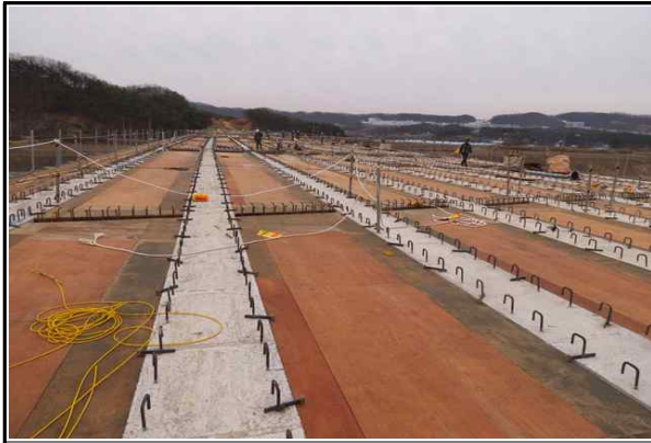
바닥판 거푸집 시공 전경
