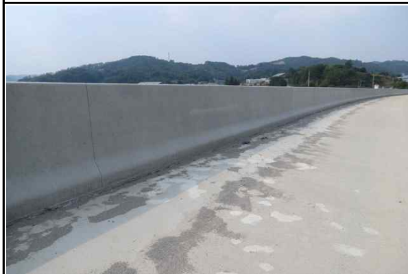
방호벽 시공 전경① (2017.06.21)
