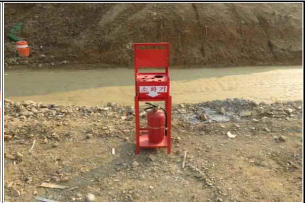
현장내 소화기 배치 현황
