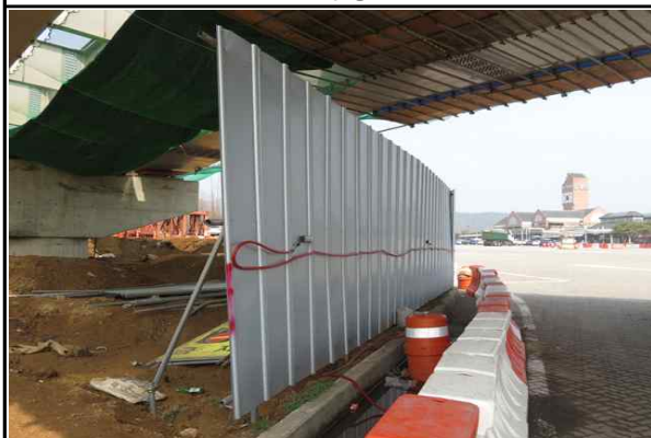
현장 인접도로 주변 안전휀스 설치 현황①
