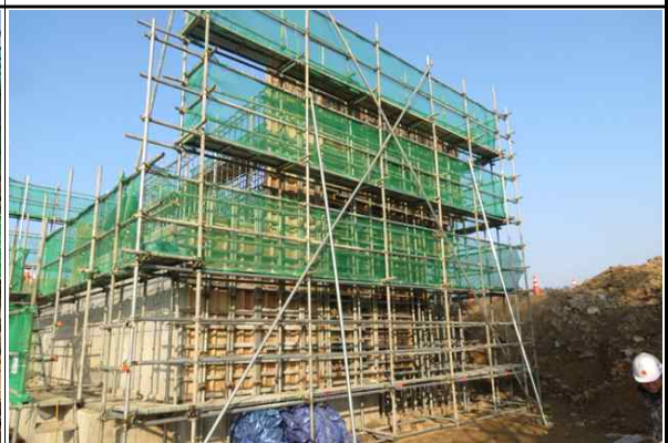
교대 A1 가설비계 설치 현황②
