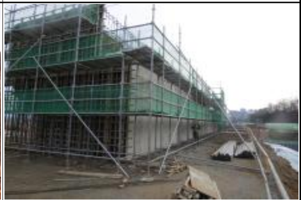
교대 A2 시공 현황 (2015.12)
