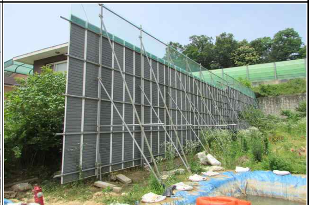
인접 민가 주변 안전펜스 설치 현황
