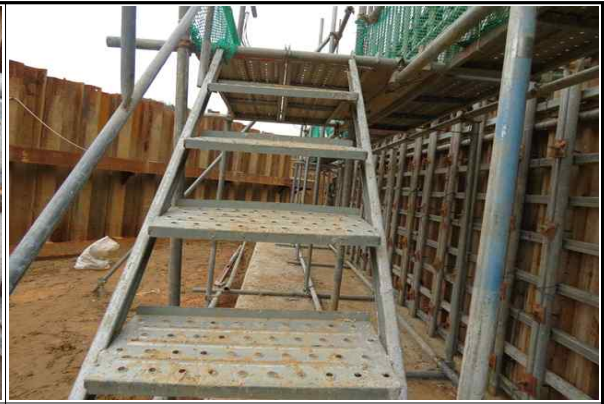
교대 A2 가설계단 설치 상태 양호
