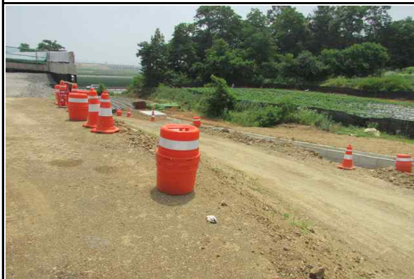
현장내 안전시설 설치 현황
