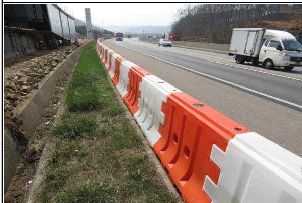
현장인접도로 주변 PE방호벽 설치 현황①
