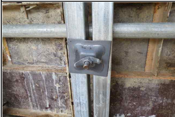
교대 A2 거푸집 설치 및 고정 상태 양호①
