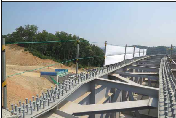
상부공 작업을 위한 추락방지 안전시설 설치 현황①
