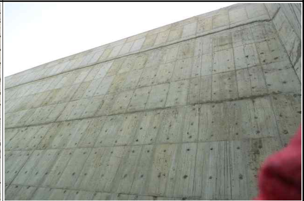
교대 A2 배면부 시공 전경 (2017.04.07)
