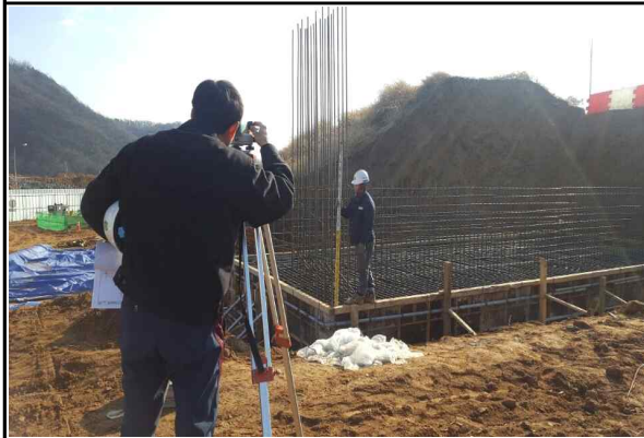
교대 A2 기초 철근배근 및 거푸집 시공 전경 (2016.12.08)
