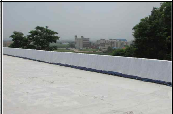
상부 방호벽 노출철근 보호덮개 설치 현황 (2016.06.13)
