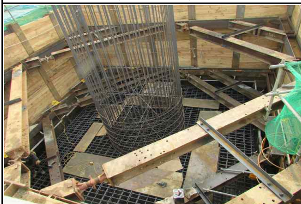
교각 P2 기초 철근배근 시공 전경 (2017.01.12)
