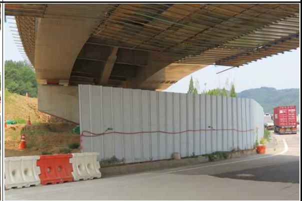
현장 인접도로 주변 안전휀스 설치 현황②
