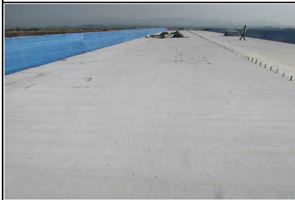
상부슬래브(옥산방향) 시공 현황 (2016.10.11)
