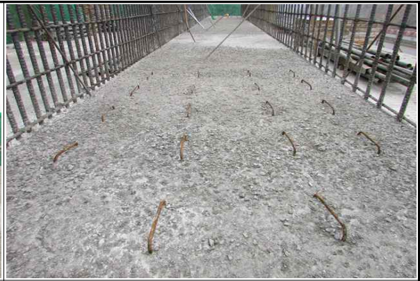
교대 A2 신·구 콘크리트 접합부 치핑상태 양호 (2017.01.12)
