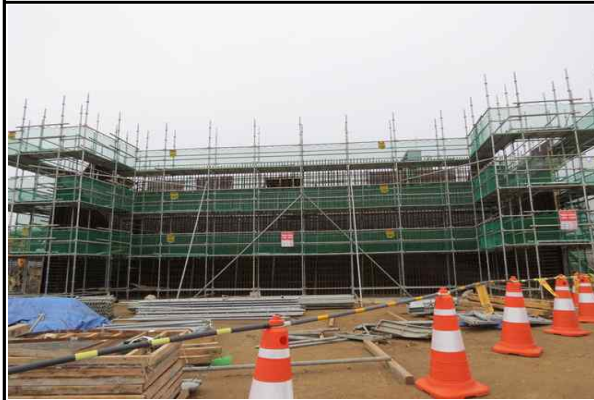
교대 A2 가설비계 설치 현황
