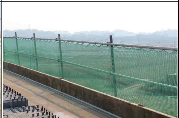
상부 안전난간 설치 현황②
