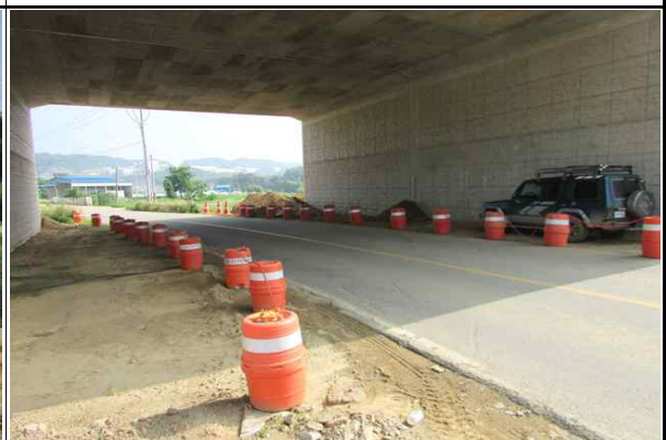
현장 인접도로 안전시설 설치 현황
