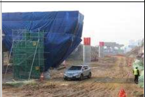
교각 P2~P8 시공현황(15.02.03)
