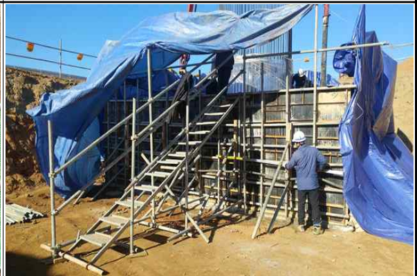
교각 P1 가설계단 설치 상태
