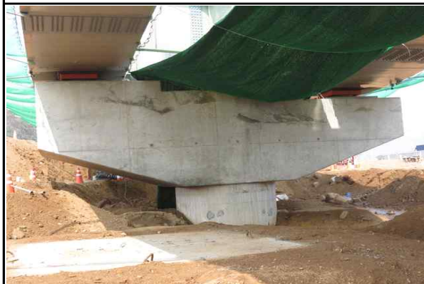
교각 P2 시공 전경 (2017.04.07)
