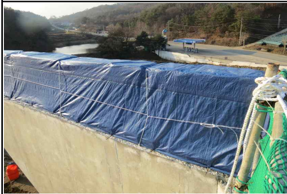
노출철근 보호덮개 설치상태 양호① (2015.12.11)
