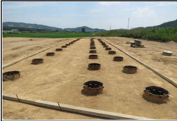
교대 A2 매입복합말뚝 시공 현황
