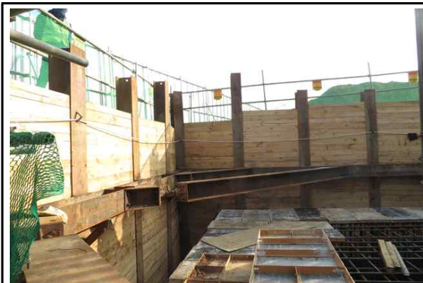
교각 P1 흙막이 가시설 시공 현황
