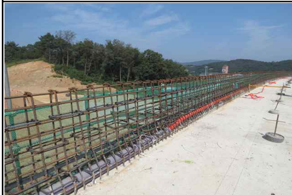
상부 방호벽 철근배근 현황 (2017.09.26)
