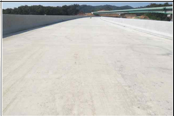
상부슬래브 시공 현황② (2017.09.26)
