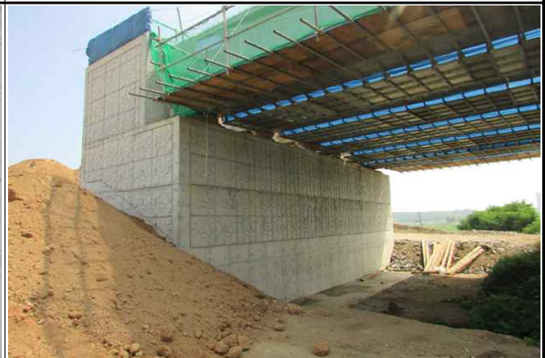
교대 A2 시공 전경① (2016.06.13)
