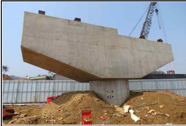
교각 P2 시공 전경 (2017.04.07)
