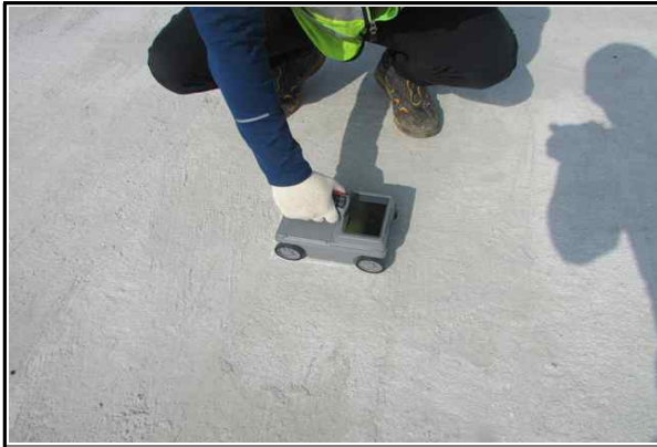
철근배근탐사 시험 현황①
