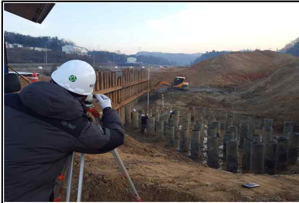
교대 A2 기초 강관말뚝 검측 현황 (2016.01.12)
