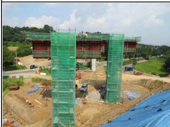
교각 워킹타워 설치 현황
