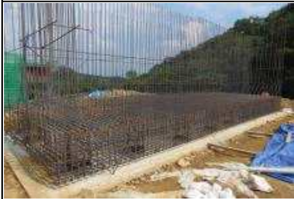
교대 A1 기초(오창) 시공 현황 (2015.09.04)
