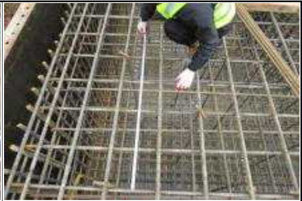
교각 P3 기초(옥산) 철근배근간격 확인 전경 (2015.04.07)
