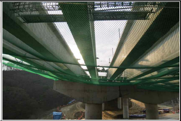
상부 추락망지망 설치 현황②
