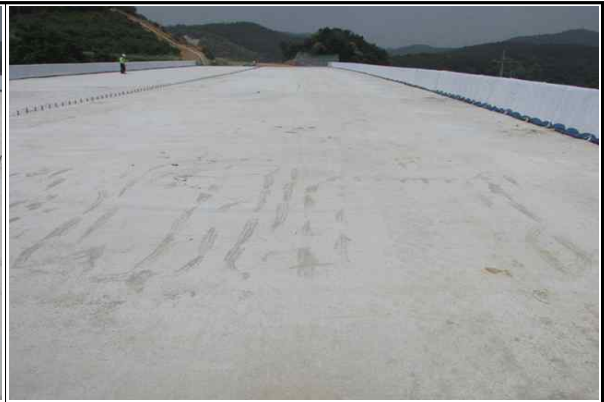
상부슬래브 오창방향 시공 현황 (2016.06.13)
