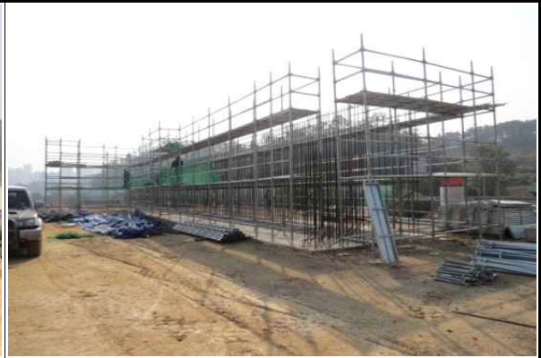
교대 A2 시공 현황 (2015.11)
