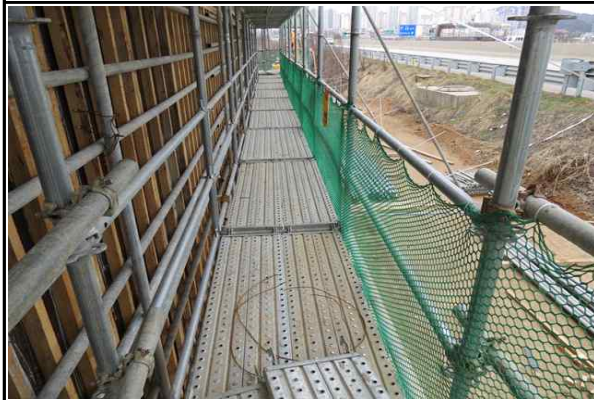
가설통로 설치 및 고정상태 양호
