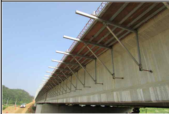
바닥판 캔틸레버부 거푸집 설치 현황
