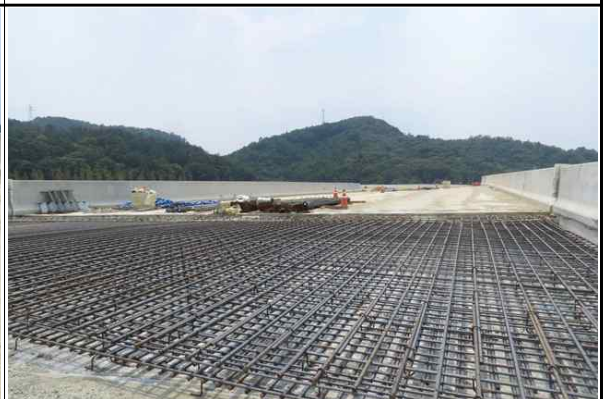
접속슬래브 철근배근 전경 (2017.06.21)
