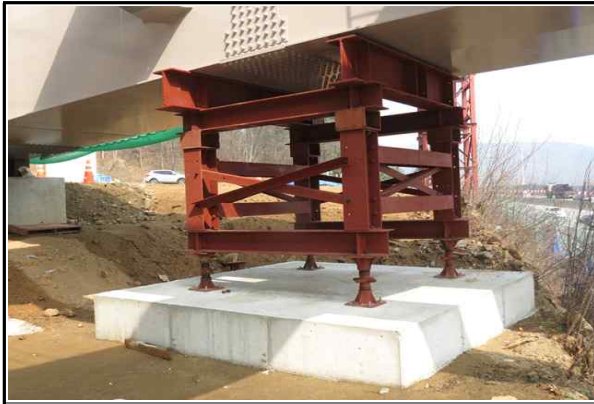
A-1 (G1) 가설벤트 시공 현황
