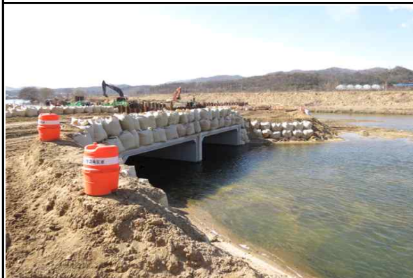
현장내 PC BOX 시공 현황
