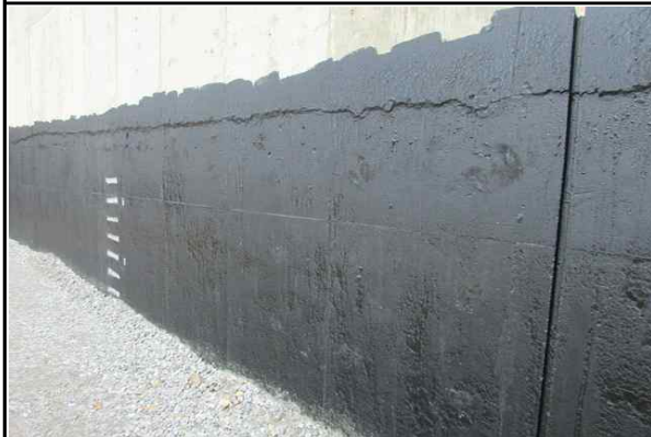
교대 A1 되메우기부 방수페인트 시공 상태 (2016.06.13)
