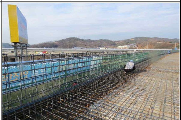
상부 방호벽 철근배근 현황 (2015.12.11)
