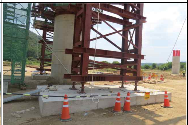
가설벤트 기초부 시공 상태
