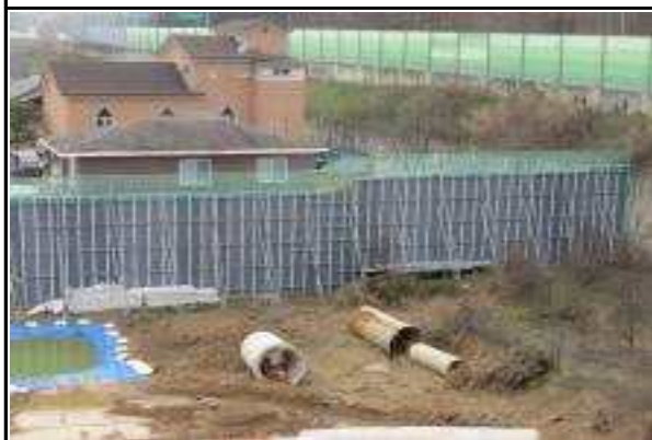
공사장 주변 안전펜스 설치 현황
