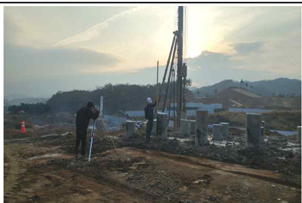
교대 A1 내부굴착강관말뚝 검측 현황② (2016.11.14)
