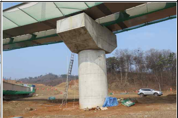
교각 P2 시공 전경 (2017.01.03)
