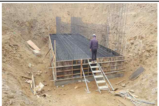
교대 A1 기초 철근배근 및 거푸집 시공 전경②(2016.10.20)
