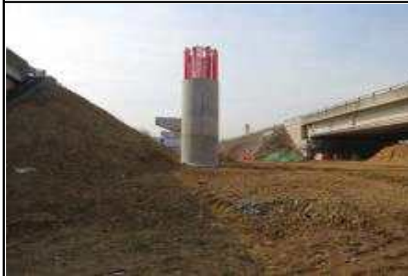
교각 P4 시공현황(15.02.03)
