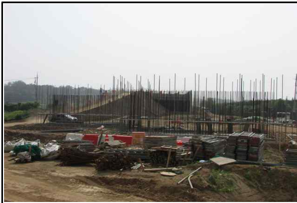
교대 A1(양방향) 시공 전경 (2016.06.13)
