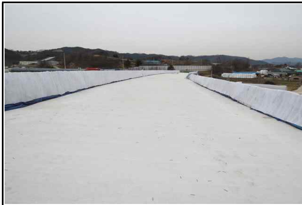
상부슬래브 시공 현황① (2016.03.08)
