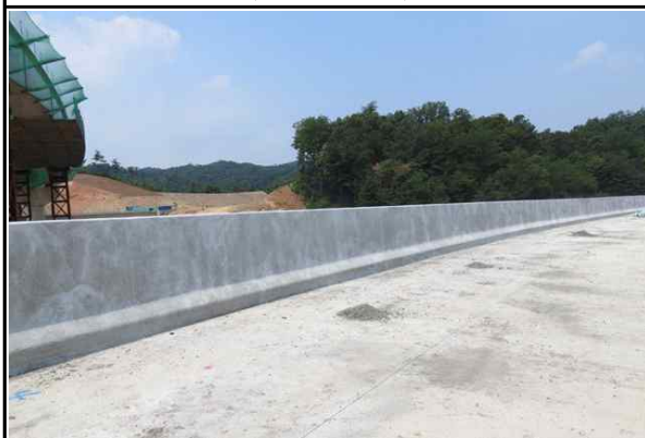
상부 방호벽 일부 콘크리트 타설 완료 (2017.06.21)
