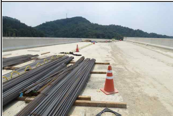
상부슬래브 시공 전경 (2017.06.21)
