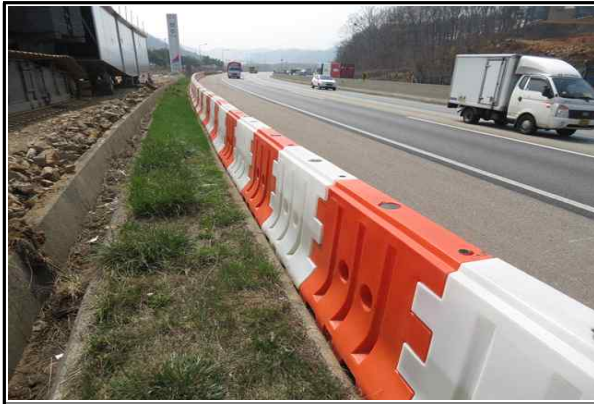
현장인접도로 주변 PE방호벽 설치 현황①
