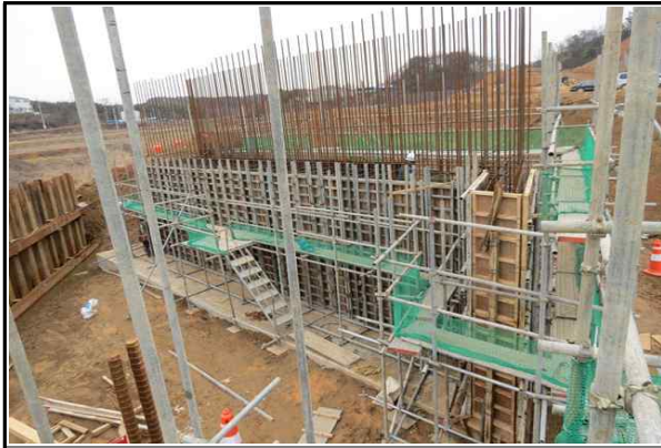
교대 A2(옥산방향) 시공 전경 (2016.03.08)
