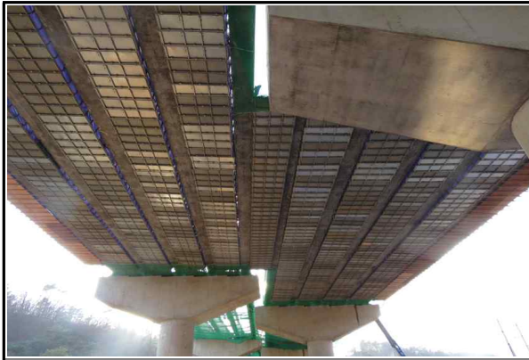
상부 추락망지망 설치 현황①
