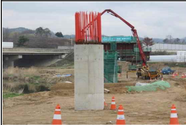
교각 P1 시공 현황(15.04.07)
