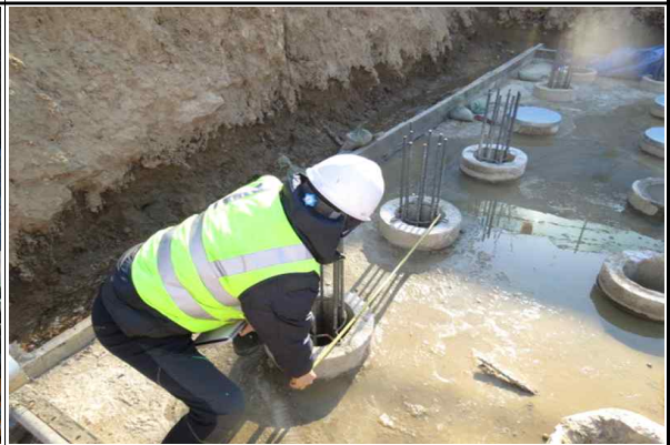
교각 P4(오창) 매입PHC말뚝 제원 및 간격 실측(2014.12.18)
