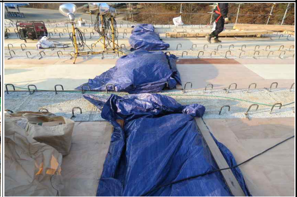
가보로 타설 및 보양상태 양호 (2015.12.11)
