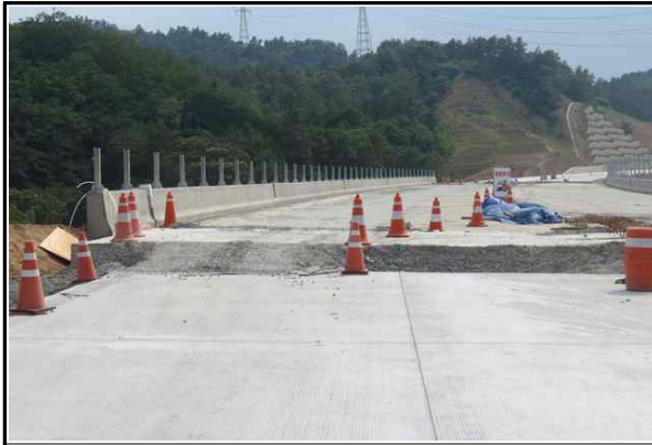
현장내 안전시설 설치 현황③
