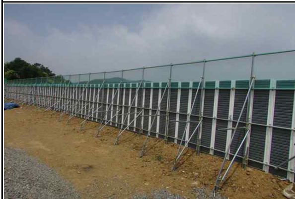
공사장 주변 안전펜스 설치 현황
