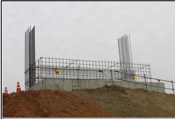
교대 A1 시공 전경 (2016.12.13)
