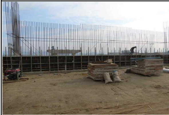
교대 A1 시공 전경 (2015.12.11)
