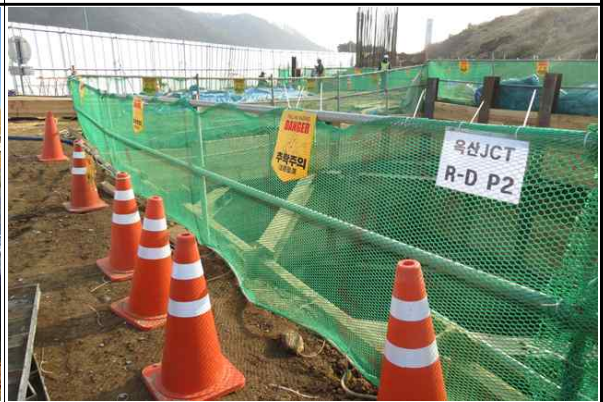
교각 P2 기초 작업장 주변 추락방지를 위한 안전휀스 및 라바콘 설치 현황
