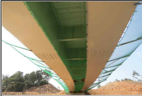
상부 낙하물 방지망 설치상태 양호
