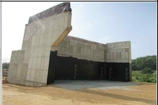
교대 A2(오창방향) 시공 전경② (2016.06.13)
