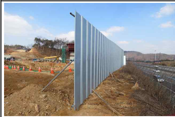
현장 인접도로 주변 안전휀스 설치 현황①
