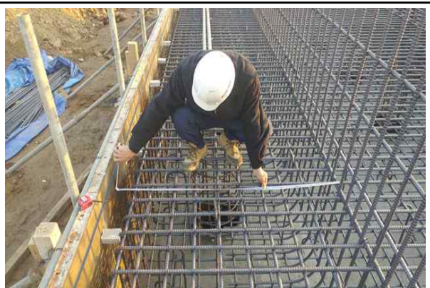
교대 A2 기초 철근배근간격 및 피복두께 확인(2016.11.25)
