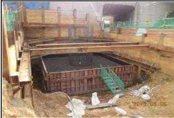
교각 P2(오창) 기초 거푸집 시공 현황
