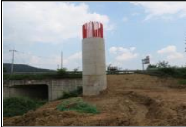
교각 P1(옥산) 시공 현황 (2015.09)
