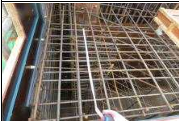
교대 A2 구체부 철근배근상태 양호(15.12.11)
