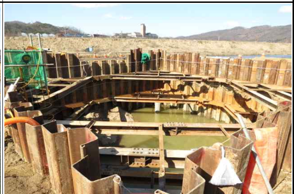
교각 P2(옥산) 가시설(쉬트파일) 시공 현황
