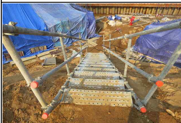
교대 A1 가설계단 설치 상태 양호
