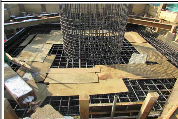
교각 P2 기초 철근배근 및 거푸집 시공 전경 (2017.01.23)
