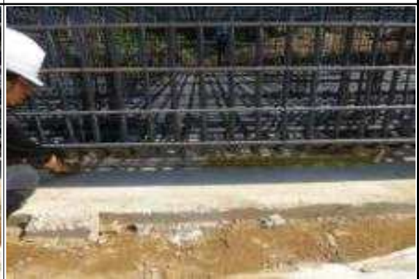
교각 P1 기초 철근배근 상태 확인②
