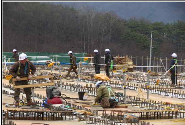
상부 바닥판 거푸집 설치작업 현황 (16.03.08)
