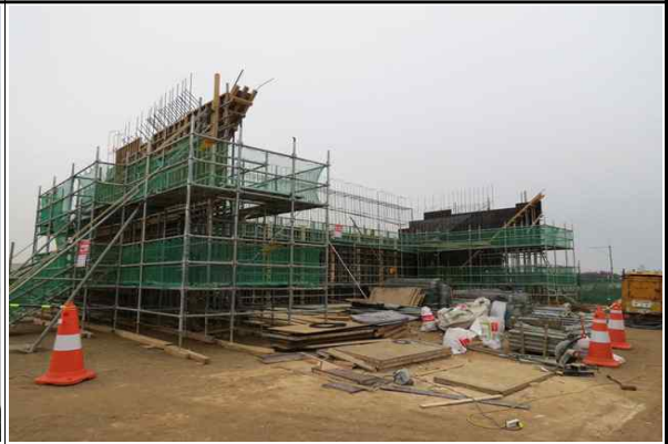
교대 A1 가설비계 설치 현황
