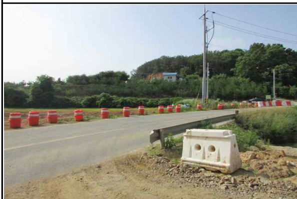
현장 인접도로 안전시설 설치 현황
