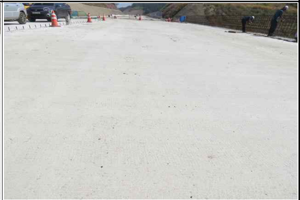
상부슬래브 시공 현황② (2017.09.26)
