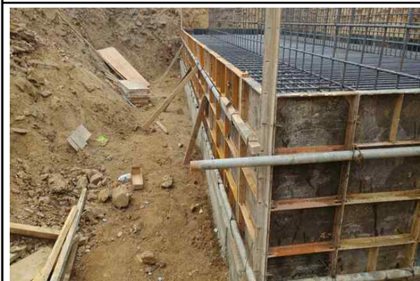
교대 A1 기초 거푸집 설치 상태
