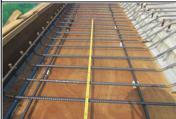
상부슬래브 철근배근간격 확인 (2016.06.13)
