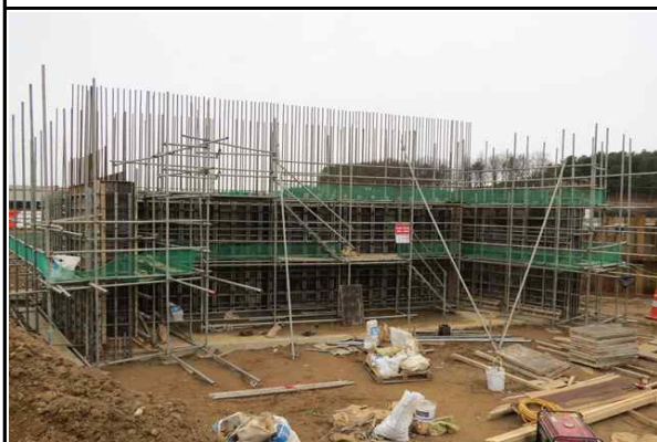
교대 A2 가설비계 설치 현황
