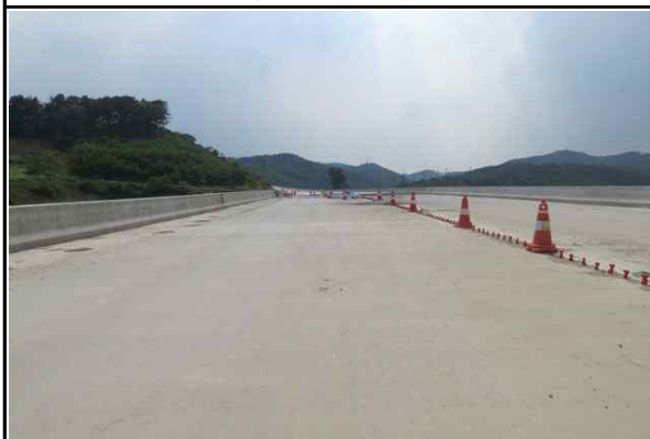
오창방향 상부슬래브 및 방호벽 시공 전경 (2017.06.21)
