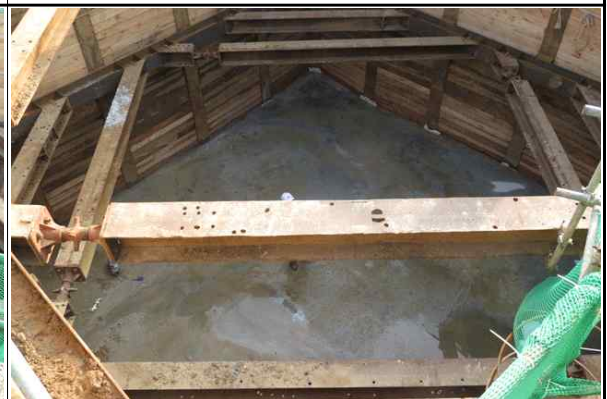
교각 P2 기초 버림 타설 현황 (2017.01.03)
