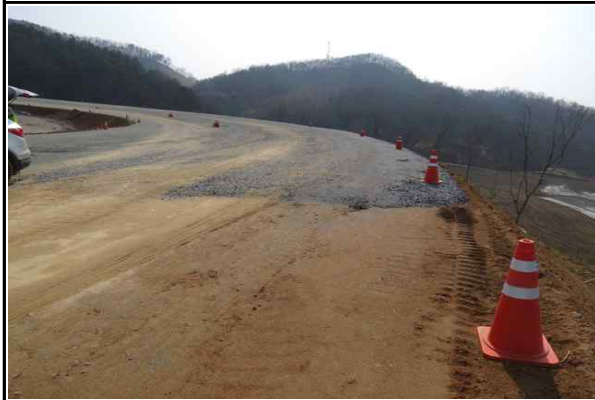
현장내 안전시설 설치 현황①
