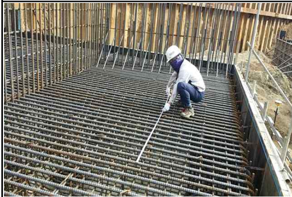
교대 A1(오창) 기초 철근배근간격 실측 현황(2016.04.27)
