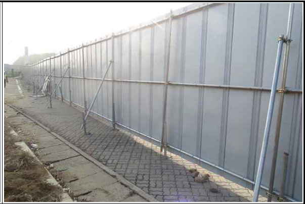
안전휀스 설치 및 고정상태 양호
