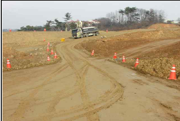
현장내 안전시설(라바콘) 설치 현황
