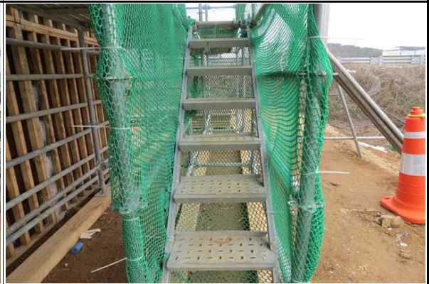
가설계단 설치 및 고정상태 양호
