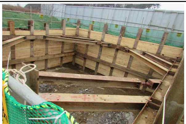
교각 P1 흙막이 가시설 시공 현황②
