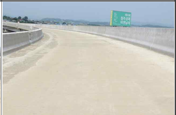
상부슬래브 S1~S10 시공 전경② (2017.06.21)
