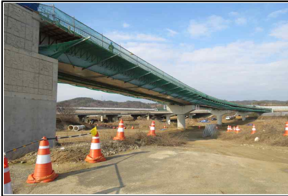
현장내 안전시설 설치 현황①
