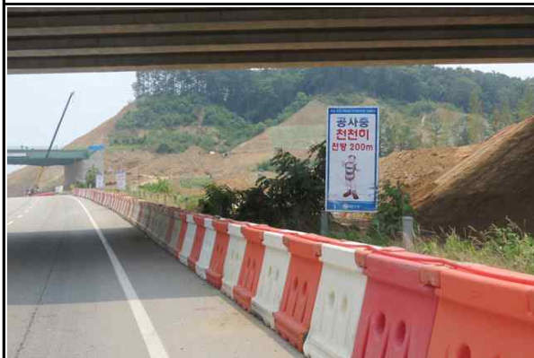
현장 인접도로 안전시설 설치 현황
