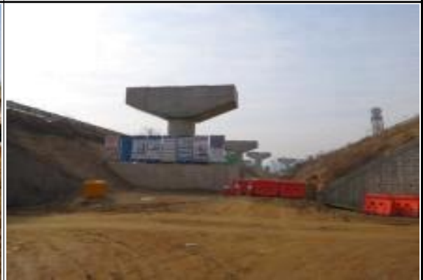
교각 P5 시공현황(15.02.03)
