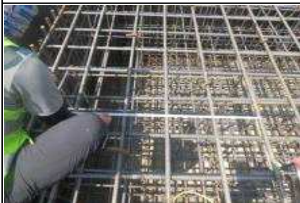
교각 P2 기초 철근배근간격 확인 전경 (2015.06.29)
