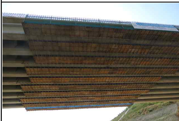
낙하물 방지지설 설치 및 고정상태 양호①
