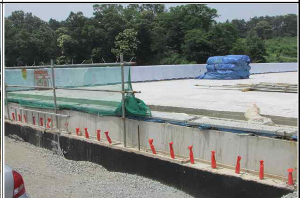
파라펫 노출철근 보호덮개 설치 현황 (16.06.13)
