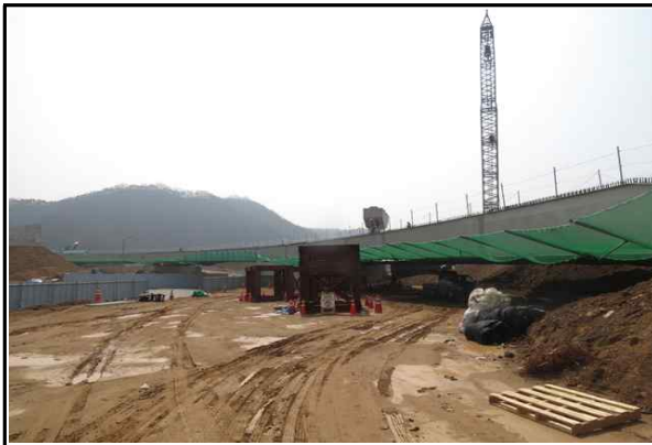
상부 거더(S1~S3) 거치 현황① (2017.04.07)
