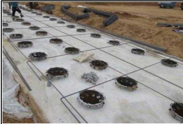
교대 A1 기초(매입강관말뚝) 시공 현황 (2015.09.04)
