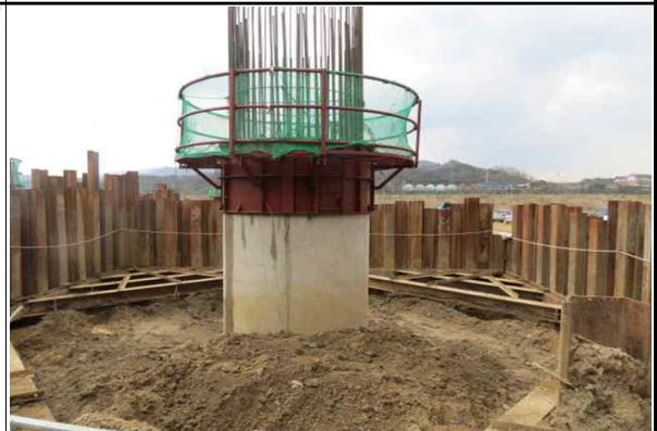
교각 P3(옥산) 시공 현황 (2015.04.07)
