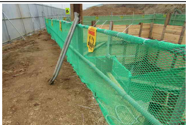
교각 P1 기초 작업장 주변 추락방지를 위한 안전휀스 설치 현황②
