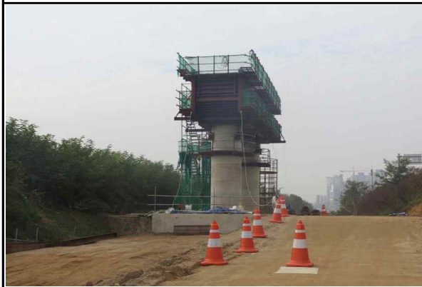
현장내 안전시설 설치 현황①
