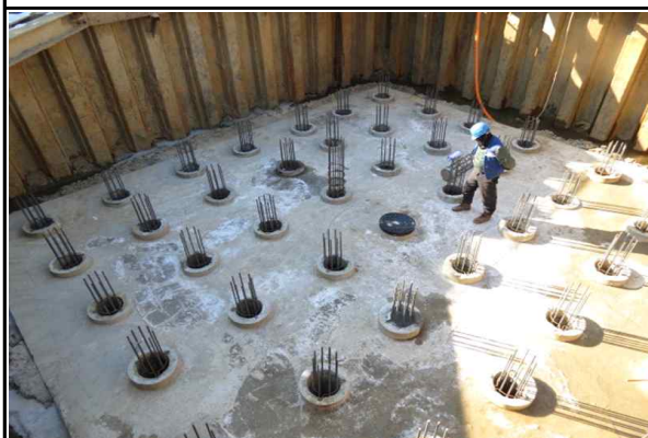
교각 P2(오창방향) 매입PHC말뚝 시공 현황
