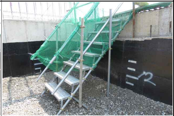
가설계단 설치 및 고정상태 양호
