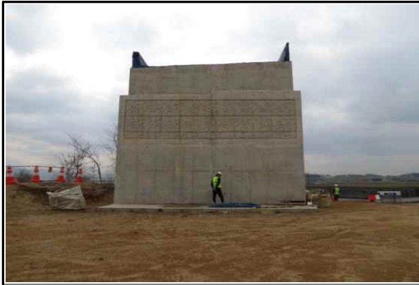
교대 A1 시공 현황(15.04.07)
