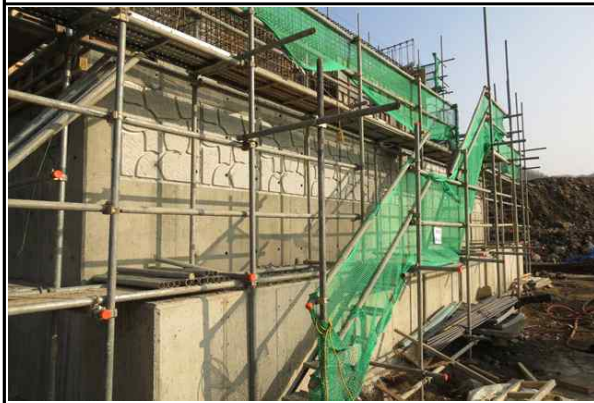
교대 A2 가설비계 설치 현황①
