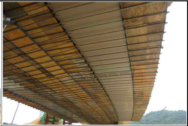
상부 추락방지망 설치 현황④
