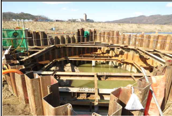
교각 P2(옥산) 기초 가시설 설치 및 시공현황(2015.03.04)
