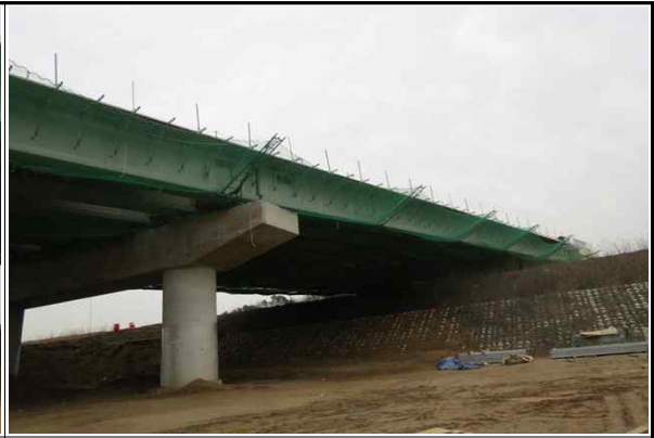
용두천교 상부 시공 현황② (16.03.08)
