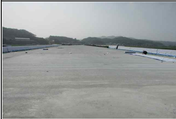
상부슬래브 시공 현황 (16.03.08)
