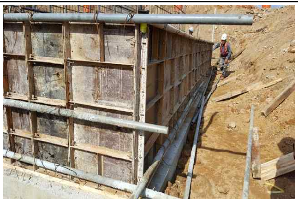
교대 A2 기초 거푸집 설치 현황②
