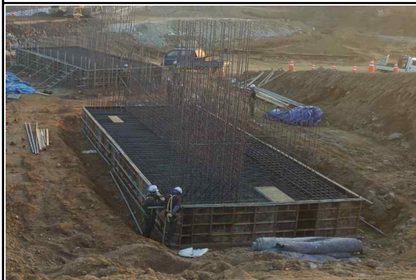
교대 A1 기초 철근배근 및 거푸집 시공 전경(2016.11.25)
