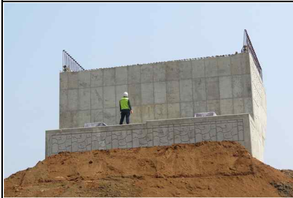
교대 A1 시공 전경① (2017.04.07)
