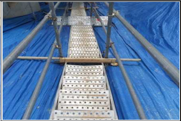
교대 A1 가설계단 설치상태 양호
