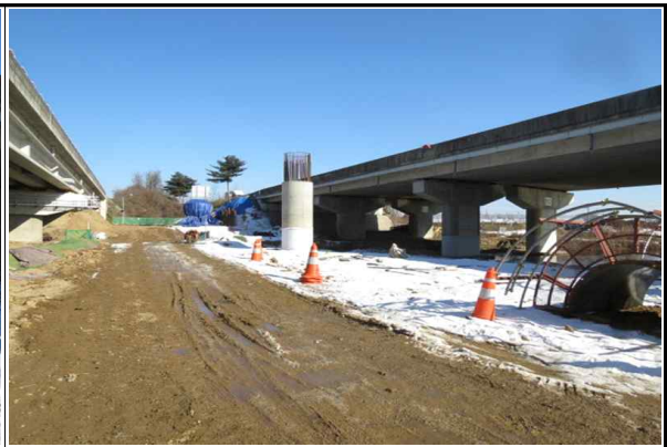
교각 P2 시공현황(14.12.18)
