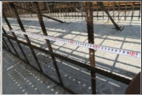
교대 A2 옥산방향 벽체 철근배근상태 양호 (2015.09.04)
