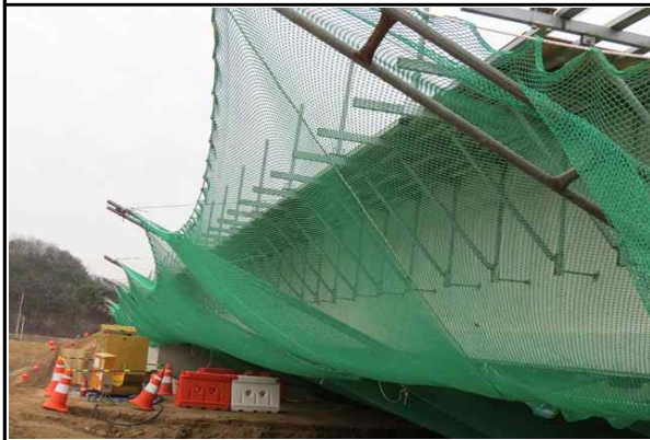
상부 추락방지망 설치 현황①
