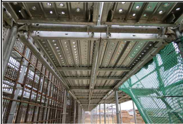
작업발판 설치 및 고정상태 양호
