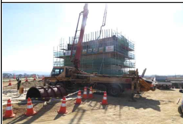
교대 A1 콘크리트 타설 현황(15.02.13)
