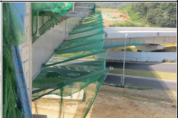
상부 낙하물 방지망 설치 현황②
