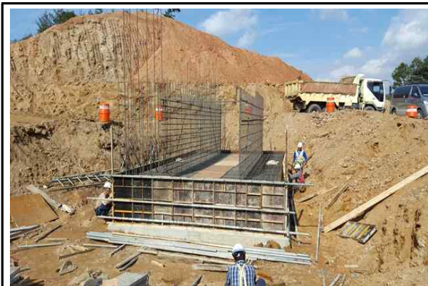
교대 A2 기초 철근배근 및 거푸집 시공 전경①(2016.10.07)
