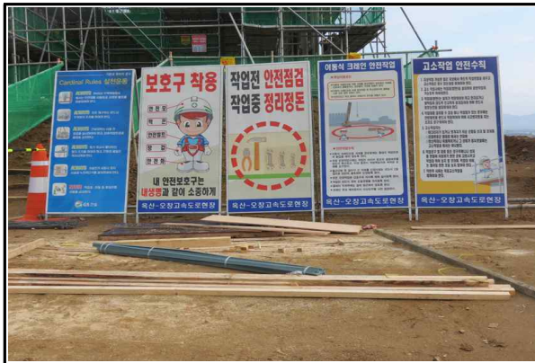
현장내 안전시설 설치 현황②
