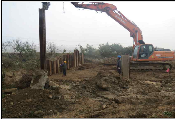
교각 P3 흙막이 가시설 시공 현황
