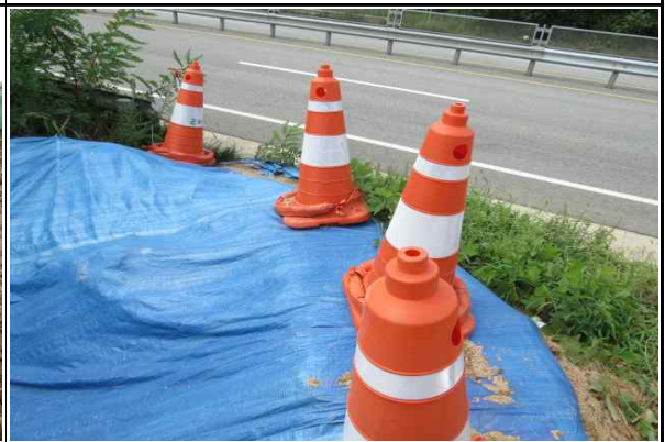
현장내 안전시설 설치 현황①
