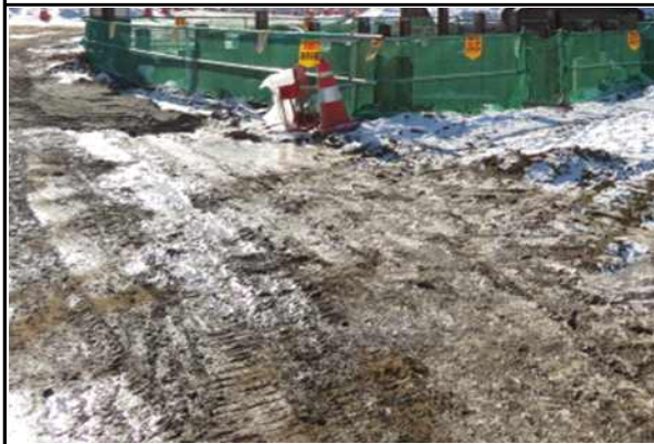
교각 P1 흙막이 가시설 시공 현황
