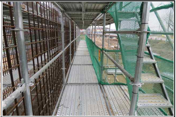
교대 A1 가설비계 설치 현황②
