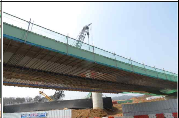
상부 추락방지망 설치 현황②
