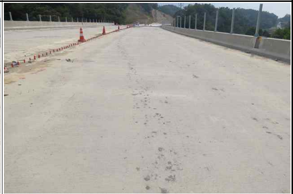
상부슬래브(옥산방향) 시공 전경 (2017.06.21)
