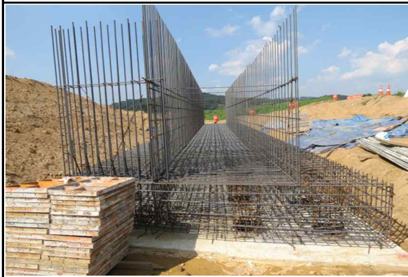
교대 A1 기초철근조립 상태
