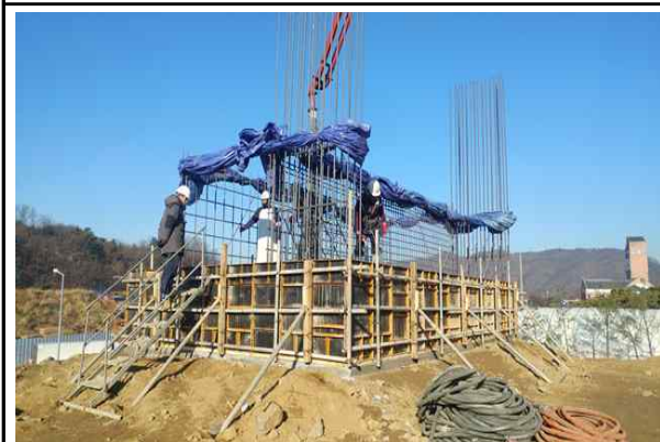
교대 A1 기초 철근배근 및 거푸집 시공 전경 (2016.11.28)
