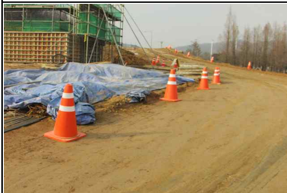
교각 P1 기초 작업장 주변 추락방지를 위한 안전웬스 설치 현황
