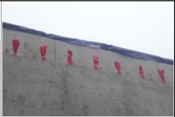
파라펫 노출철근 보호캡 설치 현황(15.05.15)
