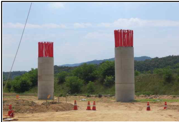
교각 P1(양방향) 시공 현황 (2015.06.29)
