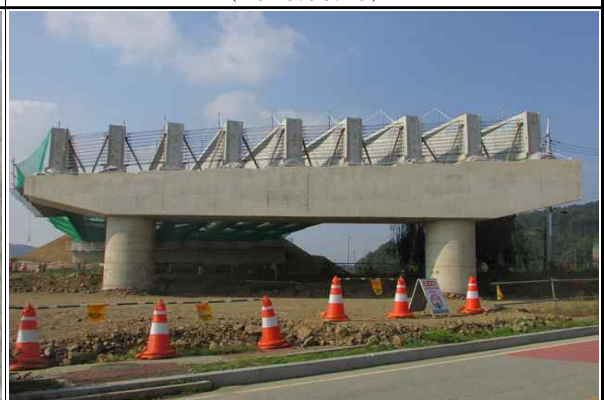
교각 P1 시공 전경 (2016.10.11)
