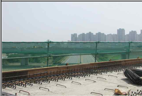
상부 안전난간 설치상태 양호②
