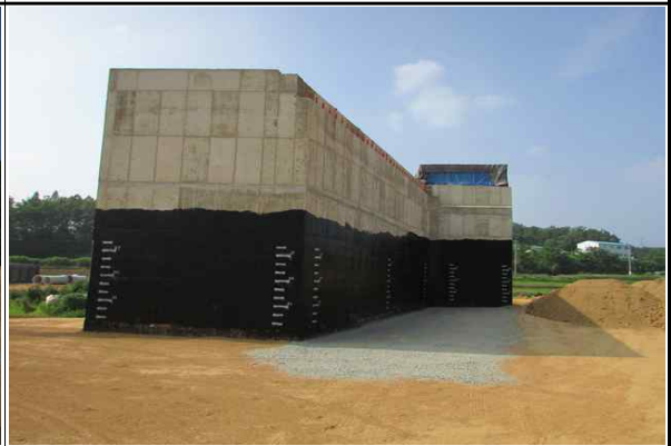
교대 A2(옥산방향) 시공 전경② (2016.06.13)
