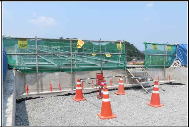
상부 진입부 안전시설 설치 현황
