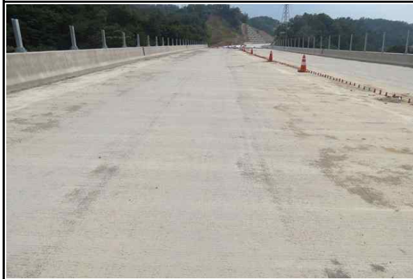
상부슬래브(오창방향) 시공 전경 (2017.06.21)
