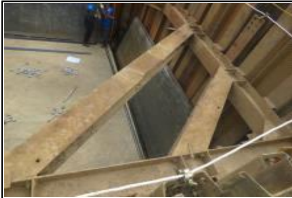
교각 P3 가시설 떠장 사보강재 접합부 상태
