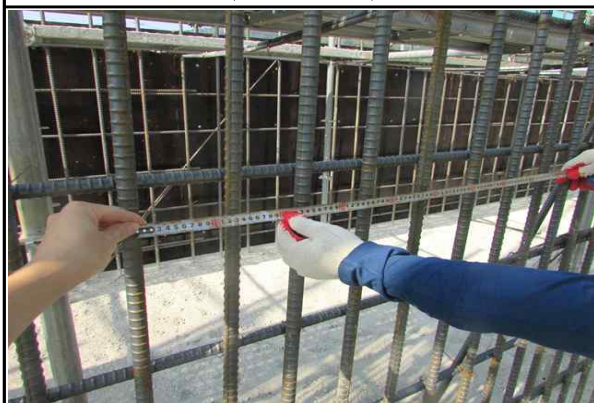
교대 A2 구체 철근 배근간격 확인 (2016.10.11)
