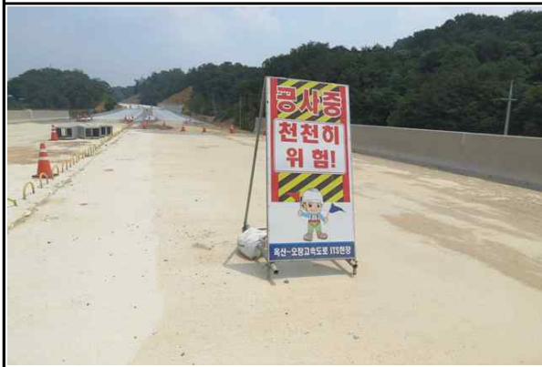
안전간판 설치 현황
