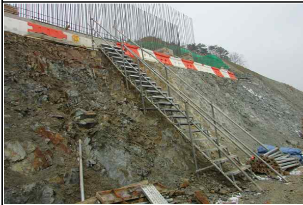
교대 A2 진입을 위한 가설계단 설치 현황
