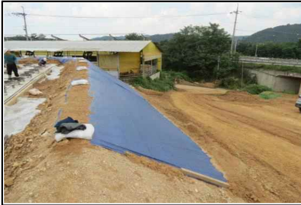
교대 A1 인접법면 보호덮개 설치상태 양호
