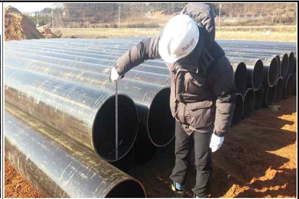
기초 강관파일 제원측정 현황 (2016.01.12)
