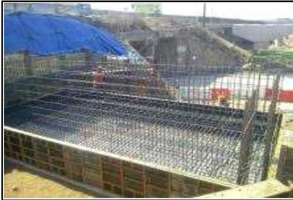
교대 A1 기초 시공현황
