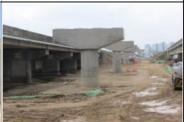
교각 P2~P8 시공현황(15.04.07)
