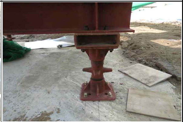
가설벤트 볼트 및 접합부 체결상태 양호②
