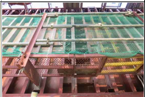
강제거푸집 설치·고정 상태 양호②
