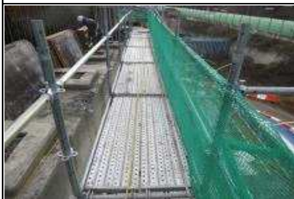
교대 A2 가설통로 설치·고정 상태 양호
