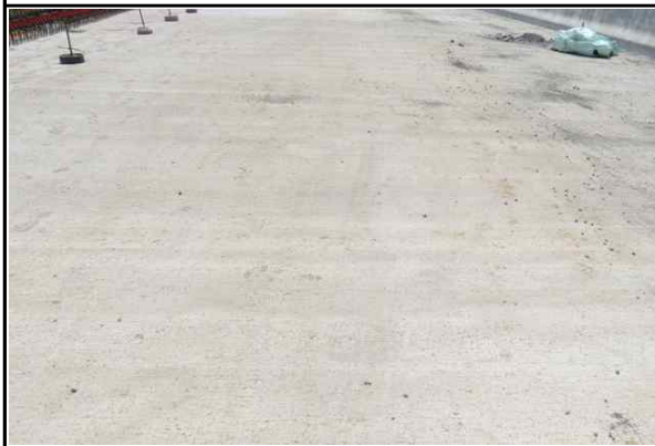
상부슬래브 콘크리트 외관상태 양호 (2017.06.21)
