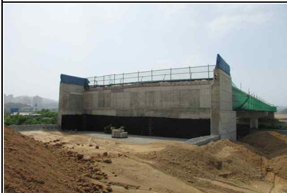
교대 A2 시공 전경② (2016.06.13)
