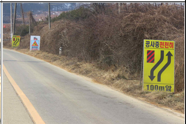
현장 인접도로 공사안내표지판 설치 현황
