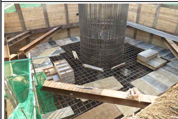
교각 P1 기초 철근배근 시공 전경 (2017.01.03)
