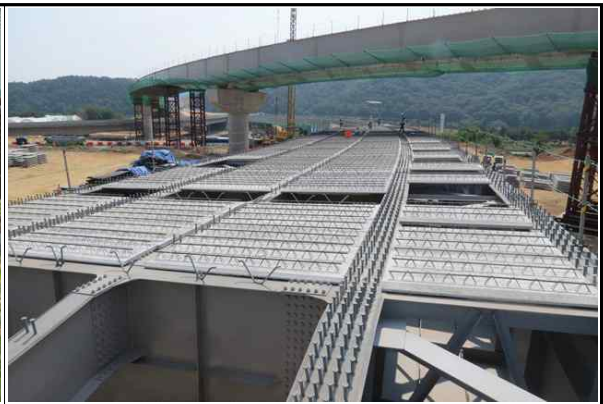
S1~S3 상부 시공 현황 (2017.06.21)
