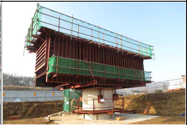
교각 P1 시공 전경 (2017.01.03)
