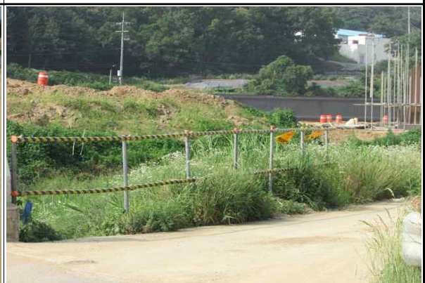
현장 진출입로 안전시설 설치 현황
