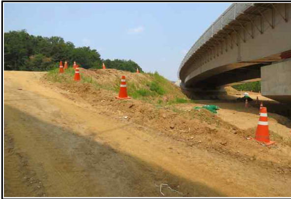
현장내 안전시설 설치 현황(3)
