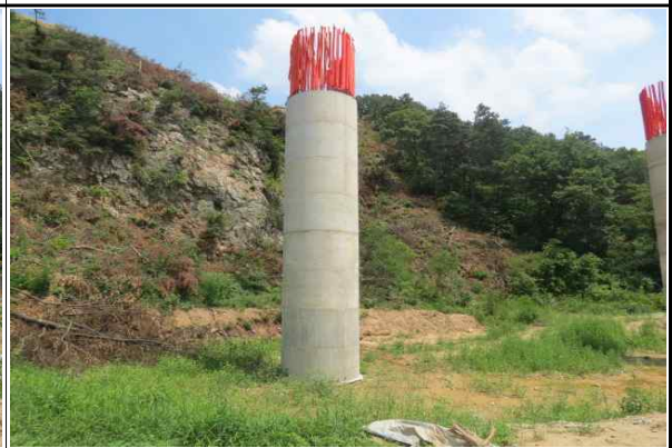
교각 P4(옥산) 시공 현황 (2015.06.29)
