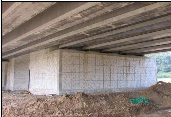
교대 A1(옥산방향) 시공 전경 (2016.04.27)
