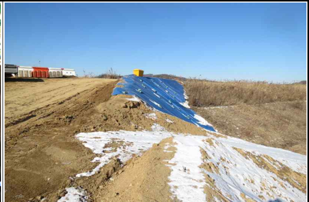
현장 진입부 인접법면 보호덮개 설치 현황
