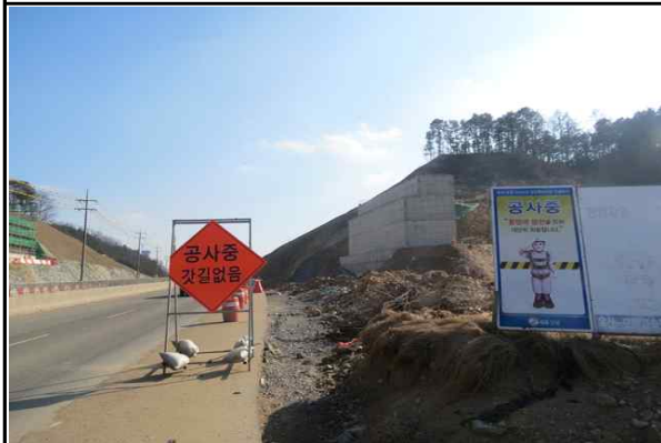
인접도로 주변 공사안내간판 설치 현황
