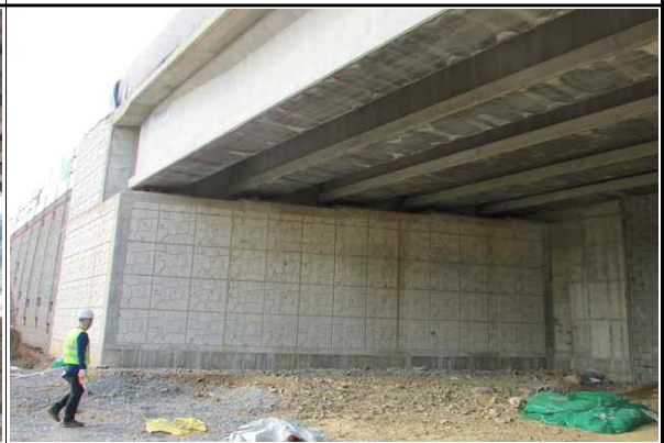
교대 A1(오창방향) 시공 전경 (2016.04.27)
