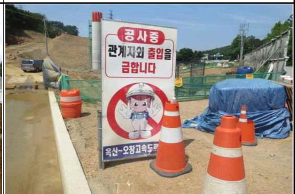
현장 출입구 공사 안내간판 설치상태 양호
