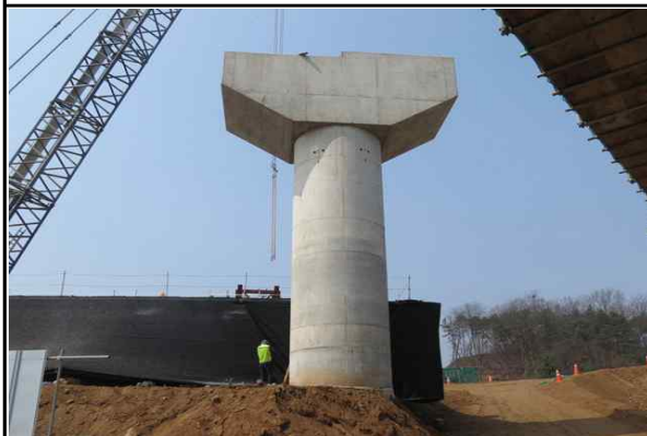
교각 P1 시공 전경 (2017.01.03)
