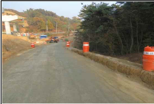
현장내 안전시설(PE드럼) 설치상태 양호
