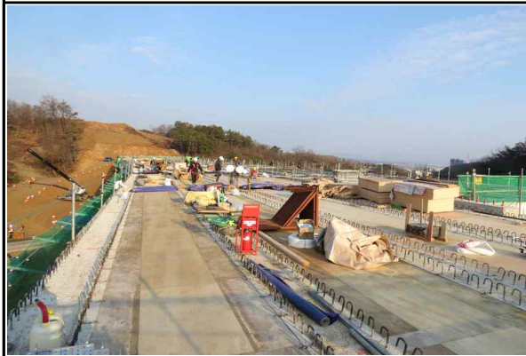
바닥판 거푸집 설치 현황 (2015.12.11)
