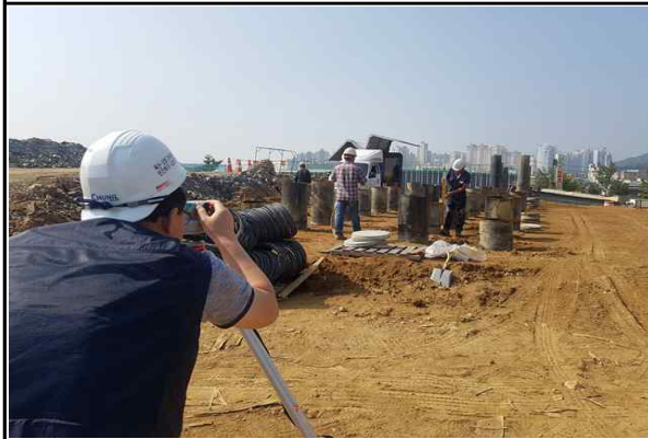
교대 A2 매입강관말뚝 검측 현황① (2016.09.24)
