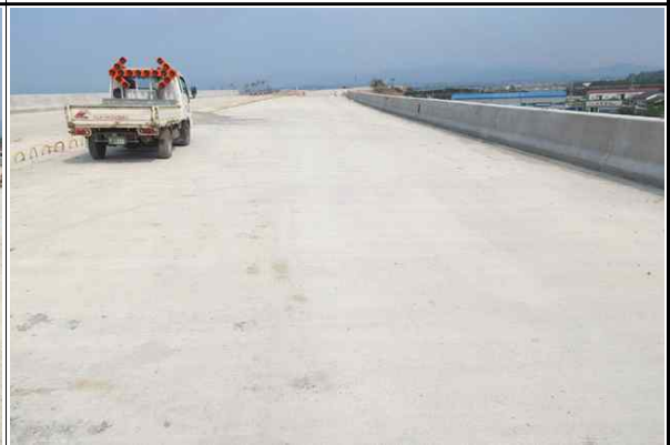
상부슬래브(오창방향) 시공 전경 (2017.06.21)
