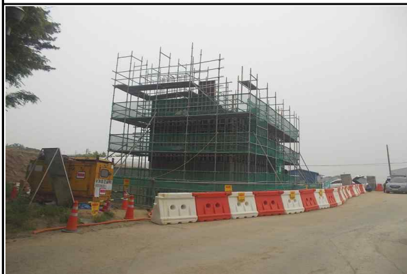
교대 A2 시공 현황(15.05.15)
