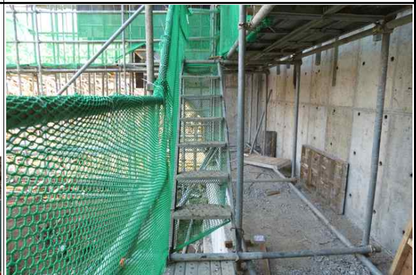
교대 A2 가설계단 설치 및 고정상태 양호②
