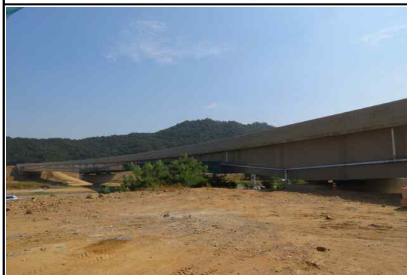
상부(S1~S3) 시공 전경 (2017.09.26)
