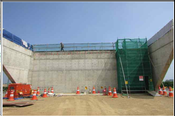
교대 A1 시공 전경② (2016.06.13)
