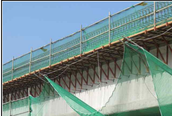
바닥판 캔틸레버부 거푸집 설치 현황
