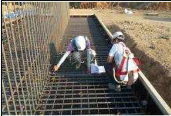
교대 A1 기초(옥산) 철근배근간격 확인 전경(2015.08.27)
