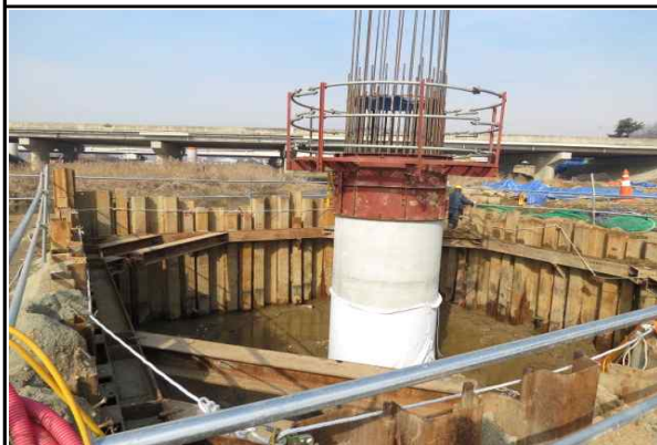
교각 P2 구체 시공 현황(15.02.03)
