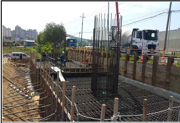
교각 P1 기초 철근배근 시공 현황 (2016.05.16)
