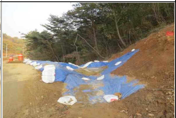
침사지 설치 현황
