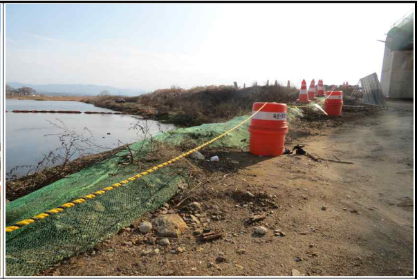
현장내 안전시설 설치 현황②
