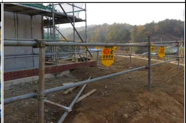
현장내 안전난간 설치상태 양호
