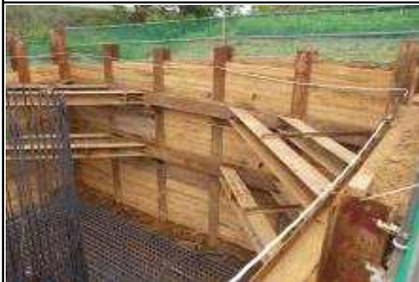
교각 P1 떠장 사보강재 및 토류판 설치 상태 양호
