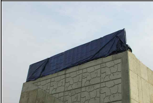
교대 A2 노출철근 보호덮개 설치 현황① (2017.01.12)
