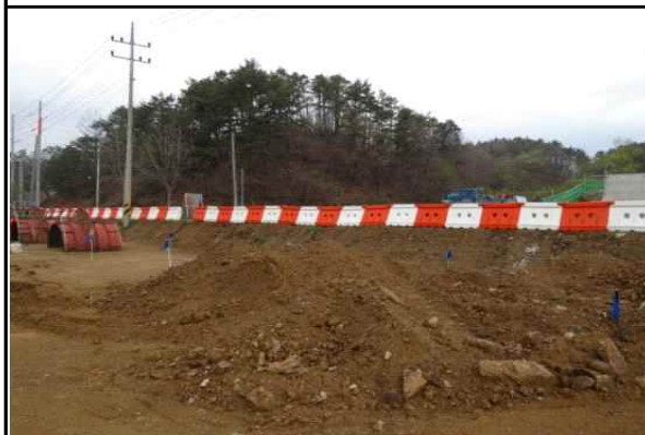
현장 인접도로 안전시설(PE방호벽) 설치상태 양호
