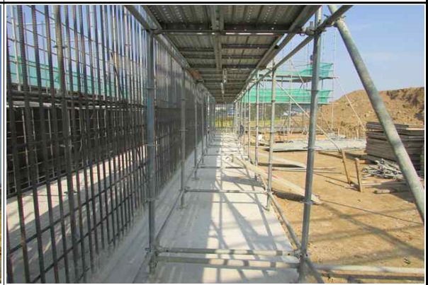
교대 A2 가설비계 설치 현황②
