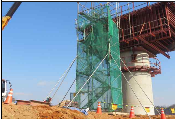
교각 P2 워킹타워 설치 상태①
