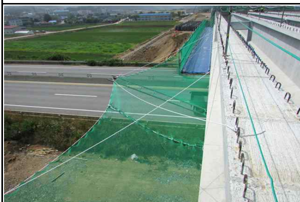
상부 추락방지망 설치 현황①
