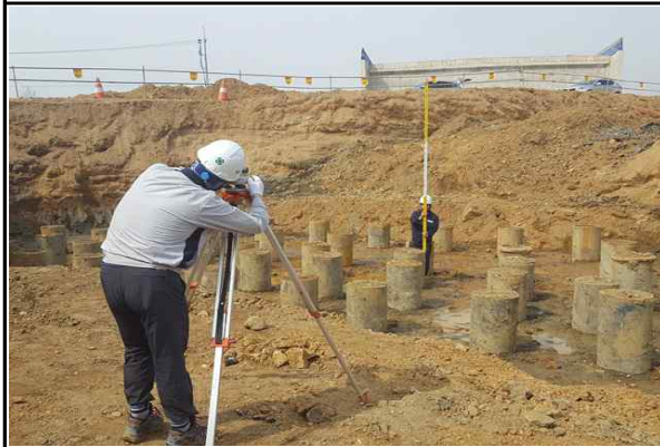
교대 A1 기초 강관말뚝 검측 현황 (2016.04.06)
