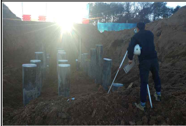
교대 A2 내부굴착강관말뚝 검측 현황① (2016.11.28)
