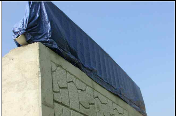
교대 A2 노출철근 보호덮개 설치 현황 (2016.06.13)
