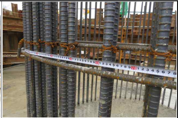
교각 P1(오창) 기둥부 철근배근 간격 확인 (2015.04.07)
