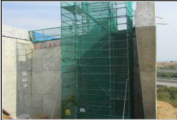
교대 A2 위킹타워 설치 현황
