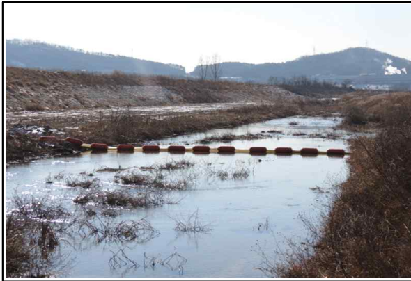
용두천내 오탁방지막 설치 현황
