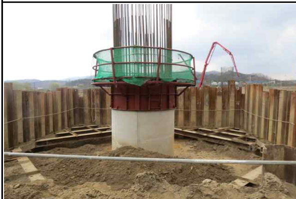
교각 P3(오창) 시공 현황 (2015.04.07)
