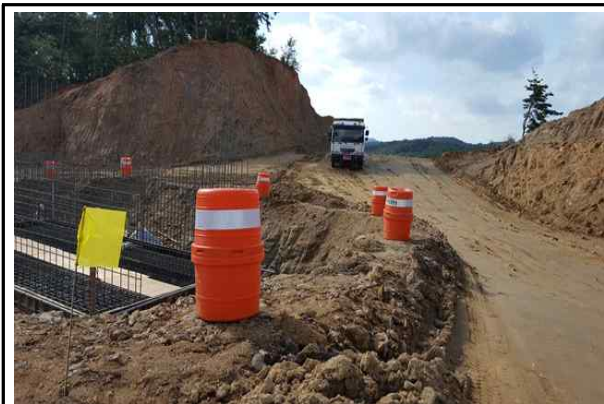
현장내 안전시설 설치 현황
