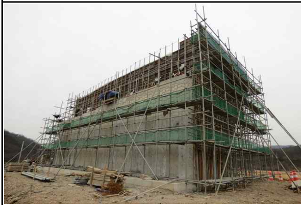
교대 A1 거푸집 및 가설비계 설치 현황①
