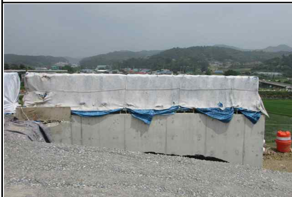
노출철근 보호덮개 설치 현황 (2016.06.13)
