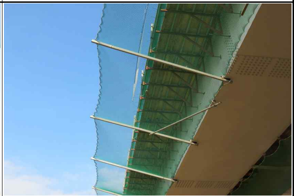
상부 추락방지망 설치 현황
