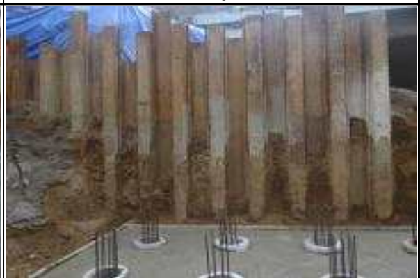
교각 P1 가시설(쉬트파일) 설치 현황
