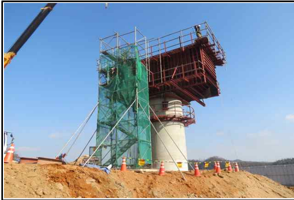
교각 P2 시공 전경 (2017.02.06)
