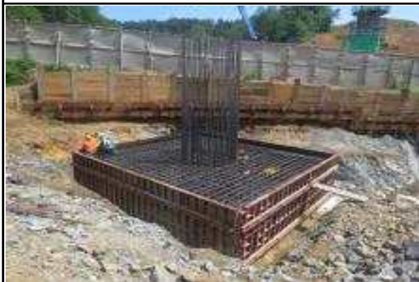
교각 P2 기초(옥산) 시공 현황 (2015.06.29)
