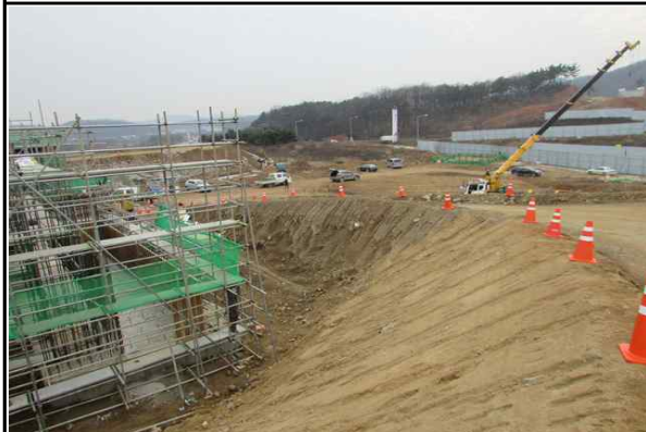
현장내 안전시설 설치 현황
