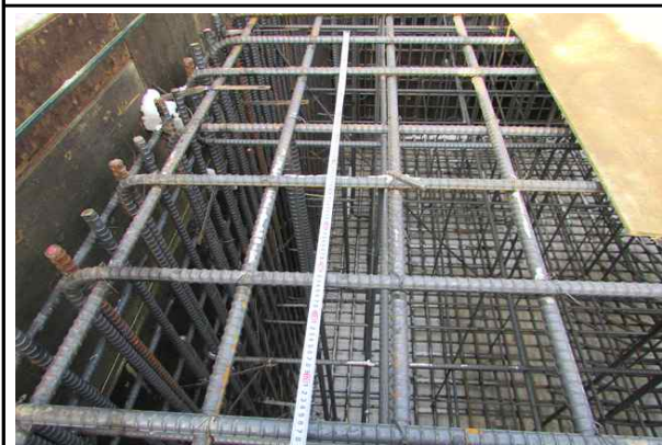
교각 P2 기초 철근배근간격 확인② (2016.05.16)
