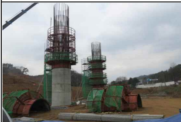
교각 기둥부 강제거푸집 설치 현황
