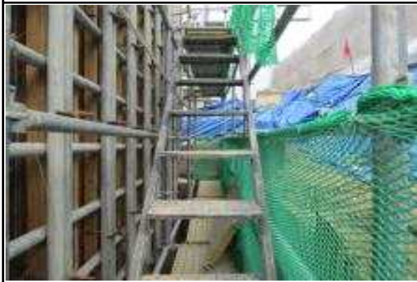
교대 A1 가설계단 설치 상태 양호
