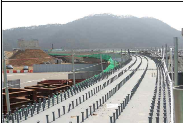
상부공 작업을 위한 안전시설 설치 현황
