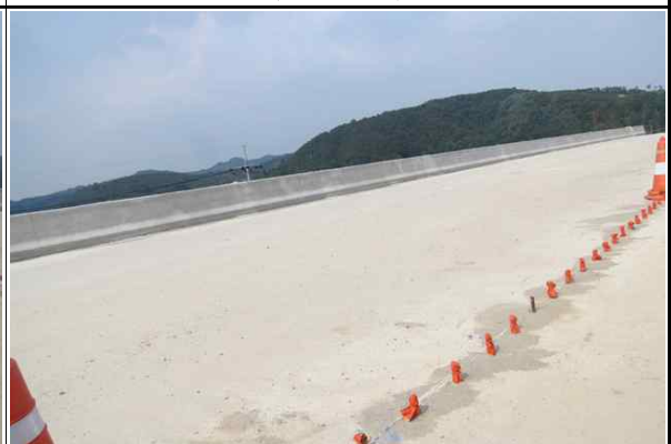
옥산방향 상부슬래브 및 방호벽 시공 전경 (2017.06.21)
