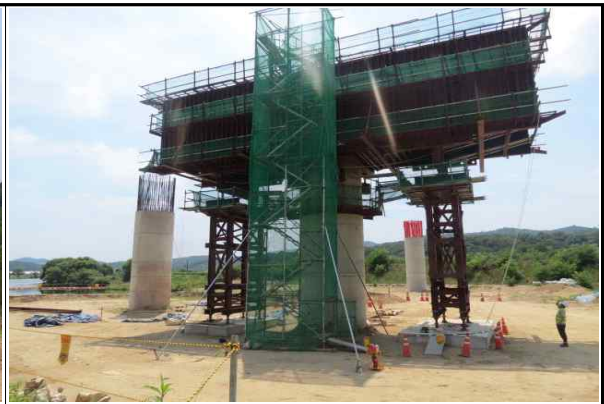
교각 P2(양방향) 시공 현황 (2015.06.29)
