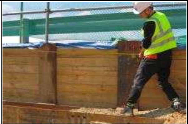
교각 P8 가시설 H-Pile+토류판 시공 상태
