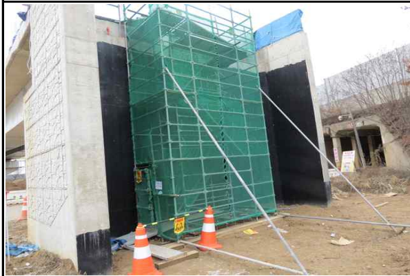
교대 A2 워킹타워 설치 현황
