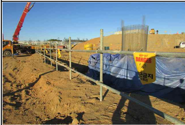
교각 P1 기초 작업장 주변 추락방지를 위한 안전휀스 설치 현황
