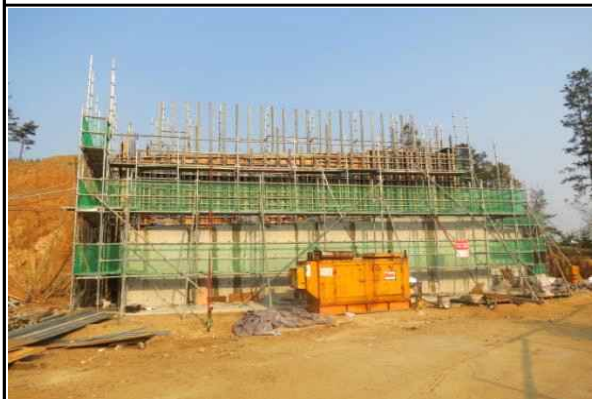
교대 A2 옥산방향 시공 현황 (2015.11.03)
