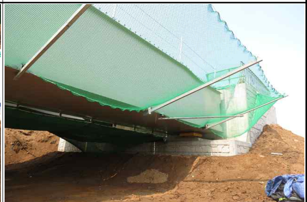
교대 A1 시공 전경 (2017.04.07)
