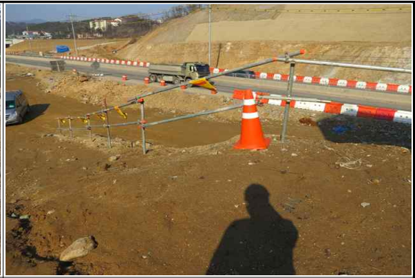
교대 A1 진입로 안전난간 설치 현황②
