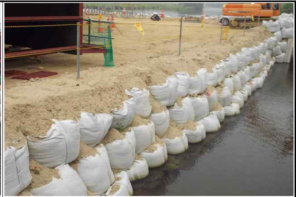
마대쌓기 시공 상태 양호
