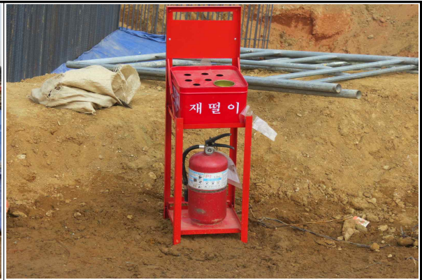
현장내 소화기 배치 현황
