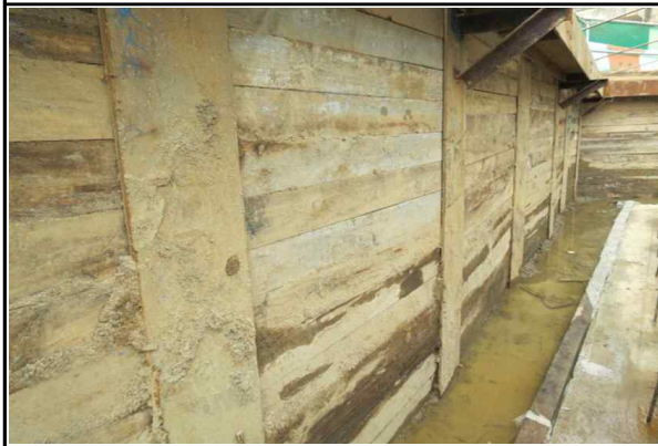
H-Pile 토류판 설치 상태 양호
