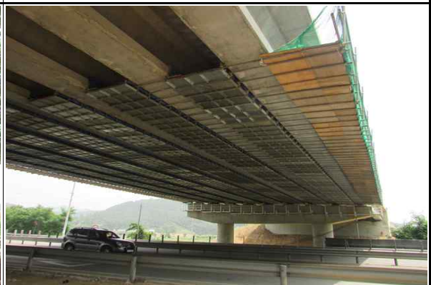
추락방지시설 설치 및 고정상태 양호
