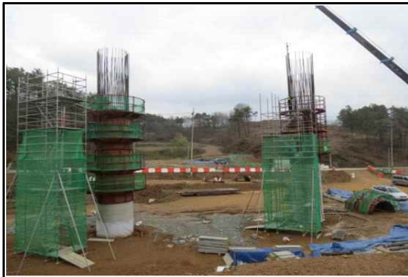
교각 P1 시공 현황① (2015.04.07)
