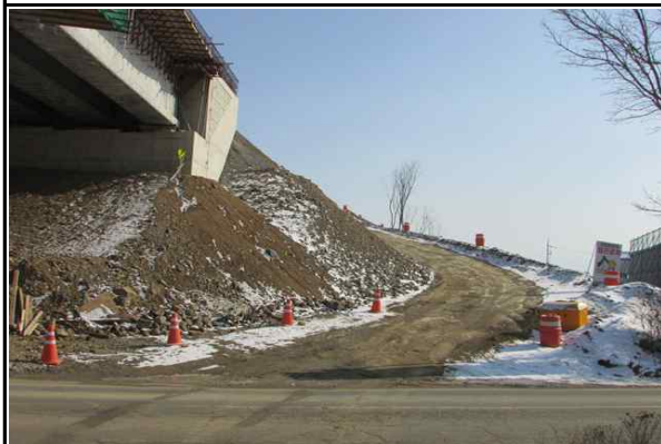
현장내 안전시설(라바콘, 안전간판 등) 설치 현황
