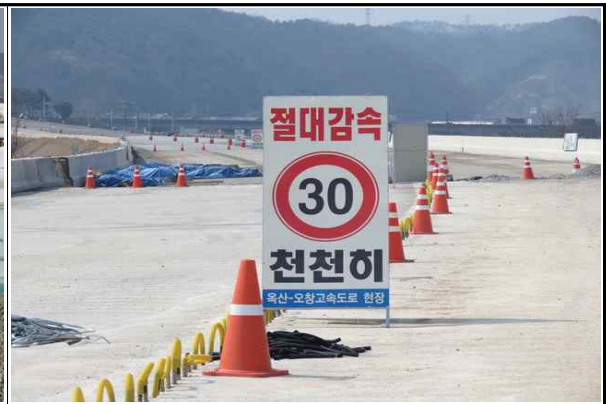
현장내 안전시설(라파콘, 안전간판) 설치 현황
