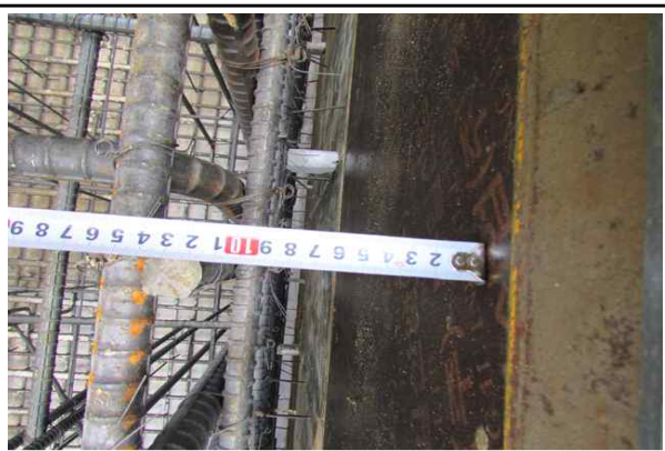
교각 P2 기초 피복두께 확인 (2016.05.16)
