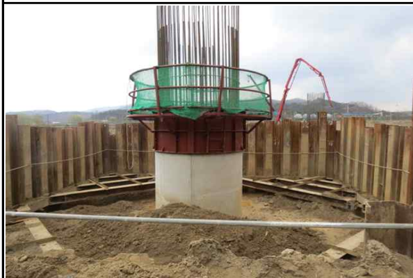
교각 P3(오창) 시공 현황 (2015.04.07)
