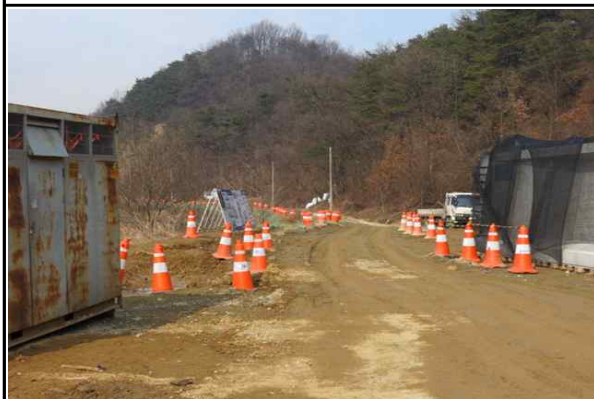
현장 진입도로 안전시설 설치 현황
