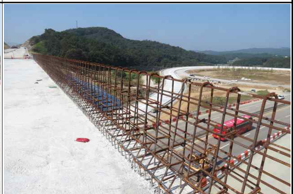
상부 방호벽 철근배근 현황② (2016.12.13)
