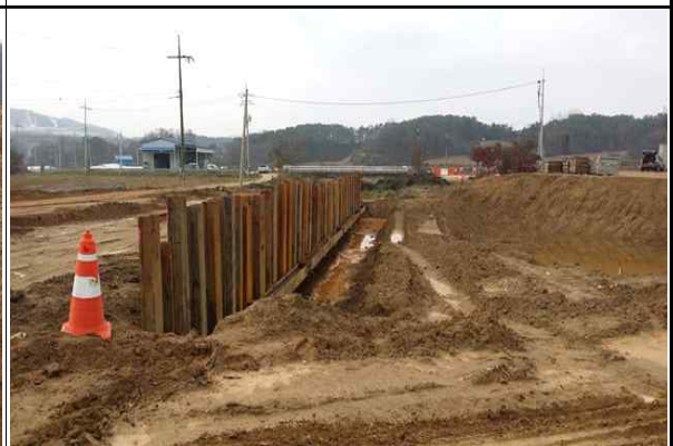
흙막이(쉴트파일) 가시설 시공 현황②
