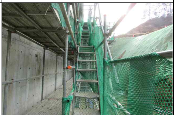
교대 A1 가설계단 설치 및 고정상태 양호
