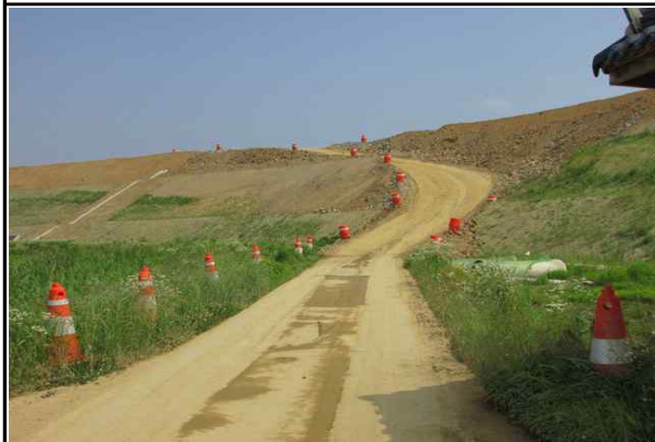
현장내 안전시설 설치 현황①
