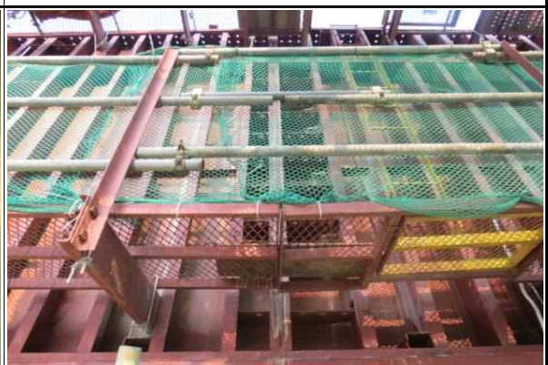
강제거푸집 설치·고정 상태 양호②
