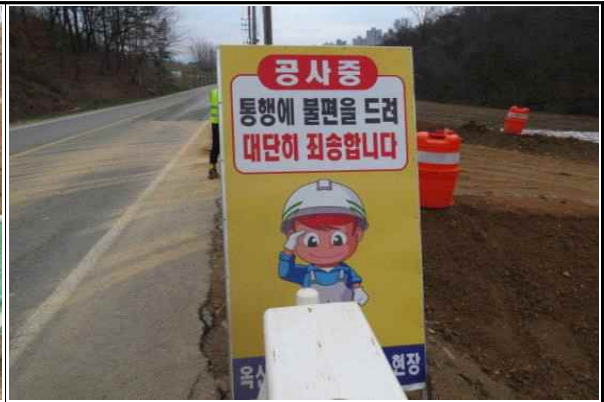
현장 인접도로 공사안내 간판 설치상태 양호
