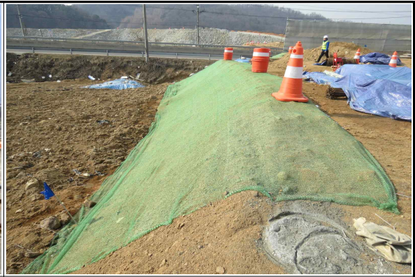
교대 A2 인접법면 보호상태 양호
