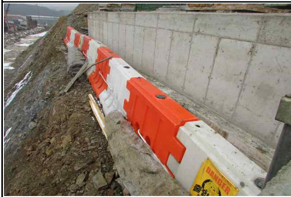
교대 A2 작업장 주변 안전시설(PE방호벽) 설치 현황①
