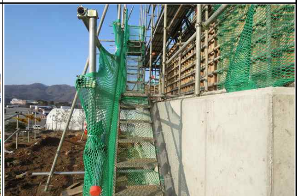
교대 A1 가설계단 설치 상태 양호
