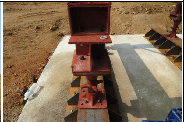
가설벤트 볼트 및 집합부 체결상태 양호
