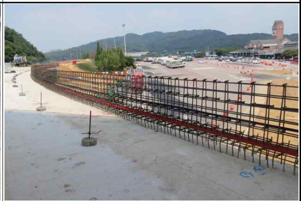
방호벽 철근배근 현황 (2017.06.21)
