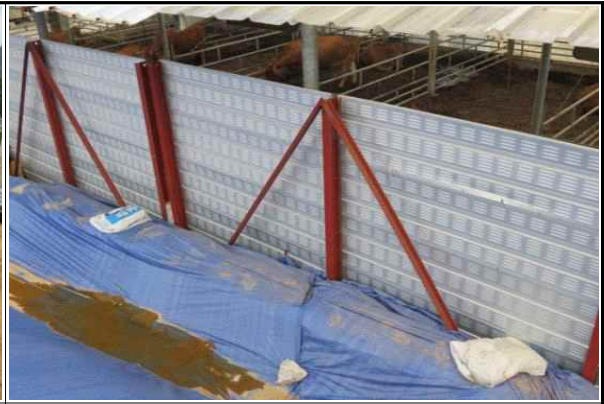
교대 A1측 인접건물 안전휰스 설치상태 양호
