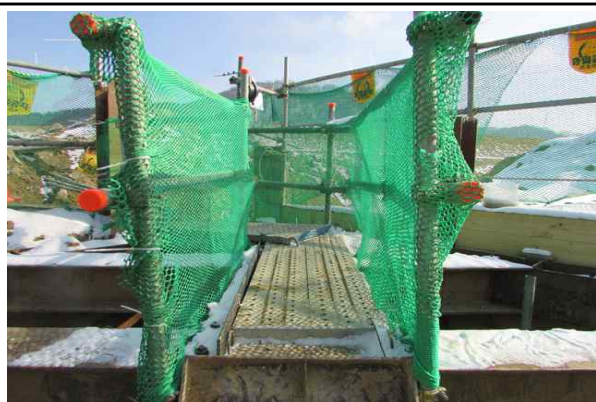
교각 P2 기초 진입을 위한 가설통로 설치 상태②
