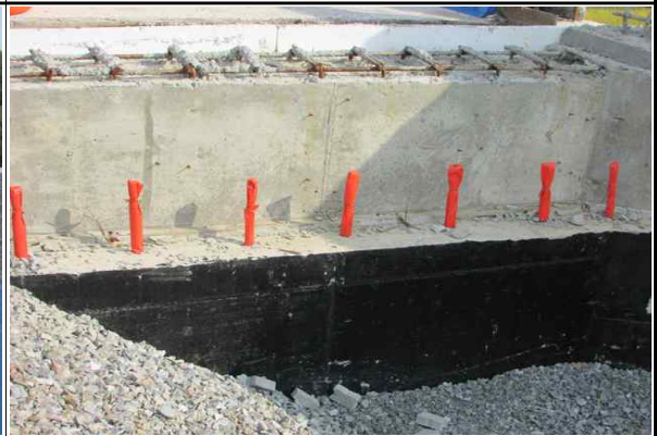
교대 파라펫 노출철근 보호덮개 설치 현황 (2016.10.11)
