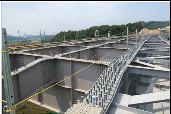
상부공 작업을 위한 안전시설 설치 현황①
