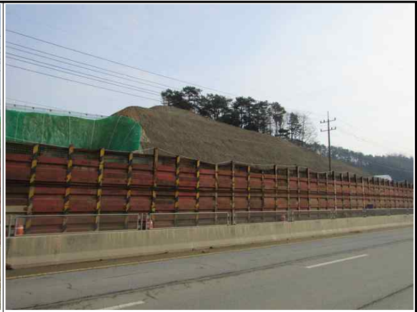
현장 인접도로 주변 흙막이 가시설 시공 현황②
