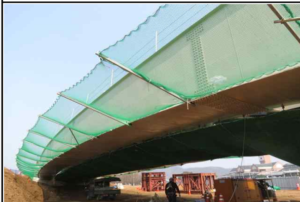
상부 추락방지망 설치 현황①
