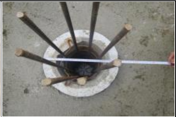
교각 P1 매입PHC말뚝 제원 실측
