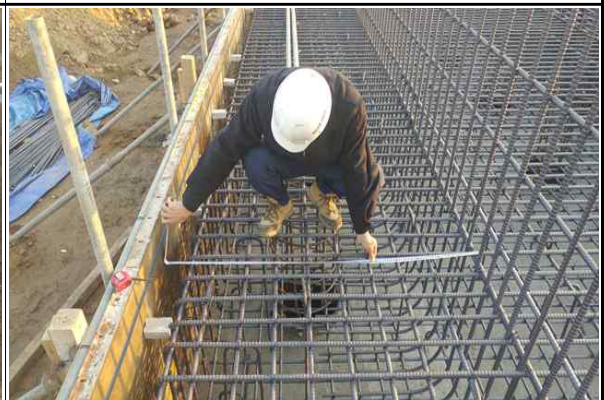
교대 A1 기초 철근배근간격 및 피복두께 확인(2016.11.25)
