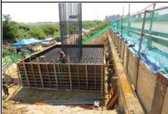
교각 P8 기초철근배근 현황
