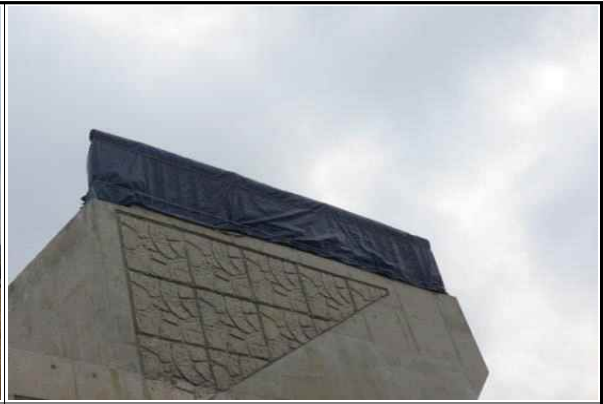
교대 A1 노출철근 보호덮개 설치현황(15.04.07)
