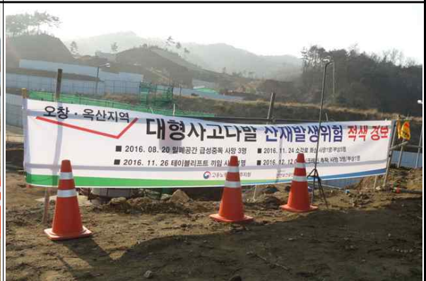
현장내 안전현수막 설치 현황
