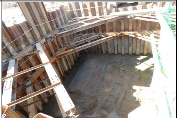
교각 P2(오창) 기초 가시설 설치 및 시공현황(2015.03.04)
