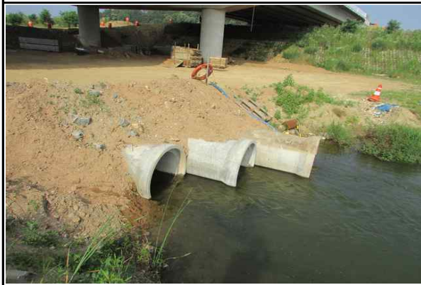
현장내 임시 배수관 설치 현황 (하천 배수상태 양호)
