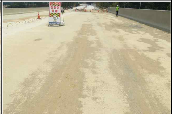
상부슬래브(오창방향) 시공 현황 (2017.06.21)
