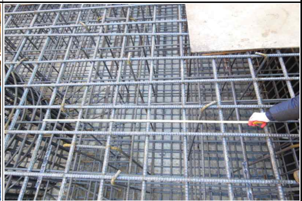
교각 P3 기초 철근배근간격 확인 전경
