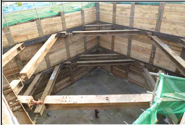
교각 P2 흙막이 가시설 시공 현황①
