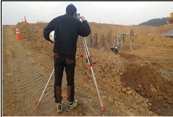
교대 A1 내부굴착강관말뚝 검측 현황① (2016.11.14)
