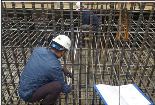
교대 A1 기초 철근배근간격 실측 현황② (2016.11.01)
