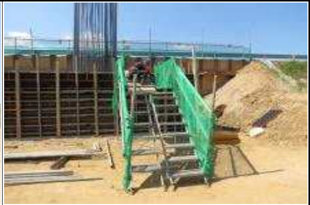
교각 P8 가설계단 설치 상태
