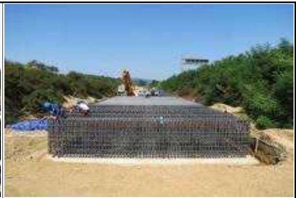
교각 P1 기초 시공 전경②
