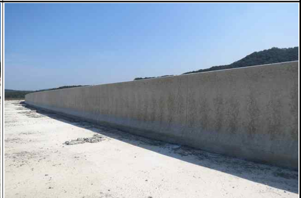
상부 방호벽 일부 콘크리트 타설 완료 (2017.09.26)
