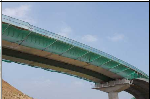
상부 추락방지망 설치 현황②
