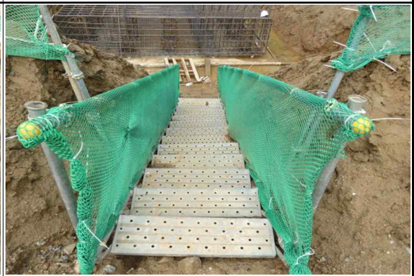
기초 진입 가설계단 설치 상태 양호
