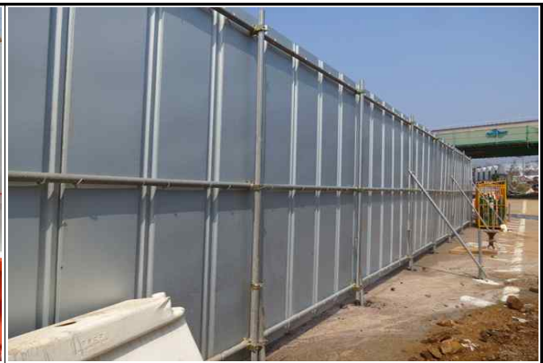
현장 인접도로 주변 안전휀스 설치 현황②
