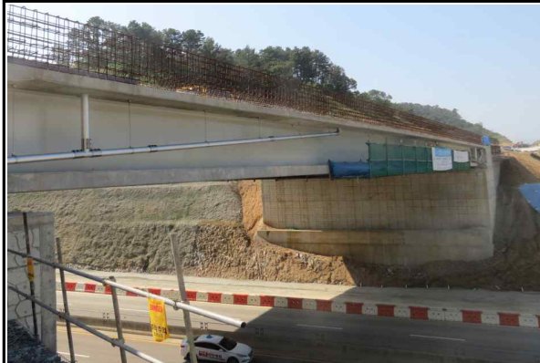
상부 낙하물 방지지설 설치 현황①
