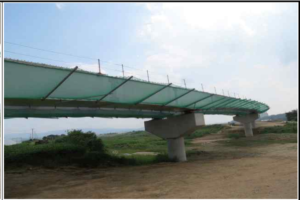
거더거치 시공 현황 (2015.09.04)
