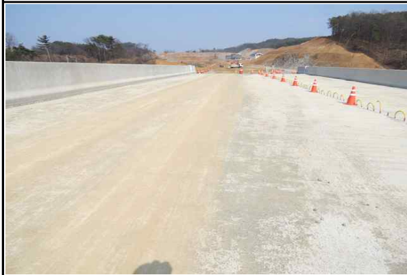
상부슬래브 시공 현황① (2017.04.07)
