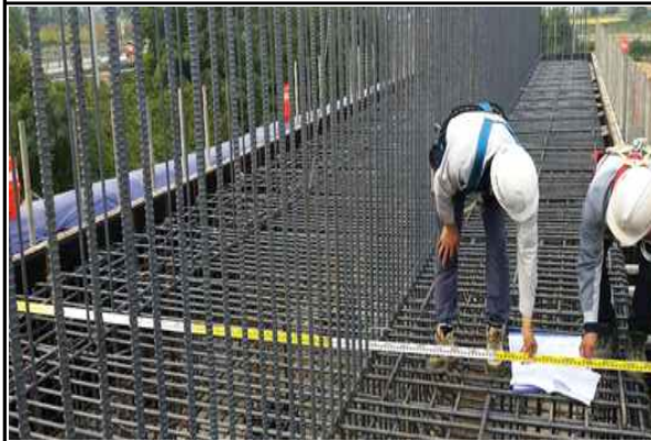
교대 A2 기초 콘크리트 타설 전 제원실측현황 (2015.10.06)
