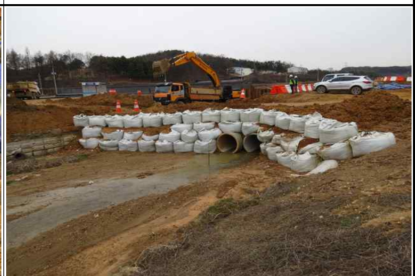
현장내 가설도로 및 임시배수관 시공 현황
