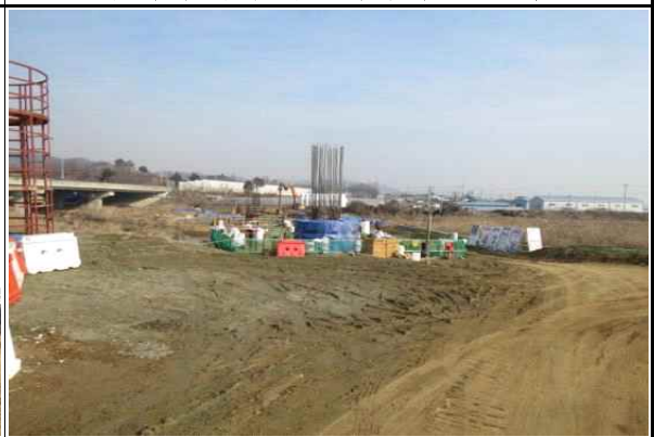
교각 P1 구체 시공 현황(15.02.03)
