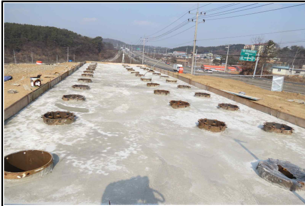
교대 A1 기초 말뚝 시공 전경 (2016.02.04)
