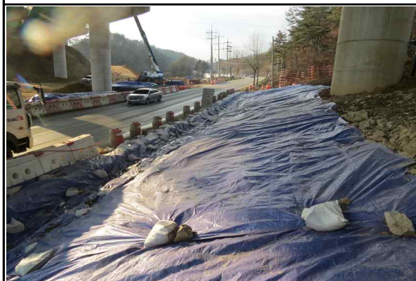
교각 P3 인접법면 보호덮개 설치상태 양호
