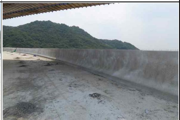
상부 방호벽 콘크리트 외관상태 양호 (2017.06.21)
