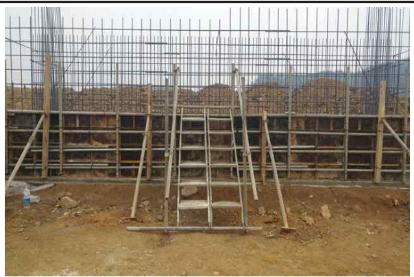
교대 A2 가설계단 설치 상태
