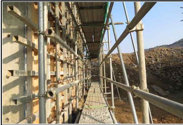
교대 A1 가설통로 설치 상태 양호
