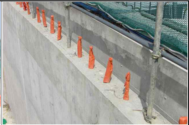
교대 A1 노출철근 보호덮개 설치 현황② (2016.06.13)
