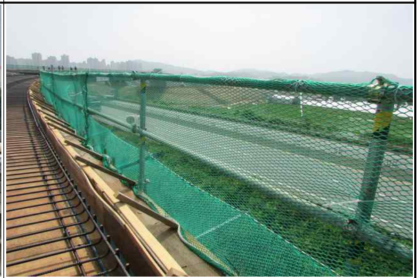
상부 안전난간 설치상태 양호①
