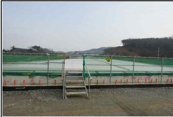
서오창IC Ramp-A1교 상부 시공 전경 (2016.12.13)
