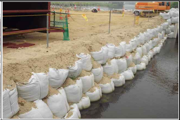
마대쌓기 시공 상태 양호
