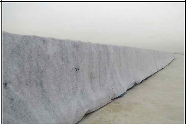
상부 방호벽 노출철근 보호덮개 설치 현황 (2016.03.08)
