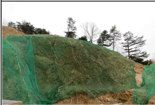
교대 A2 인접 법면 보호망 설치 현황
