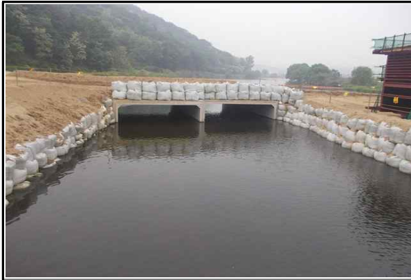
현장내 PC BOX(임시 배수관) 시공 현황
