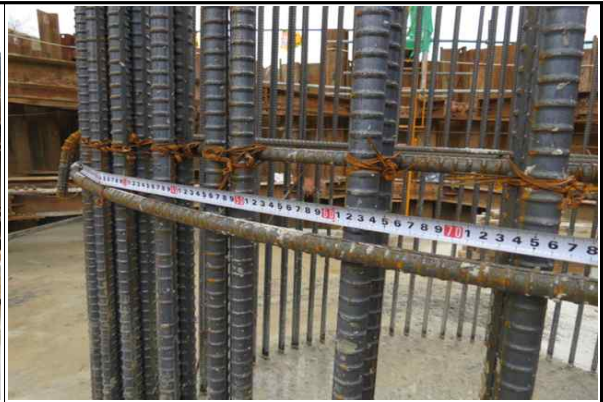
교각 P1(오창) 기둥부 철근배근 간격 확인 (2015.04.07)
