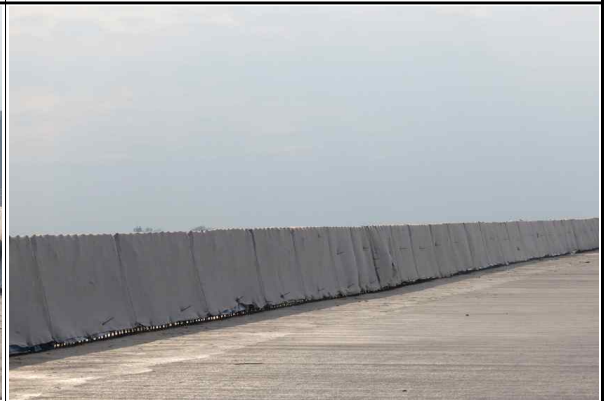
상부 노출철근 보호덮개 설치 현황 (2015.11.03)
