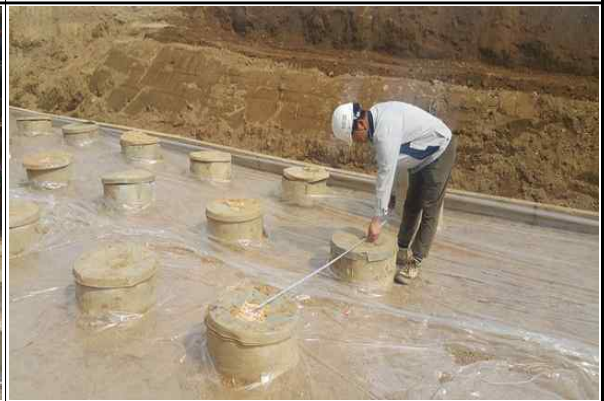
교각 P1 매입PHC말뚝 간격 및 제원 실측 (2016.04.26)
