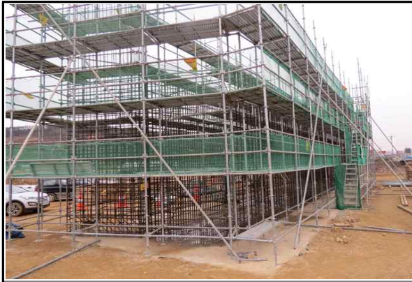
교대 A1 가설비계 설치 현황①
