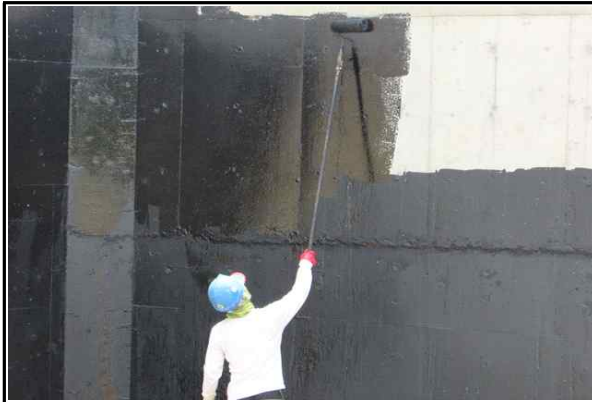
교대 A2 되메우기부 방수페인트 시공 현황 (2016.06.13)
