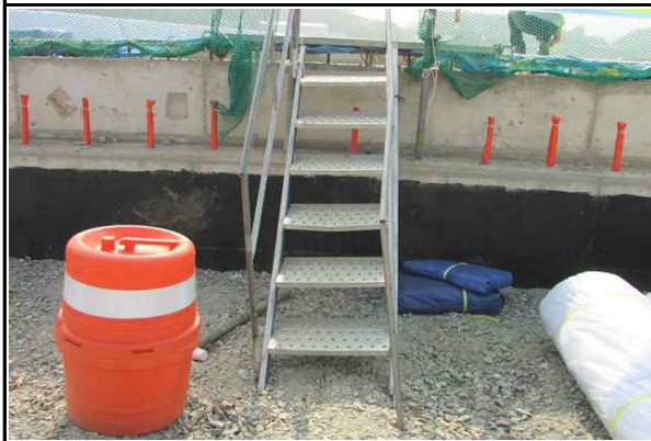
상부 진입을 위한 가설계단 설치 현황①
