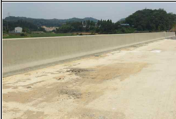
방호벽 시공 현황① (2017.06.21)
