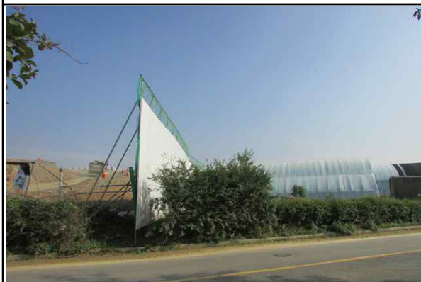
교대 A2 공사현장 인접해 있는 비닐하우스 주변 안전휀스 설치 현황
