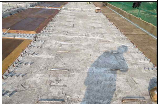
Half-Deck 시공 상태 양호 (2015.11.03)
